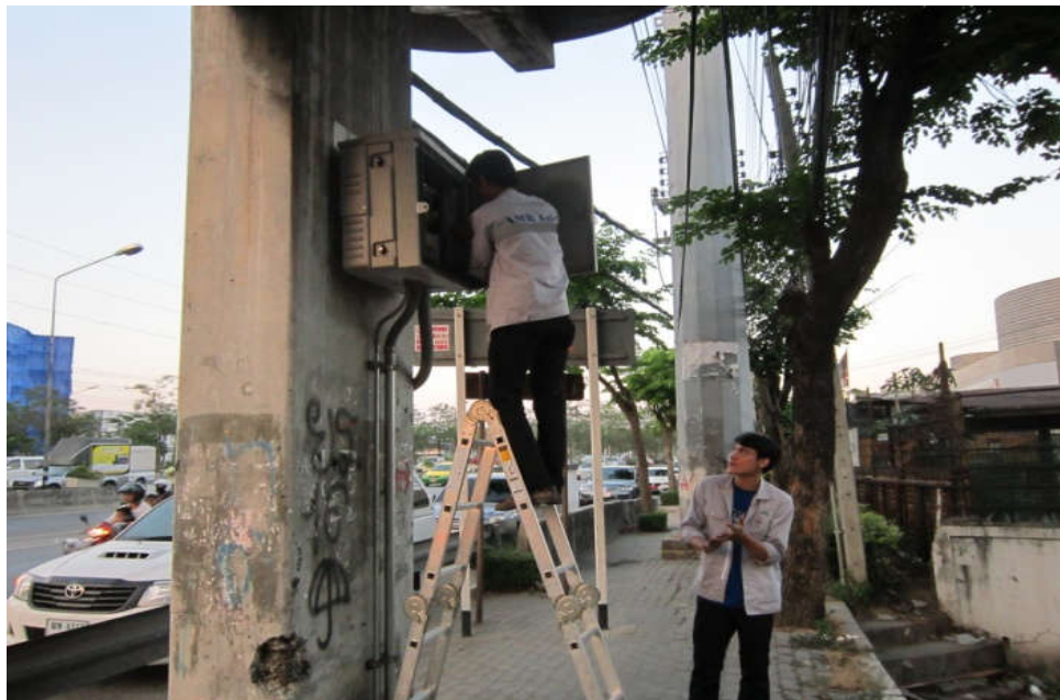
รูปที่ 4.8 การเช็คอุปกรณ์ในตู้ DVR บนสะพานลอย
