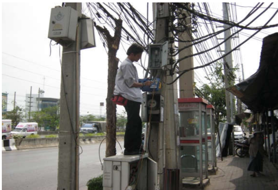
รูปที่ 4.19 การวัดค่ากราวด์ตู้สวิตซ์ตัดตอนบนสะพานลอย
