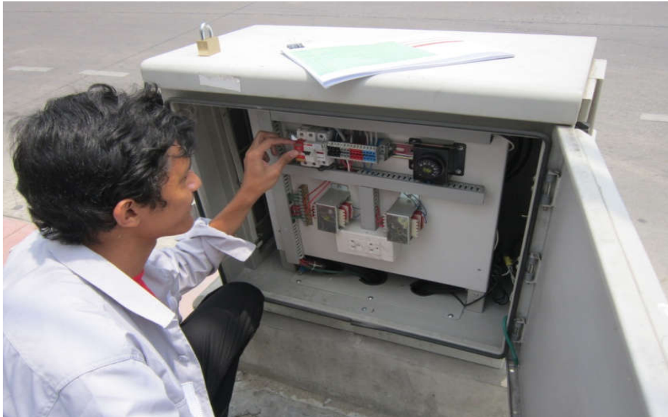
รูปที่ 4.7 การเช็คอุปกรณ์ในตู้ DVR บนคอนกรีต
