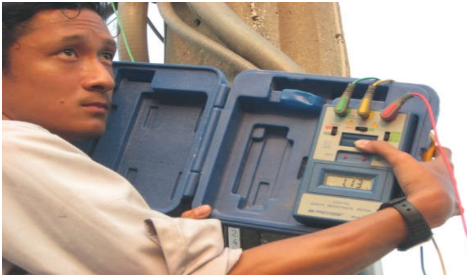
รูปที่ 4.21 ค่าที่ได้จากการวัดตู้สวิตซ์ตัดตอน
