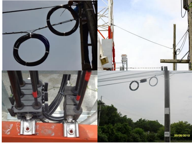
รูปที่ 4.1 แสดงการติดตั้งสายเคเบิลที่ถูกต้อง
