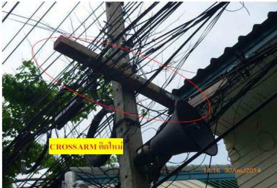
รูปหลังทำงาน ได้ทำการเปลี่ยน CROSSARM ใหม่แล้ว
