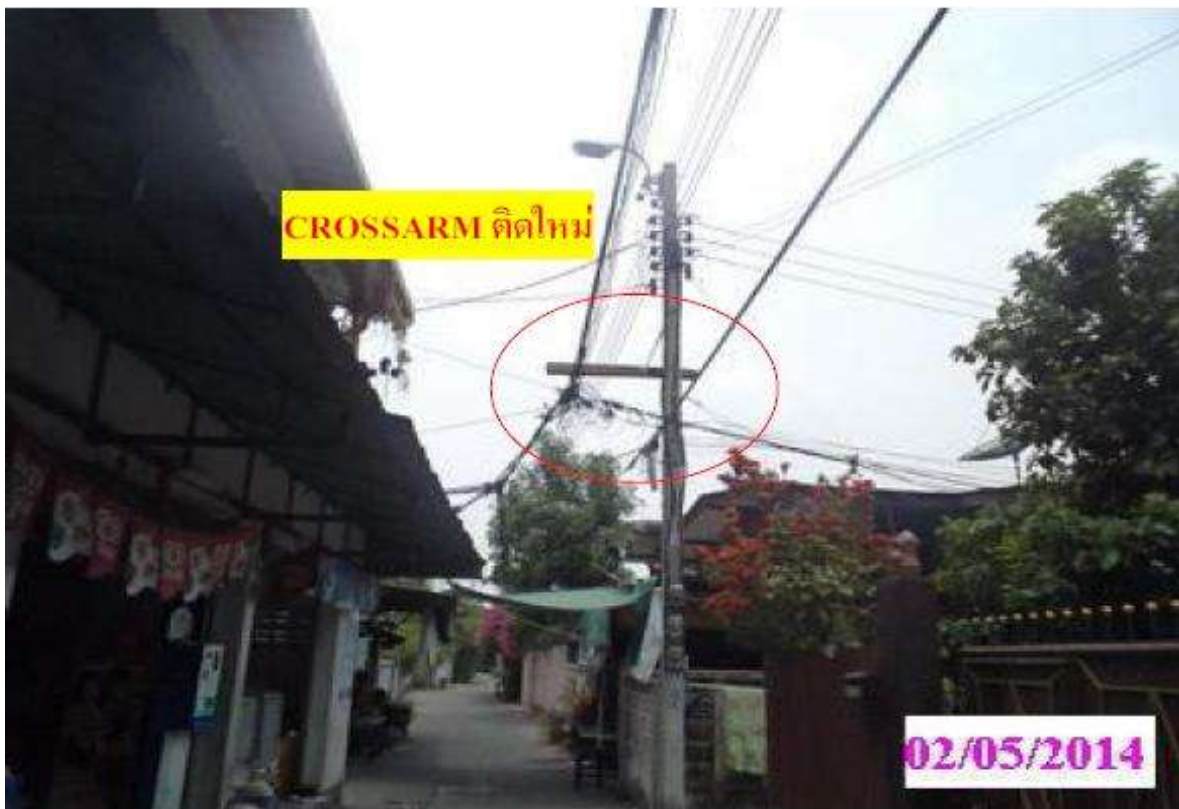
รูปหลังทำงาน ได้ทำการเปลี่ยน CROSSARM ใหม่แล้ว
