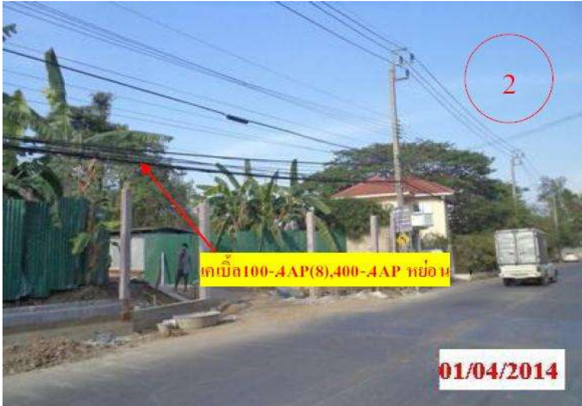
รูปก่อนทำงาน เคเบิลหย่อนก่อน จุด 2
