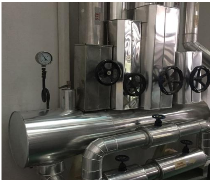
รูปที่ 4.26 การปรับปรุงจนวนท่อส่งไอน้ำ จุดที่ 3
