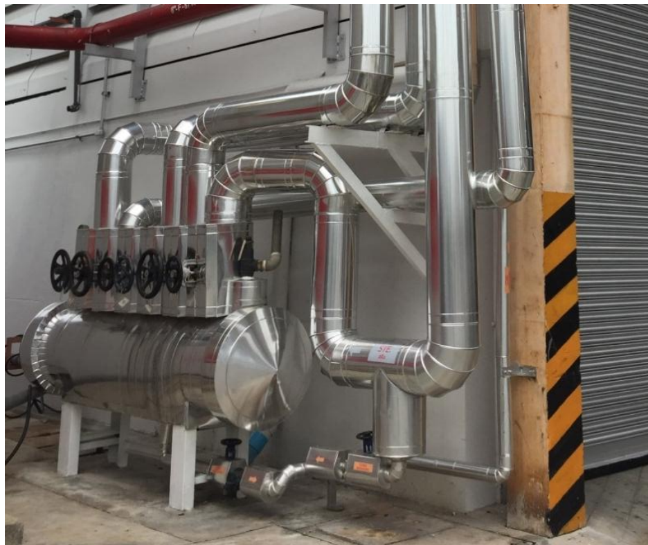
รูปที่ 4.19 การนำคอนเดนเสทกลับมาใช้ใหม่ จุดที่ 9
