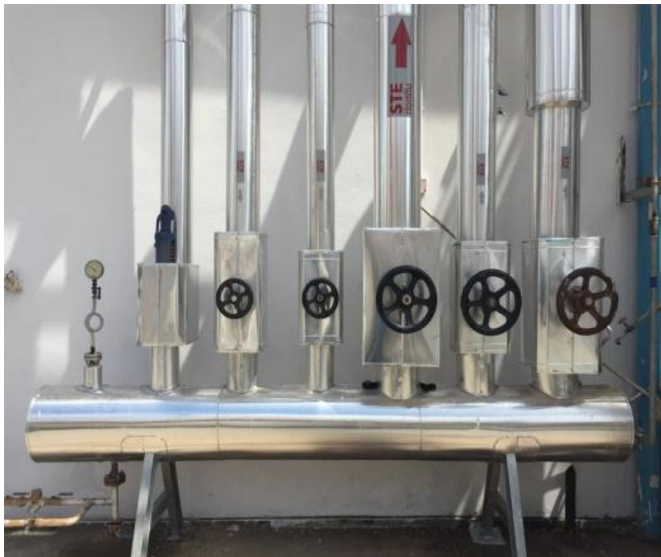
รูปที่ 4.24 การปรับปรุงฉนวนท่อส่งไอน้ำ จุดที่ 1
