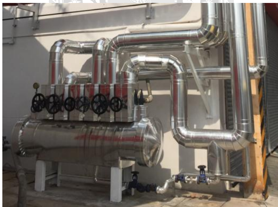
รูปที่ 4.25 การปรับปรุงฉนวนท่อส่งไอน้ำ จุดที่ 2
