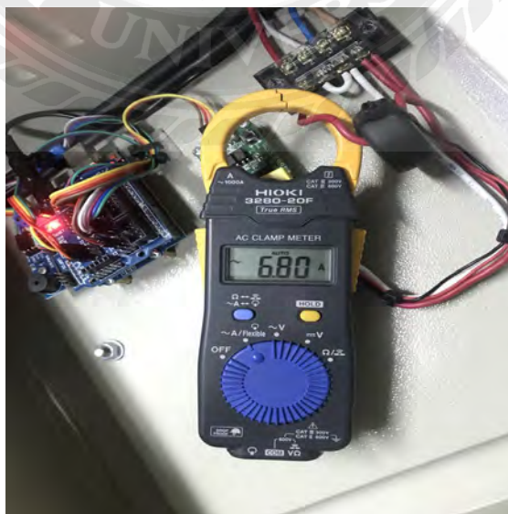
รูปที่ 4.10 การวัดค่ากระแสจาก Meter Module
