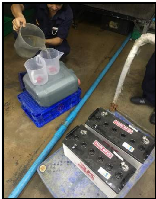
รูปที่ 8 เตรียมน้ำกรดสำหรับใช้เติมแบตเตอรี่
