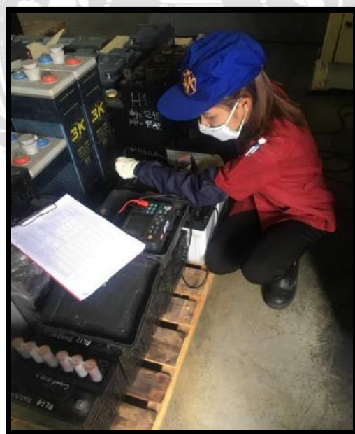
รูปที่ 11 เก็บค่าความต้านทานภายในแบตเตอรี่
