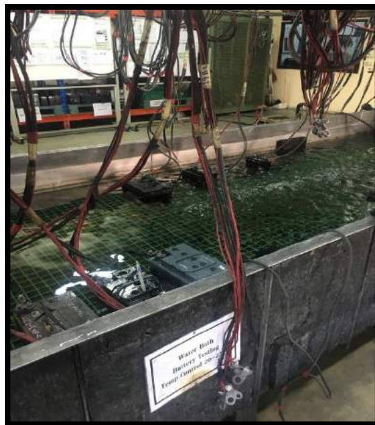
รูปที่ 6 อ่างควบคุมอุณหภูมิในการชาร์จแบตเตอรี่
