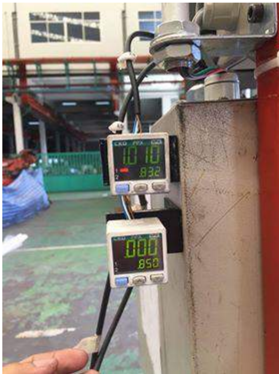
รูปที่ 4.12 การติดตั้งPressor Sensor
