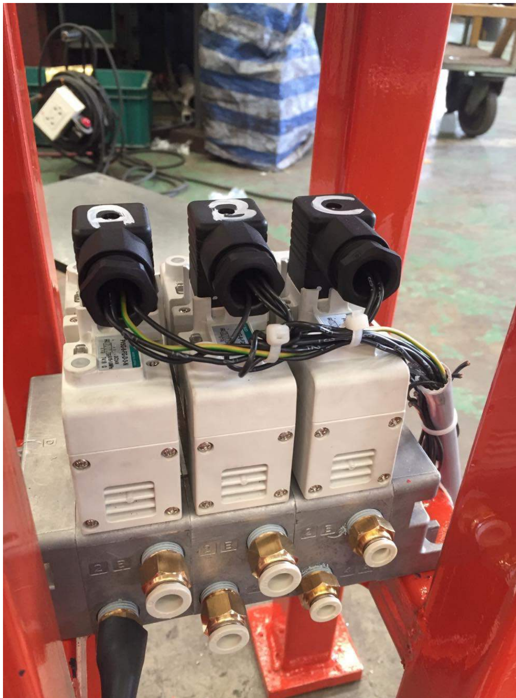
รูปที่ 4.5 ติดตั้งชุดโซลินอยด์ที่ประกอบและต่อสายไฟสำเร็จที่บริเวณข้างตั้งของเครื่องทดสอบ
