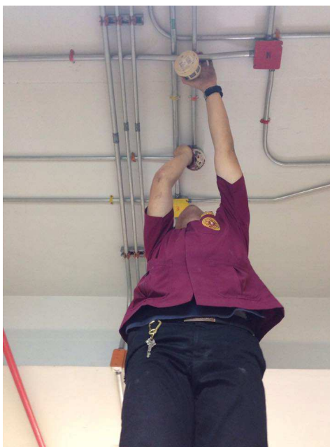
รูปที่ 3.8 ถอดเช็คทำความสะอาดฐานอุปกรณ์และเช็คขั้วสายไฟ
