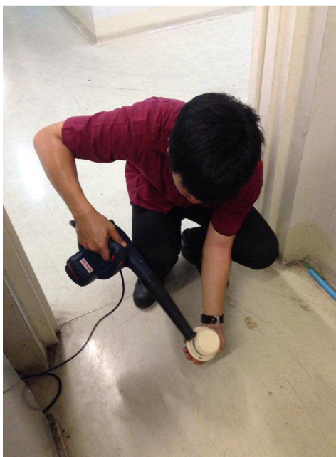
รูปที่ 3.9 ตรวจเช็คทำความสะอาด และเป่าฝุ่น
