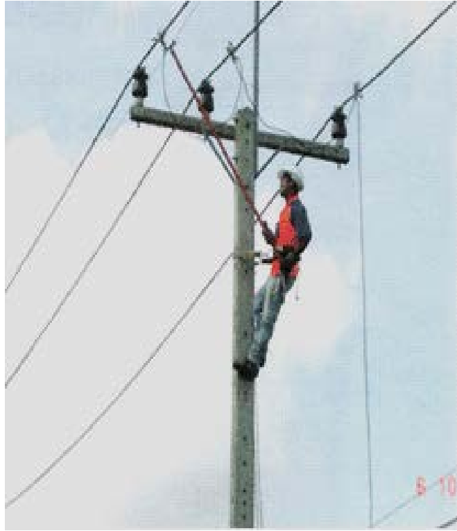
รูปที่ 2.16 แสดงภาพ(Short Grounding)
