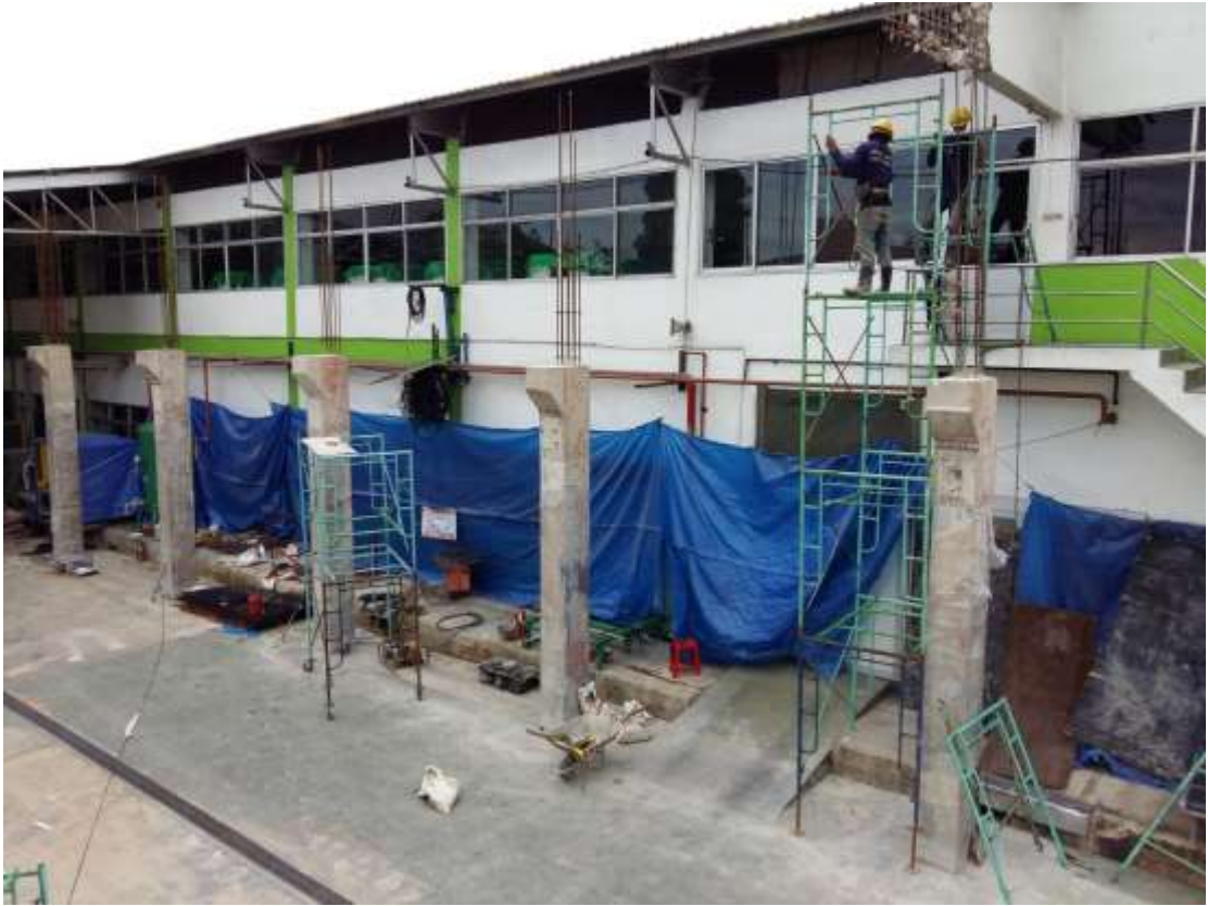
รูปที่ 4.18 หูช้างหลังจากถอดแบบออก
