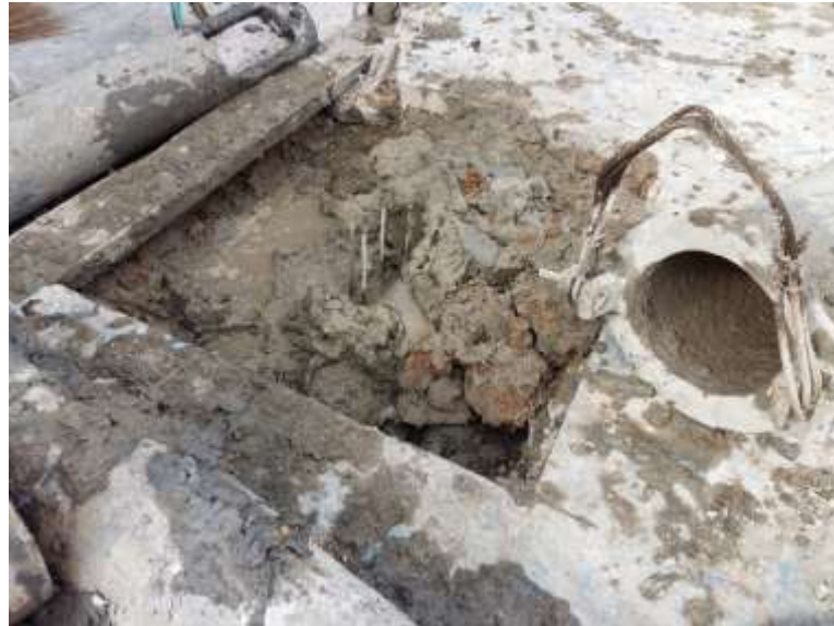
รูปที่ 4.5 ลักษณะของเสาเข็มเจาะหลังจากเทคอนกรีตเสร็จ หลังจากที่เทคอนกรีตแล้วเราจำเป็นต้องตัดเสาเข็มลงไปอีก 1 เมตร เพื่อที่จะได้เสาเข็มคุณภาพดี
