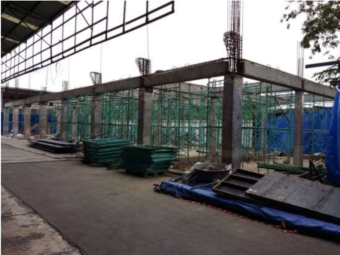
รูปที่ 4.16 การเสริมเหล็กโครงสร้างหุซัง
