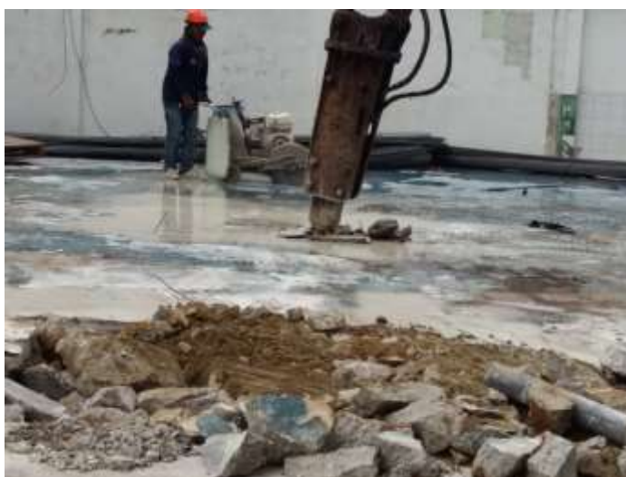
รูปที่ 4.1 การเปิดผิวหน้าพื้นเพื่อเตรียมเสาเข็มเจาะ
