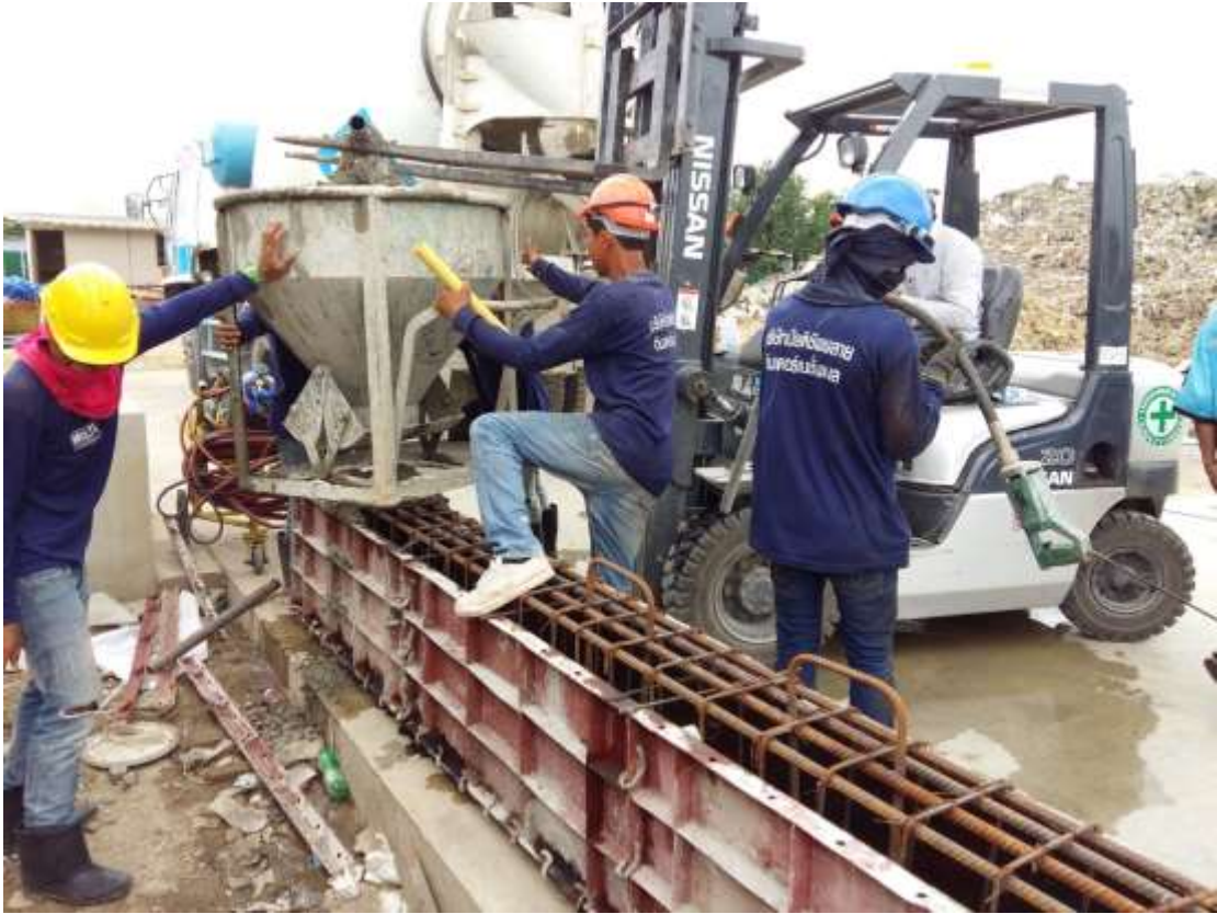
รูปที่ 4.22 การเทคาน Precast
