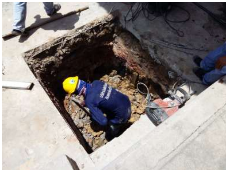
รูปที่ 4.6 การตัดหัวเสาเข็ม
