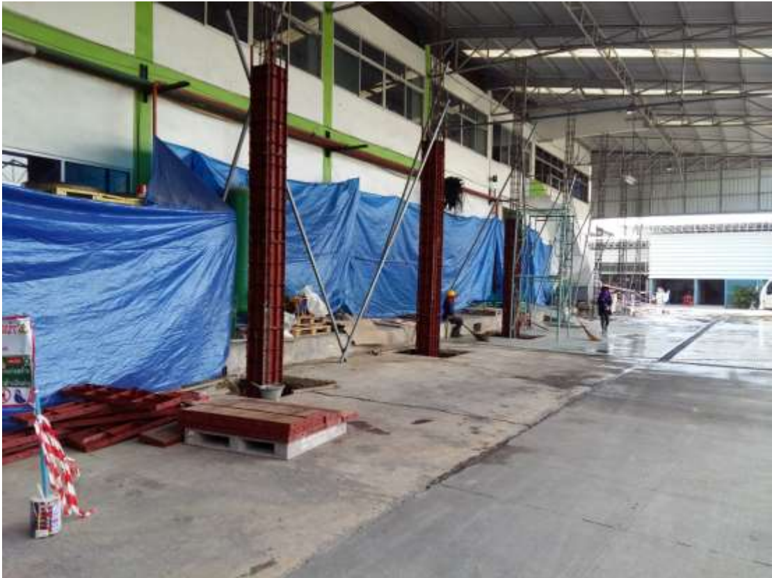
รูปที่ 4.11 การเข้าแบบเสา
