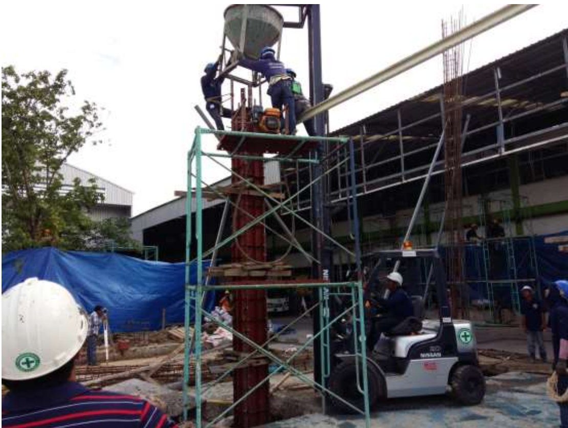
รูปที่ 4.12 การเทคอนกรีตเสา
