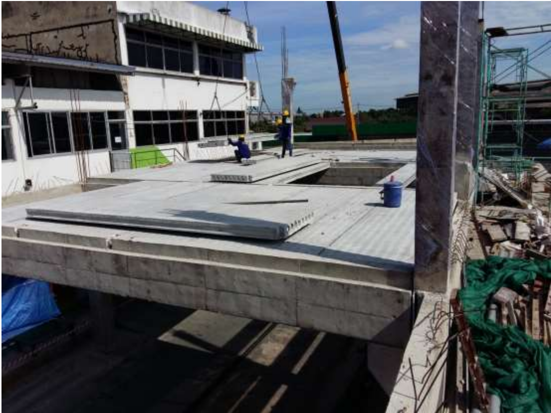
รูปที่ 4.27 ติดตั้งแผ่น Hollow Core
