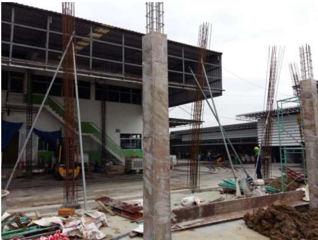
รูปที่ 4.14 การบ่มคอนกรีตเสาด้วยพลาสติก
