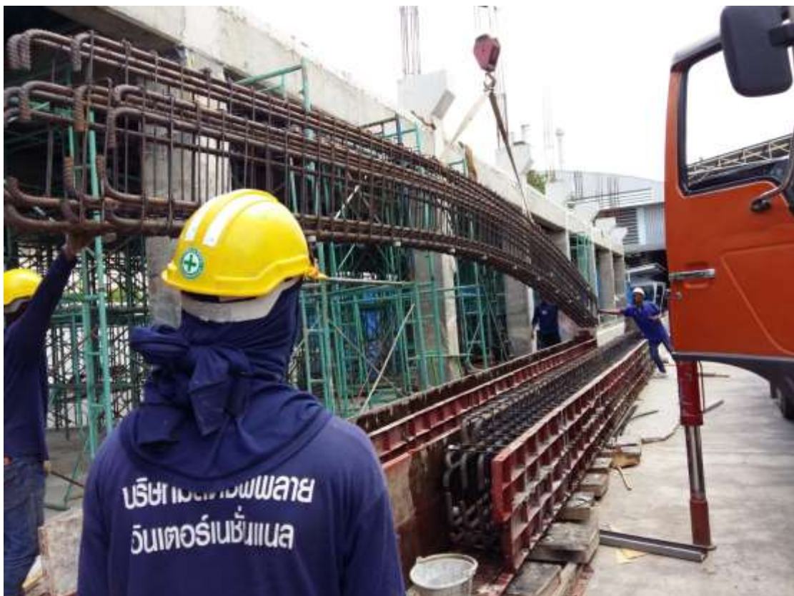
รูปที่ 4.21 เช้าแบบคาน Precast
