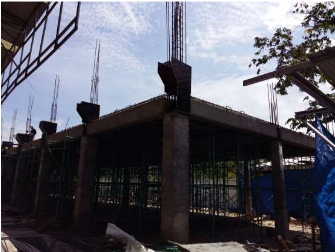
รูปที่ 4.17 การเข้าแบบหุซัง
