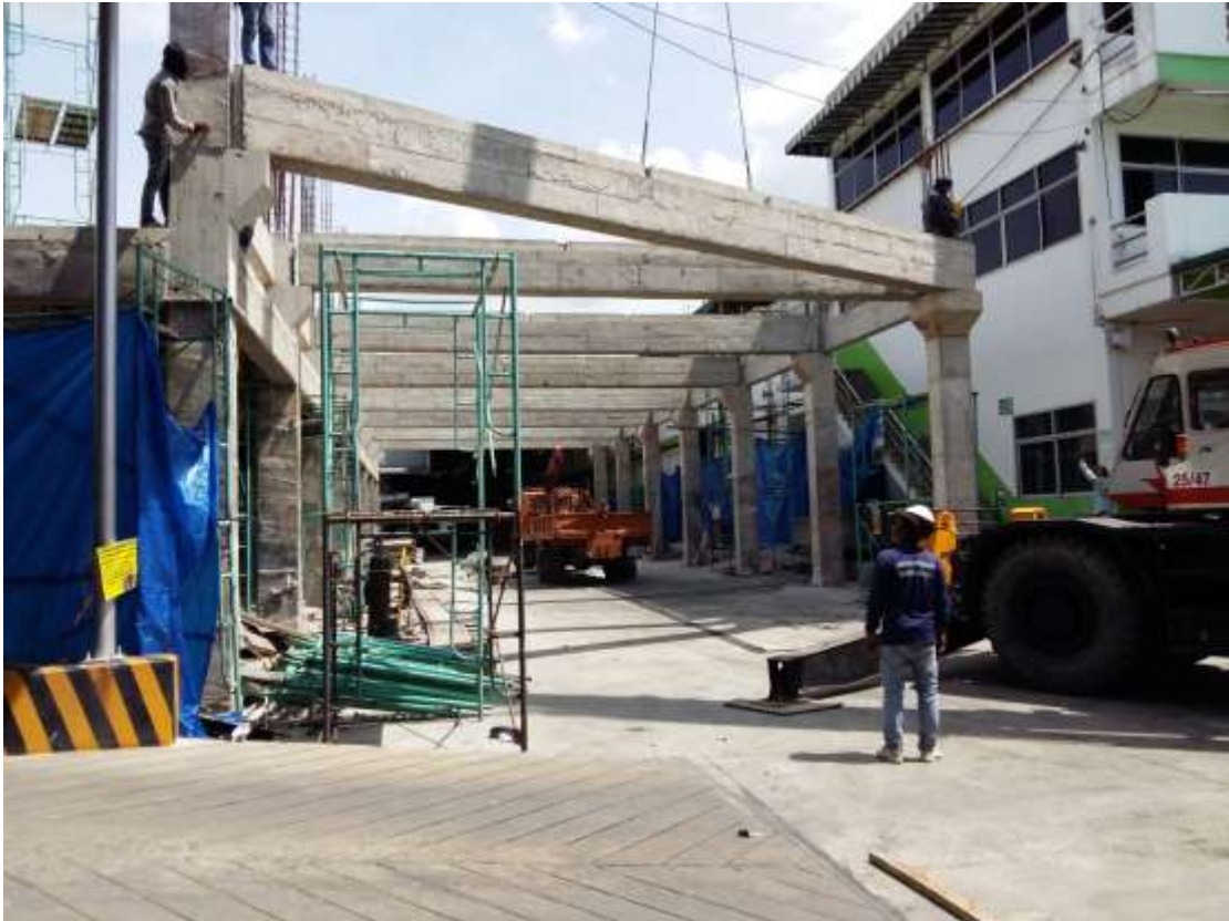
รูปที่ 4.25 ติดตั้งคาน Precast เสร็จสมบูรณ์
