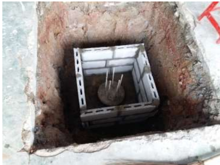
รูปที่ 4.8 การเข้าแบบของฐานราก
