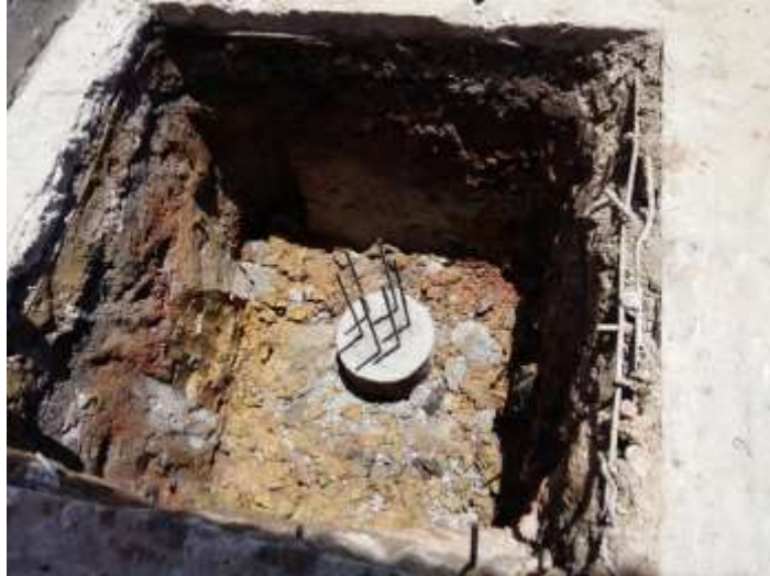
รูปที่ 4.7 ลักษณะของเสาเข็มที่ถูกตัดแล้ว ผิวหน้าของเสาเข็มที่ถูกตัดแล้วจะต้องเรียบเนียนและเหล็กเสริมอยู่ครบ
