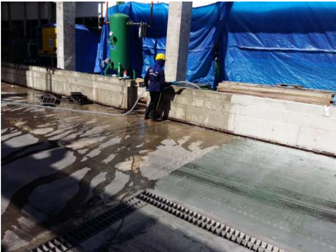
รูปที่ 4.23 การบ่มคาน Precast ด้วยน้ำ
