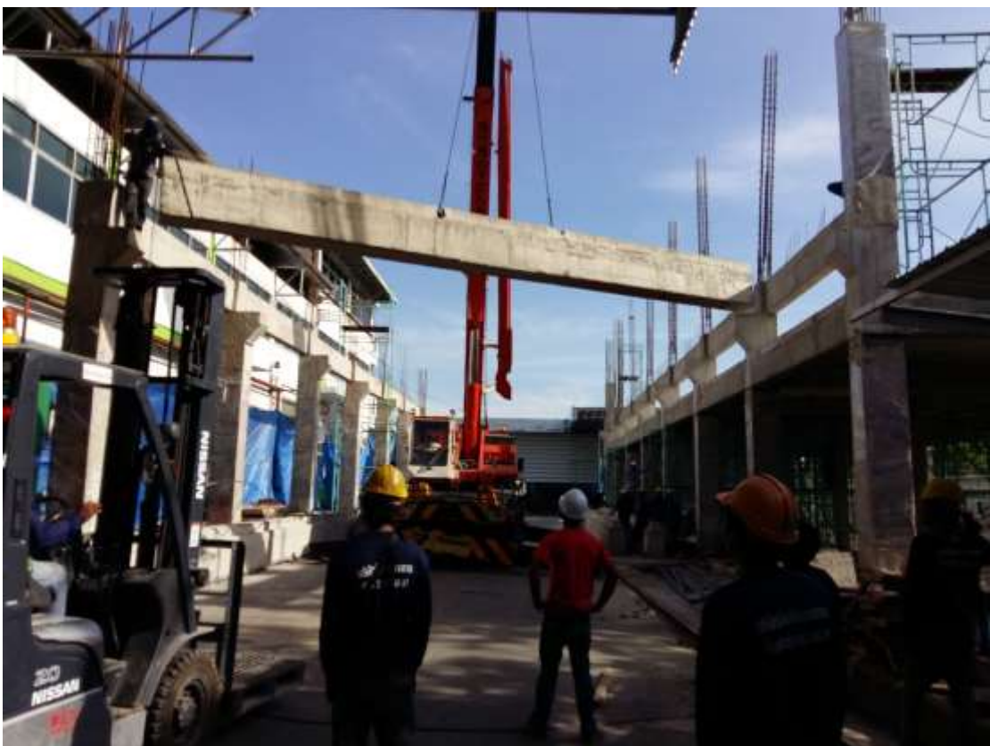
รูปที่ 4.24 ติดตั้งงาน Precast
