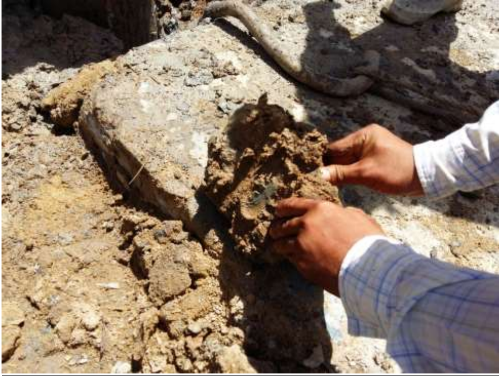
รูปที่ 4.4 การเจาะเสาเข็มจนถึงชั้นดินเหนียวปนทราย การเจาะเสาเข็มแห่งนั้นต้องเจาะจนถึงดินเหนียวปนทรายซึ่งระดับชั้นทรายของจังหวัดนครปฐมคือ -17 เมตร
