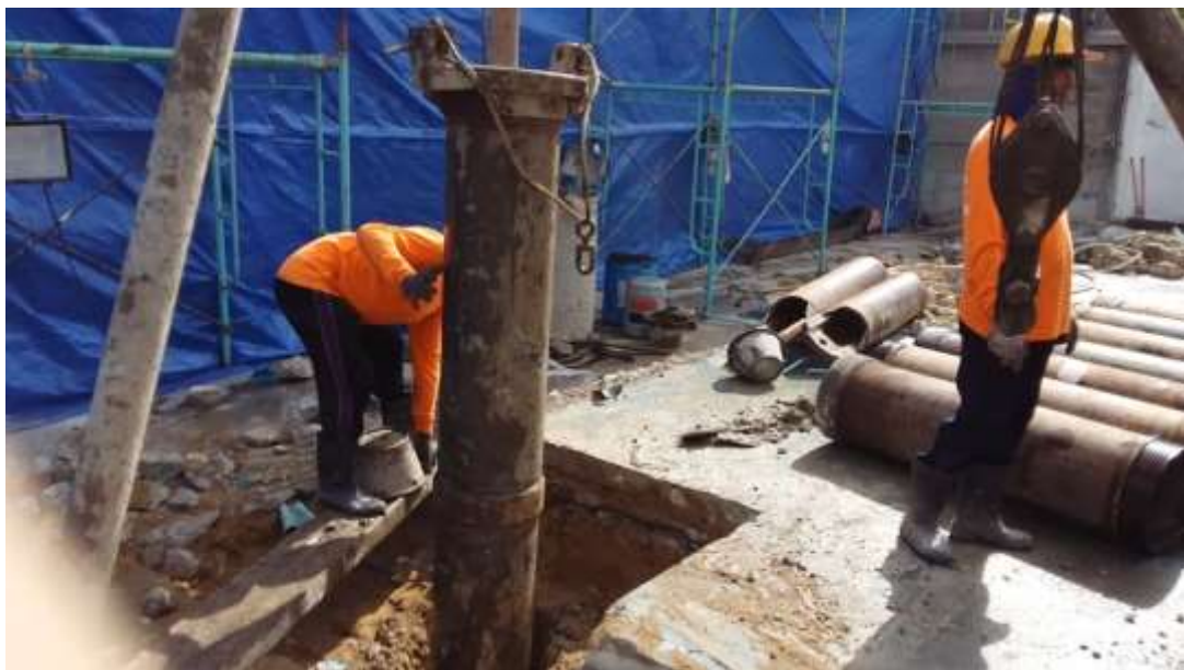
รูปที่ 4.3 การต่อปลอกเหล็กชั่วคราว
