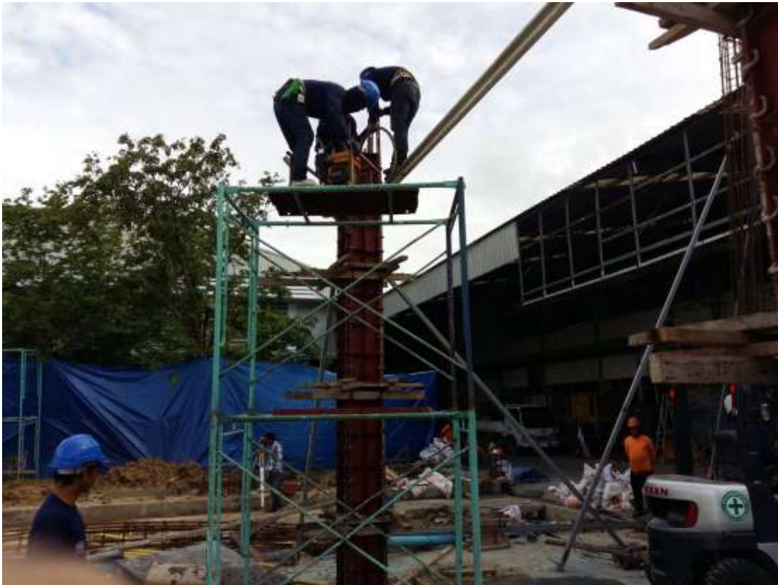
รูปที่ 4.13 การจี้คอนกรีตเสา
