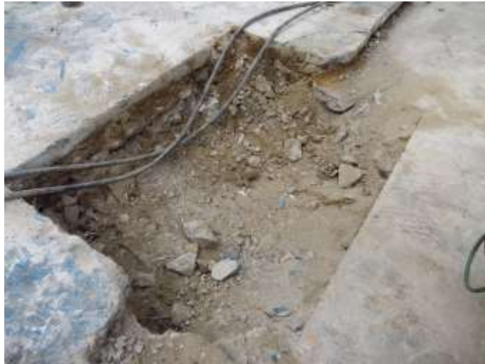
รูปที่ 4.2 ลักษณะของหลุมหลังจากการสกัดผิวหน้าออกและพร้อมสำหรับเสาเข็มเจาะ
