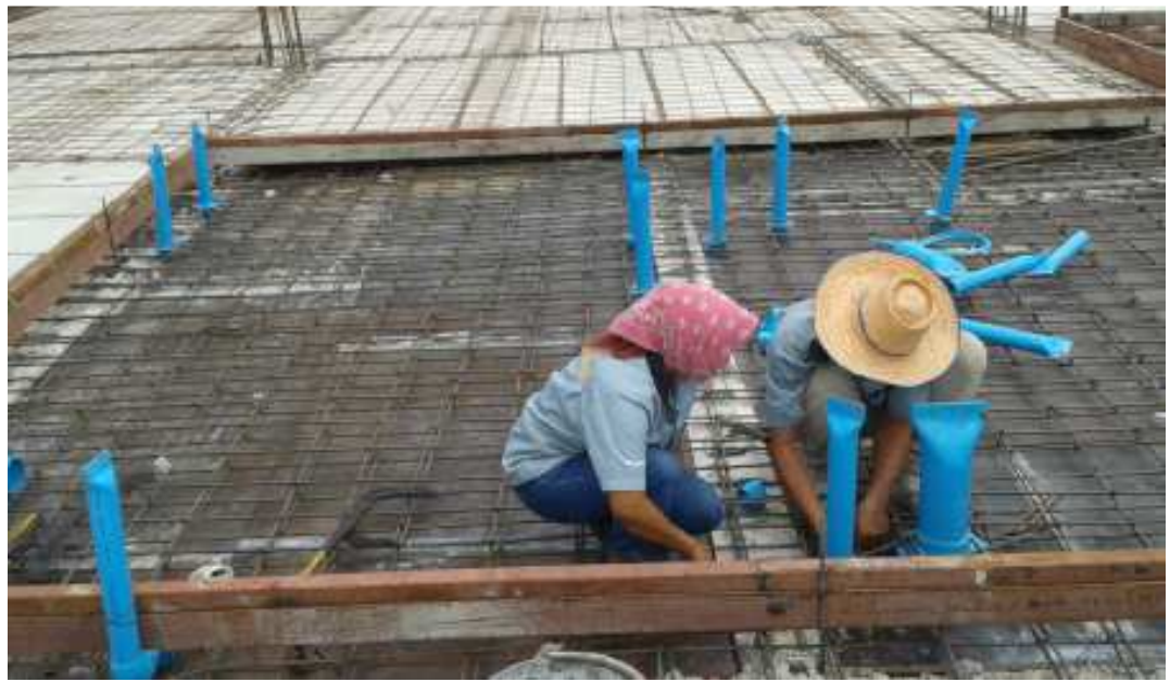
รูปที่ 6 การติดตั้งท่อน้ำบนพื้นอาคารก่อนเทปูน
