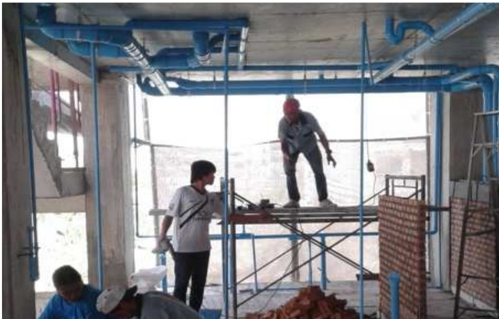
รูปที่ 5 การติดตั้งท่อน้ำใต้พื้นคานก่อนปิดฝ้า
