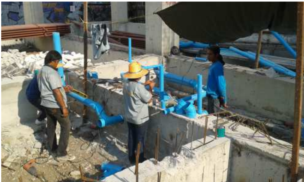
รูปที่ 4 การติดตั้งท่อน้ำใต้แผ่นพื้นก่อนเทพูน
