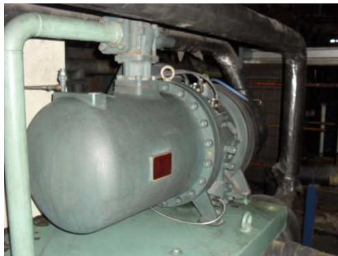
รูปที่ 2.3 คอมเพรสเซอร์แบบสกรู(screw compressors)
