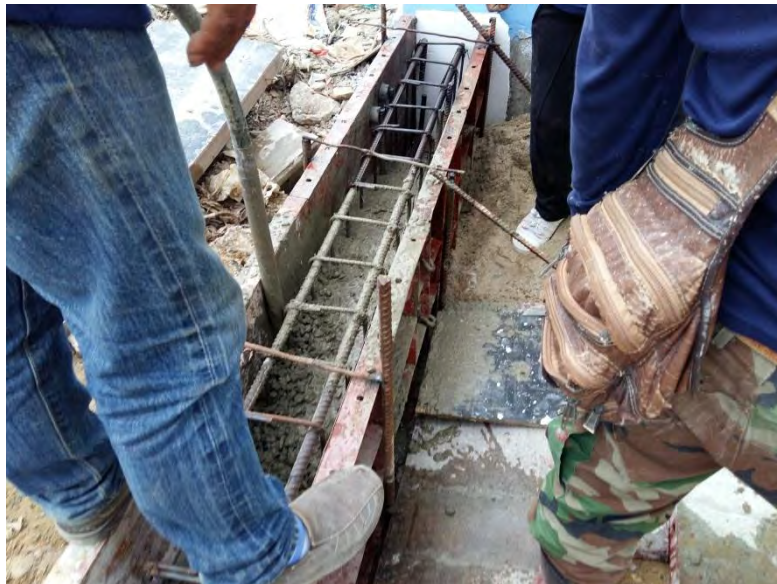
รูปที่ 3.17 การจี้คอนกรีตคาน
