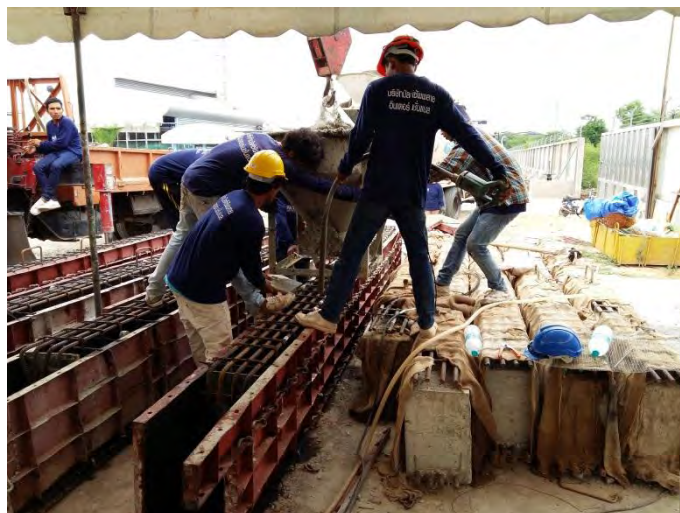
รูปที่ 3.15 วิธีการเทคอนกรีต
