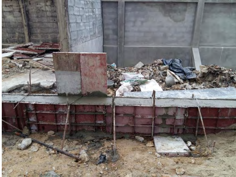
รูปที่ 3.16 การค้ำยันแบบหล่อคาน
