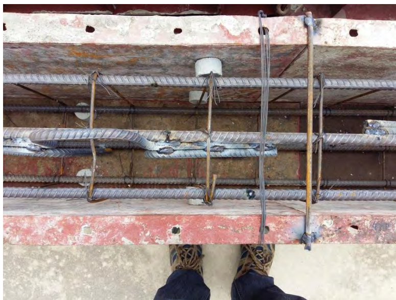
รูปที่ 3.14 ควรทำความสะอาดพื้นผิวก่อนเทคอนกรีต
