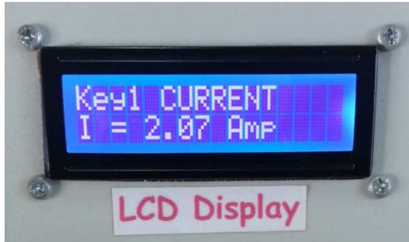
รูปที่ 4.5 หน้าจอแสดงค่ากระแสไฟฟ้าที่วัดได้
