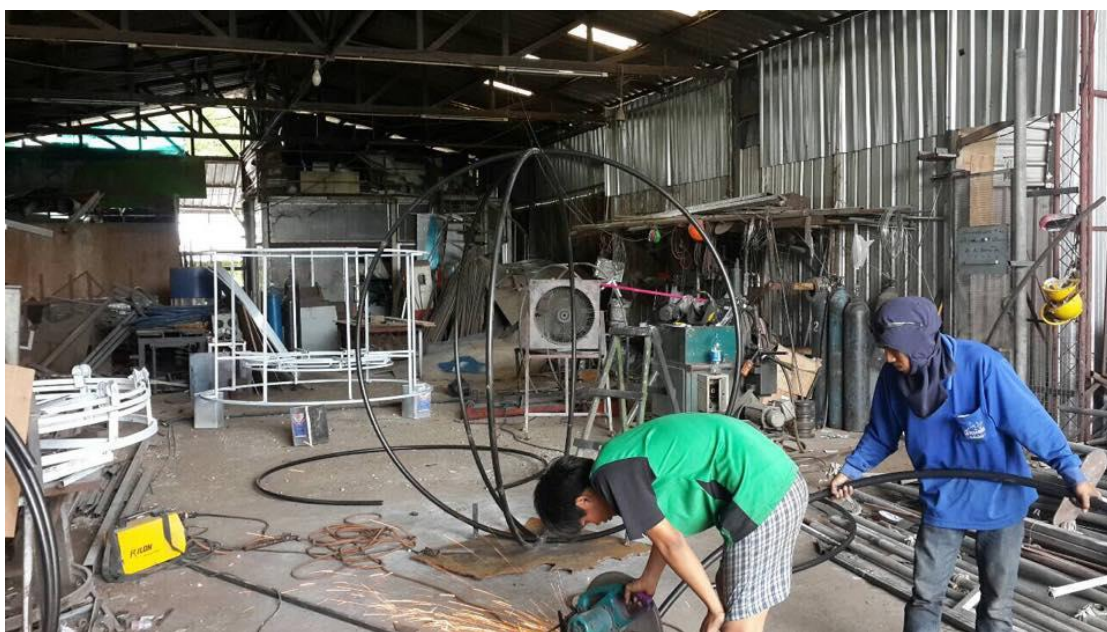
รูปที่ ก.4 ส่วนงานการตัดเหล็กให้เป็นวงกลม
