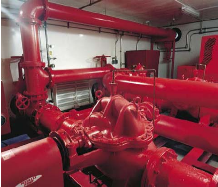
รูปที่ 2.19 เครื่องสูบน้ำดับเพลิงแบบตั้ง
