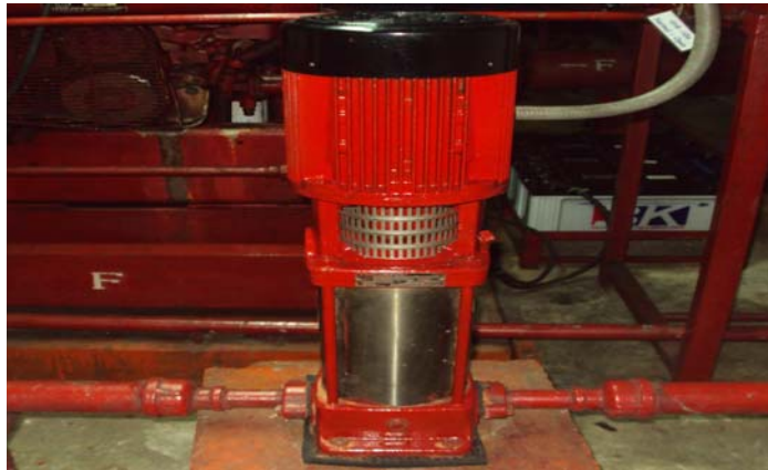
รูปที่ 3.3 เครื่องสูบน้ำรักษาแรงดัน(Jockey Pump)
