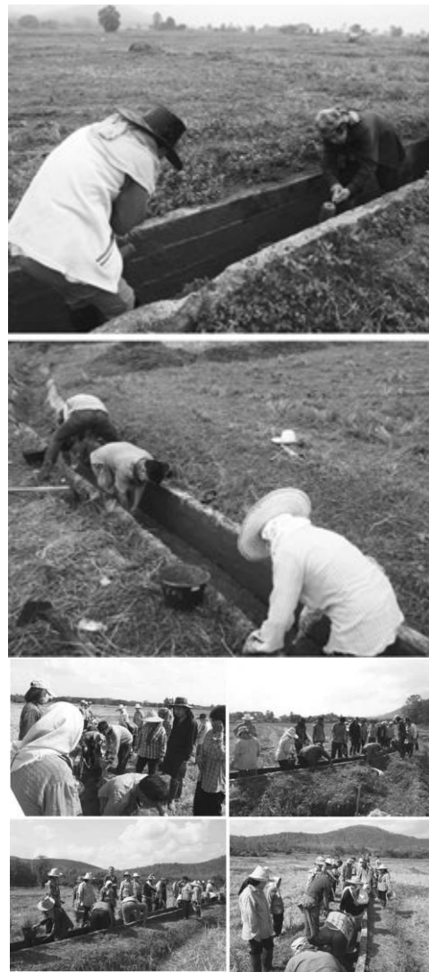
ภาพที่ 16 สาธิตการซ่อมแซมคลองชลประทานให้กับผู้เข้าร่วมการถ่ายทอดเทคโนโลยี
