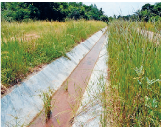
รูปที่ 17 ภาพถ่ายคลองชลประทานที่ได้รับการซ่อมแซมหลังจากผ่านการใช้งาน 6 เดือน
