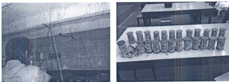
รูปที่ 6 เจาะเก็บตัวอย่างแท่งคอนกรีตด้วยวิธี coring
