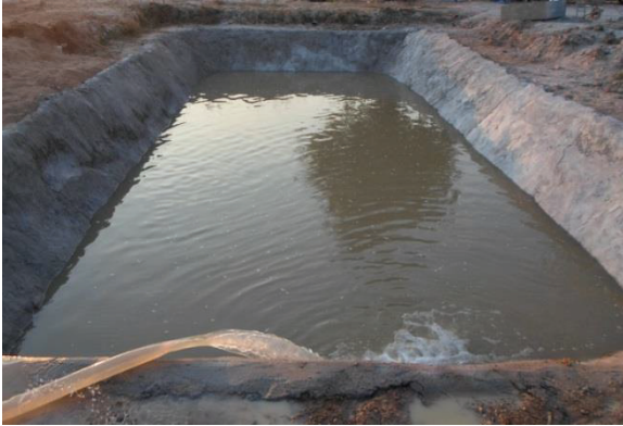
รูปที่ 12 สระน้ำที่ลาดด้วยดินซีเมนต์ผสมน้ำยางพารา
