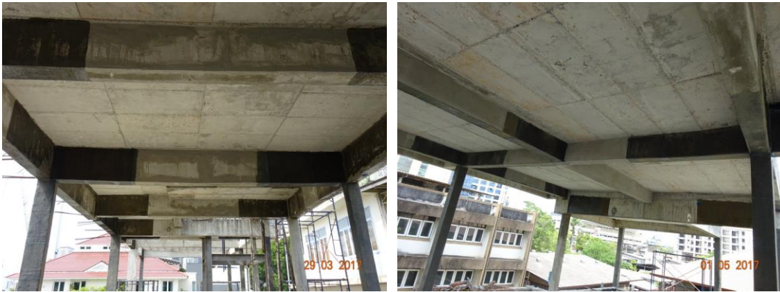
รูปที่ 8 การติดตั้ง Carbon Fiber Reinforced Polymers
