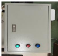
รูปที่ 11 ปุ่มกด Start, Up and Down
