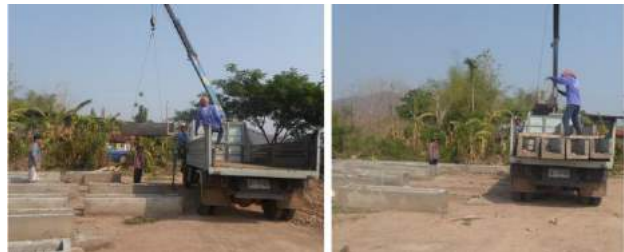
รูปที่ 19 เคลื่อนย้ายคูกิ่งน้ำสำเร็จรูปด้วยรถบรรทุก
