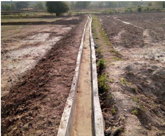
รูปที่ 24 คูส่งน้ำคอนกรีตผสมน้ำยางพาราพร้อมใช้งานในพื้นที่แปลงนา
