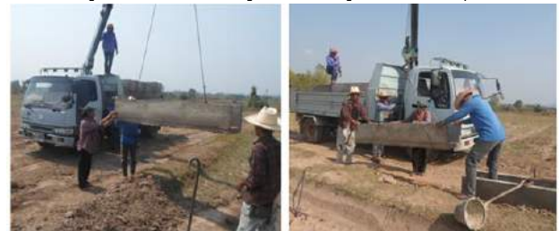
รูปที่ 20 การติดตั้งคูกิ่งน้ำสำเร็จรูปผสมน้ำยาพารา
