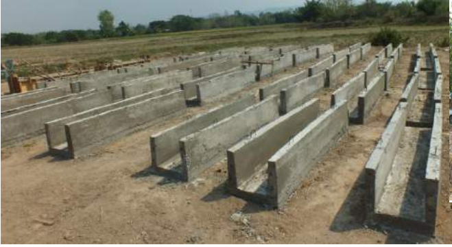
รูปที่ 18 กำหนดความลาดของท้องคูกิ่งน้ำโดยใช้กล้องวัดระดับ
