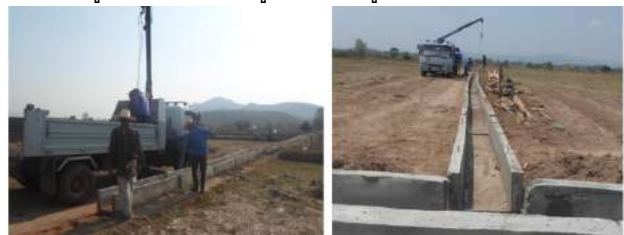
รูปที่ 21 ตัวอย่างคูกิ่งน้ำสำเร็จรูปที่ได้ทำการติดตั้งในแปลงนา
