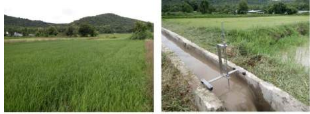
รูปที่ 26 ภาพคูส่งน้ำขณะใช้งานและบริเวณโดยรอบ
