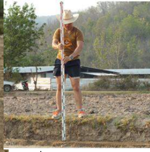
รูปที่ 18 กำหนดความลาดของท้องคูกิ่งน้ำโดยใช้กล้องวัดระดับ
