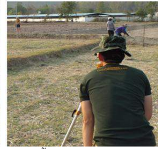
รูปที่ 18 กำหนดความลาดของท้องคูกิ่งน้ำโดยใช้กล้องวัดระดับ
