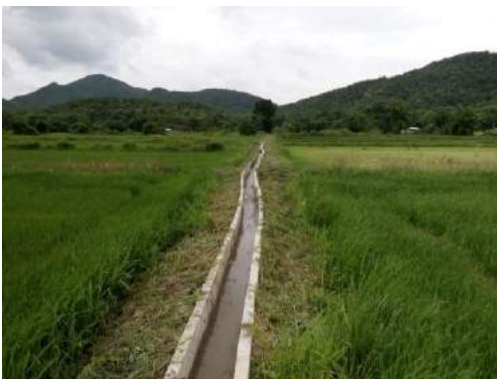
รูปที่ 25 คูส่งน้ำหลังจากก่อสร้างและคูส่งน้ำขณะใช้งาน
