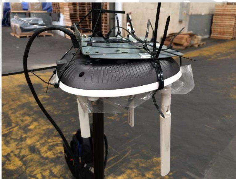
รูปที่ 3.9 ติดตั้ง Access point กับเสาเพื่อนำไปวัดสัญญาณตามจุดต่างๆ
