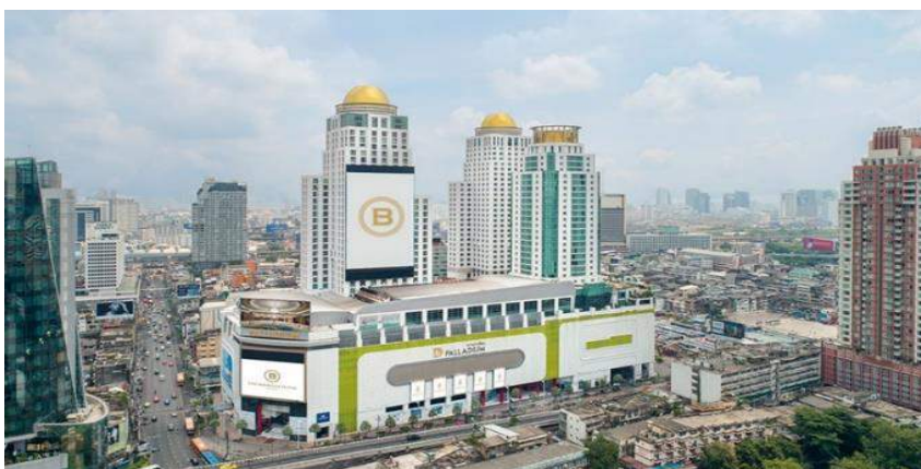
รูปที่ 3.1 โรงแรม The Berkeley Hotel Pratunam ที่มา https://www.berkeleypratunam.com
