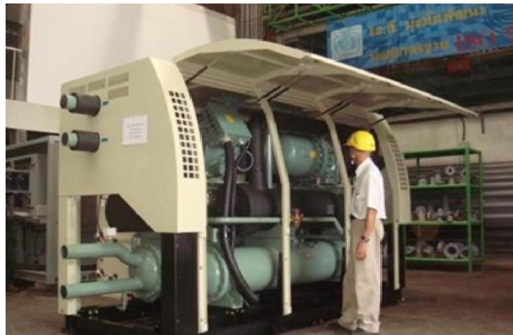
รูปที่ 2.16 เครื่องทำน้ำเย็นระบบความร้อนด้วยน้ำ
