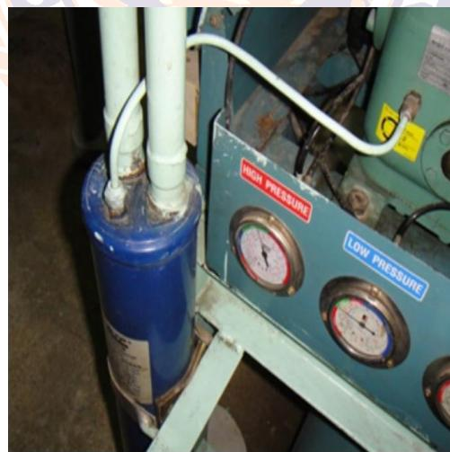
รูปที่ 2.12 อุปกรณ์แยกน้ำมันหล่อลื่น (Oil separator)
