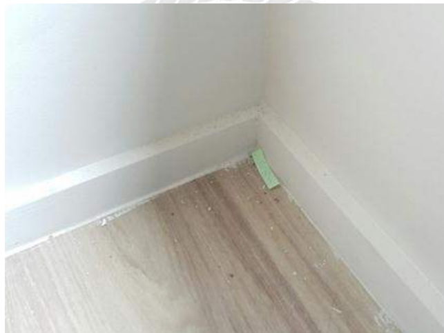
รูปที่ 4.24 เก็บงานมุมผนังห้อง + บัวไม้เรียบร้อย
