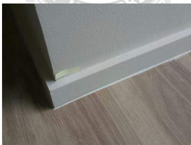
รูปที่ 4.22 เก็บงานสีผนัง+บัวไม่เรียบร้อย
