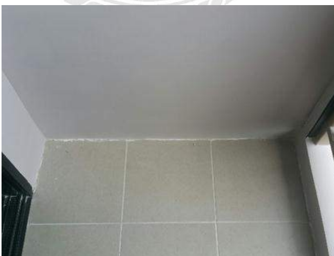
รูปที่ 4.16 เก็บงานพื้นรอยต่อกระเบื้องไม่เรียบร้อย
