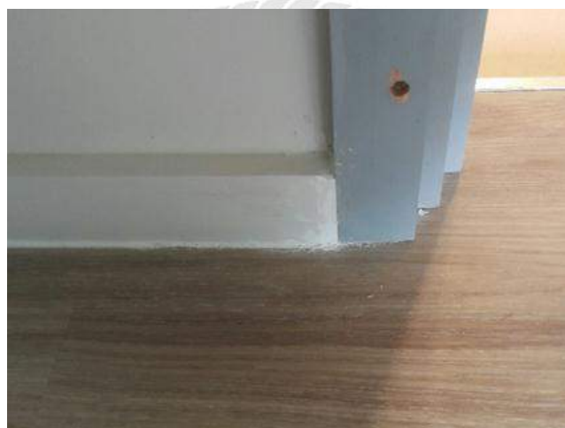
รูปที่ 4.36 เก็บงานรอยต่อบัวกับประตูไม่เรียบร้อย
