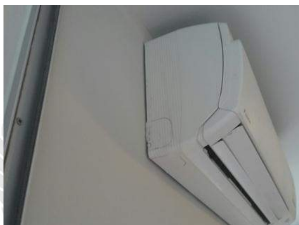
รูปที่ 4.21 เก็บงานสีรอบแอร์ภายในห้อง
