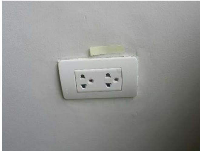
รูปที่ 4.23 เก็บงานรอบปลั๊กสวิตช์ไฟ
