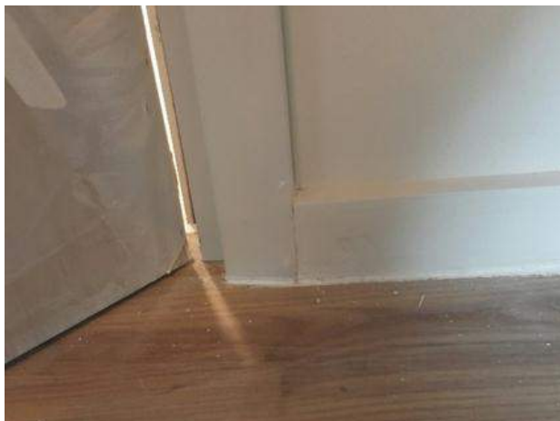
รูปที่ 4.38 เก็บงานรอยต่อวงกบกับบัวพื้น
