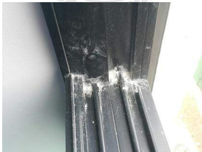
รูปที่ 4.25 เก็บงานขานแนวบานหน้าต่างไม้เรียบร้อย / เปื้อน
