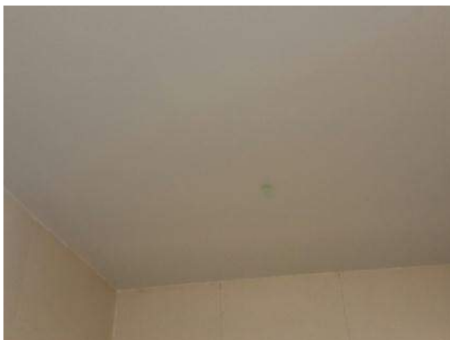
รูปที่ 4.11 เกือบสี่เพดานงานฝ้าไม่เรียบร้อย
