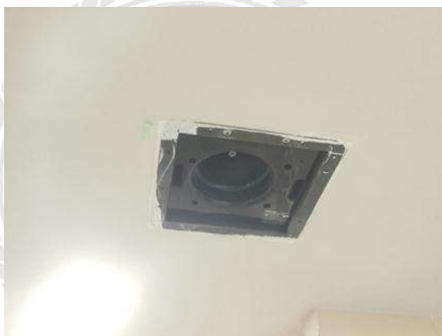
รูปที่ 4.12 พัดลมดูดอากาศเกือบสี่ไม่เรียบร้อย
