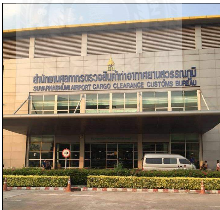
รูปที่ 3.1 ด้านหน้าตึก BC อาคารสำนักงานศุลกากรตรวจสินค้า
