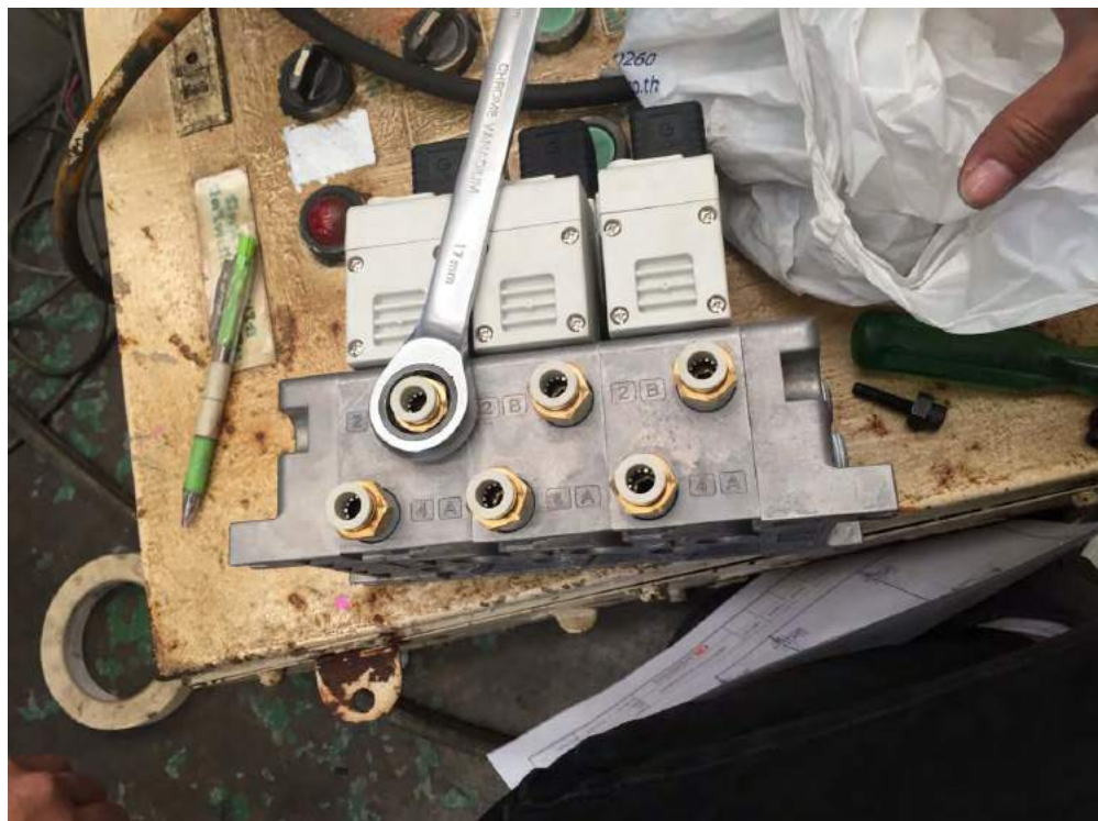
รูปที่ 4.3 ติดตั้งฟิตติ้ง
