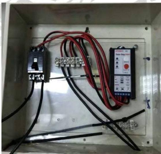
รูปที่ 4.15 การดึงร้อยสาย DC:Solar
