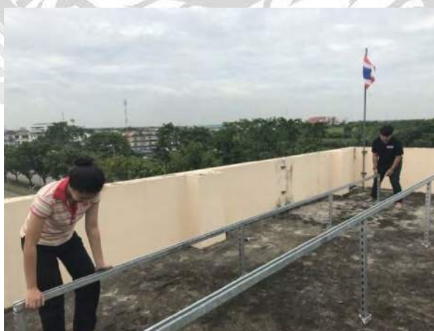
รูปที่ 4.12 การวางคาน
