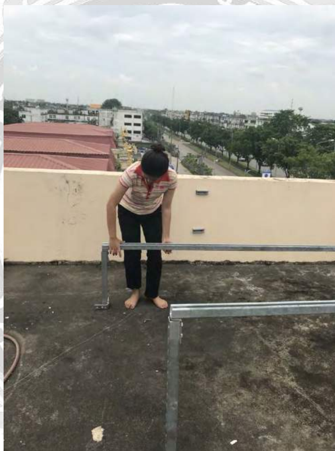
รูปที่ 4.10 วาง Marking ตำแหน่งยึด Bracket กับดาดฟ้า
