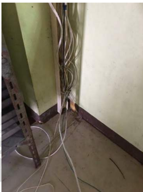
รูปที่ 4.16 การดึงร้อยสาย DC: 2xCV 6 sq.mm พร้อมสายดิน
