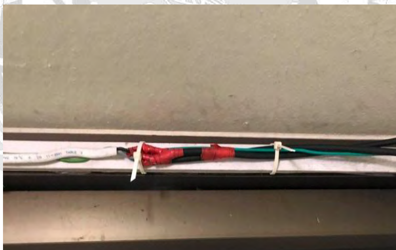
รูปที่ 4.26 ดึงร้อยสาย AC: 2*CV 2.5 sq.mm
