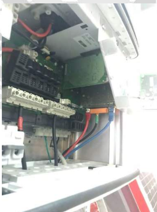
รูปที่ 4.24 การติดตั้ง Sunny Webbox
