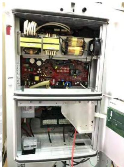
รูปที่ 4.23 การติดตั้งอินเวอร์เตอร์
