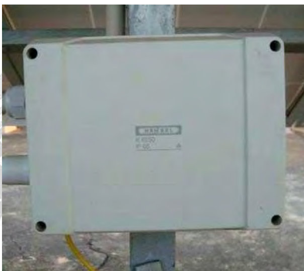
รูปที่ 4.14 ติดตั้งกล่อง Array Junction Box
