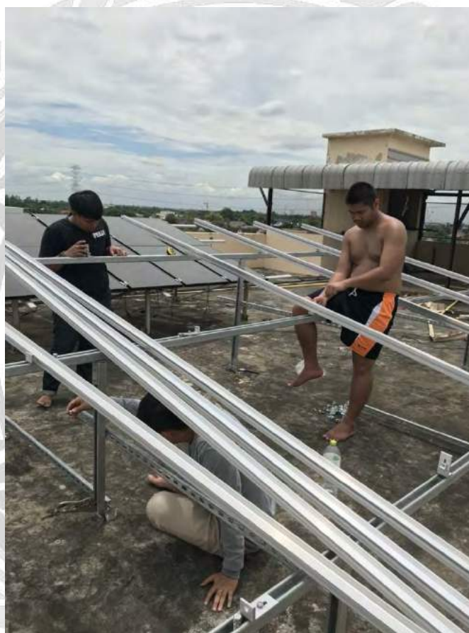
รูปที่ 4.13 วางแปรง Aluminium Profile
