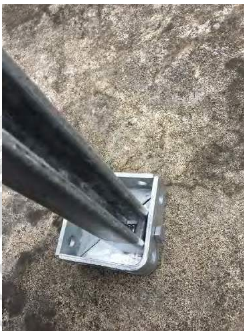
รูปที่ 4.11 ยึดเสา Support
