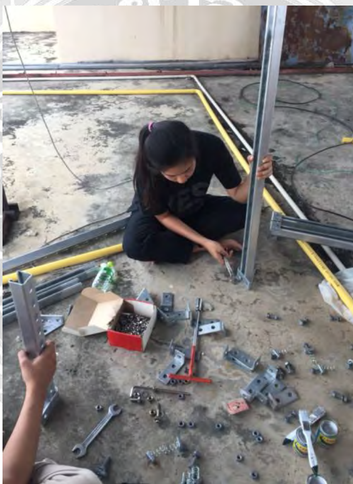
รูปที่ 4.9 การประกอบโครงสร้าง
