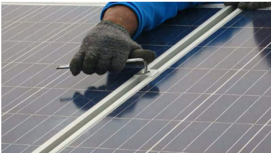
รูปที่ 2.16 ตรวจสอบส่วนที่ยึดโครงสร้าง
