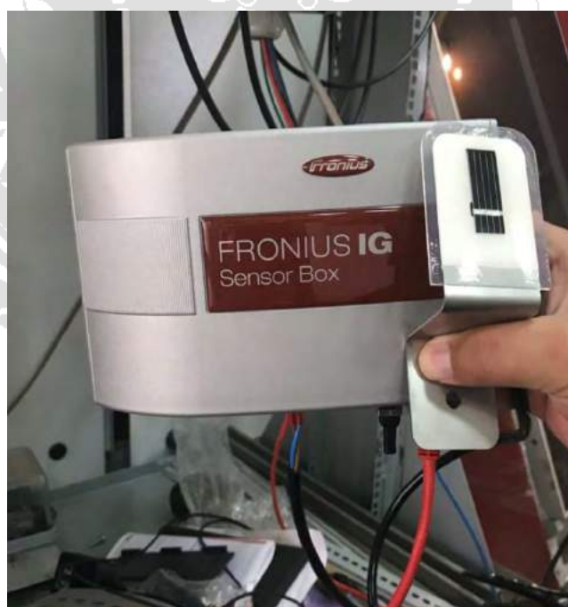
รูปที่ 4.22 ขั้นตอนการติดตั้ง Sensor Box 2
