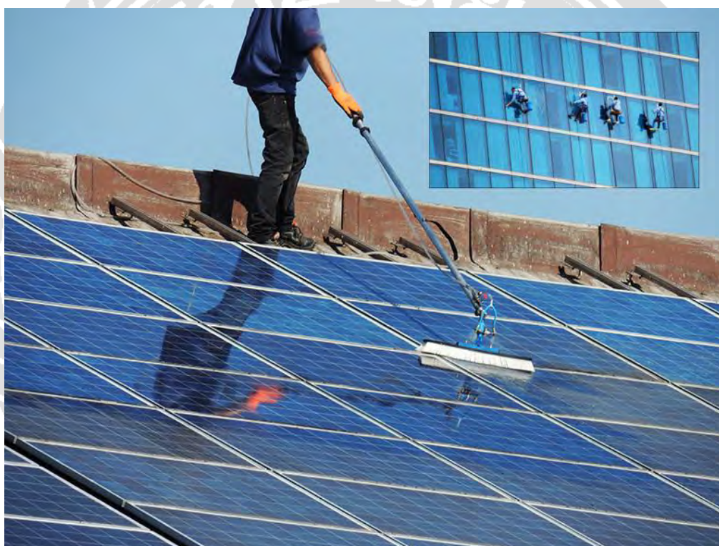
รูปที่ 2.15 การเช็ดทำความสะอาด
