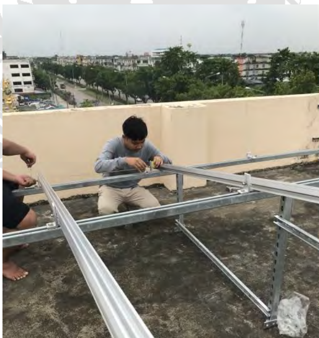
รูปที่ 4.16 ประกอบและตั้งโครงสร้าง
