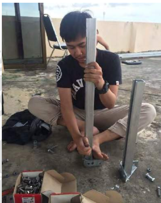
รูปที่ 4.13 จัดเตรียมอุปกรณ์เพื่อทำโครงสร้าง
