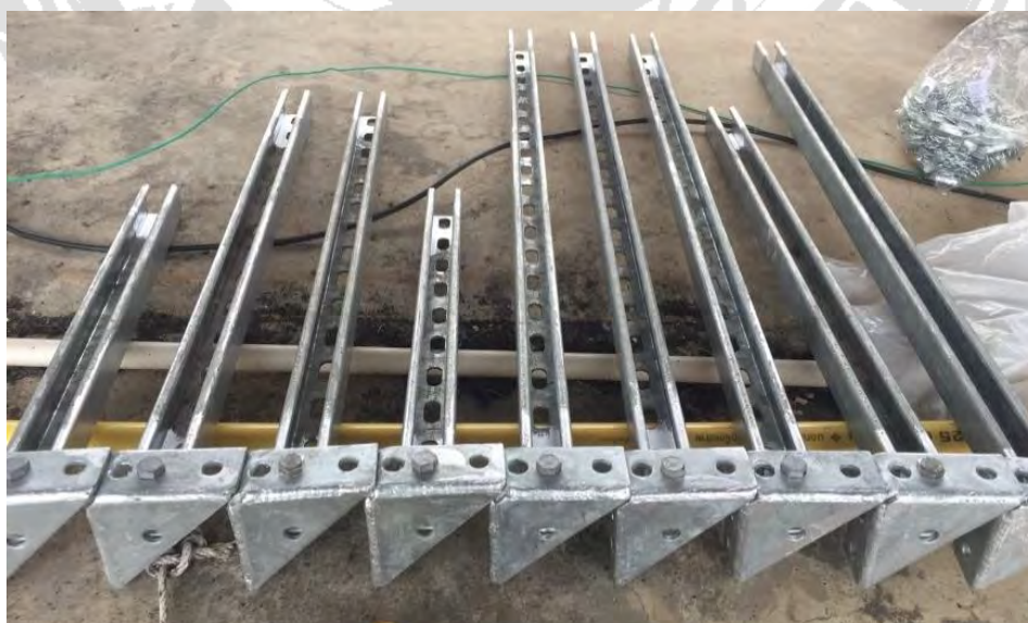
รูปที่ 4.14 จัดเตรียมอุปกรณ์เพื่อทำโครงสร้าง
