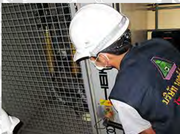
รูปที่ 3.3 การตรวจสอบอุปกรณ์
