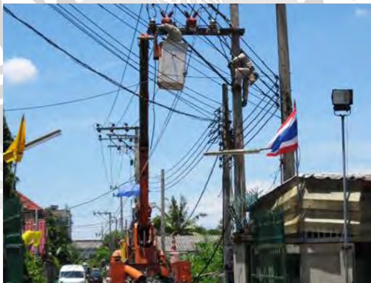
รูปที่ 3.11 ติดตั้งแรงสูง
