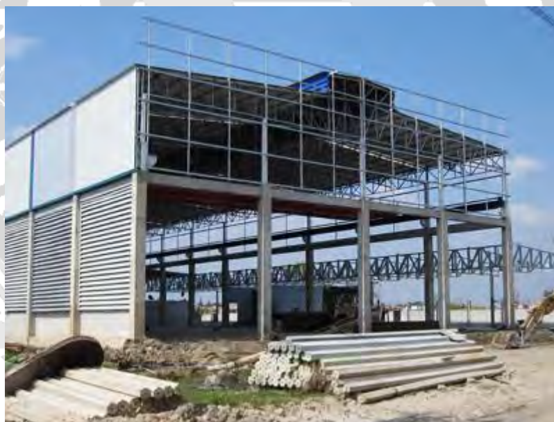
รูปที่ 3.9 โรงงานที่กำลังสร้าง
