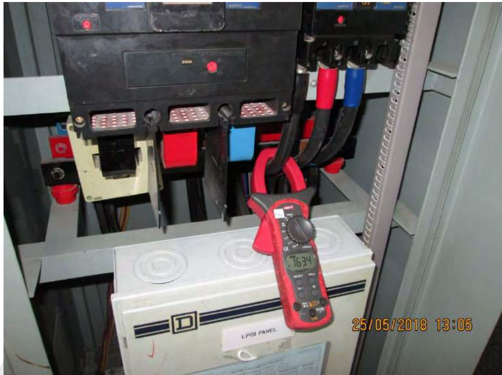
รูปที่ 15 การเช็คการ Balance Load ของ MCCB
