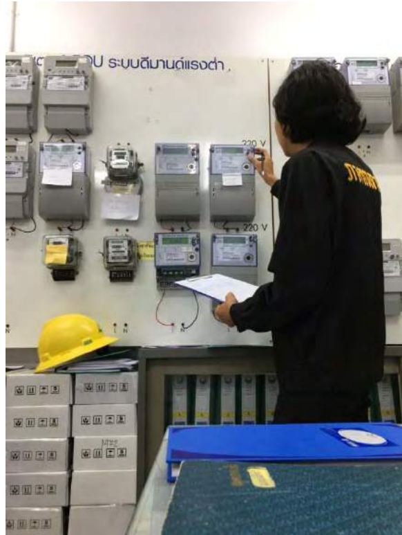
ภาพผนวก กรูปีที่ 18 ตรวจสอบมิเตอร์TOU ก่อนนำไปติดตั้ง
