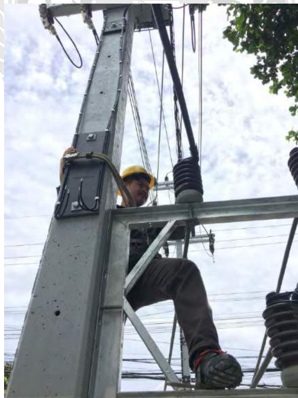
ภาพผนวก ก รูปที่ 6 ปีนเสาตรวจสอบลูกถ้วย
