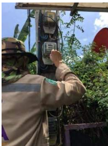
รูปที่ 4.26ปากกาเช็คเฟสตรวจสอบสายไฟ
