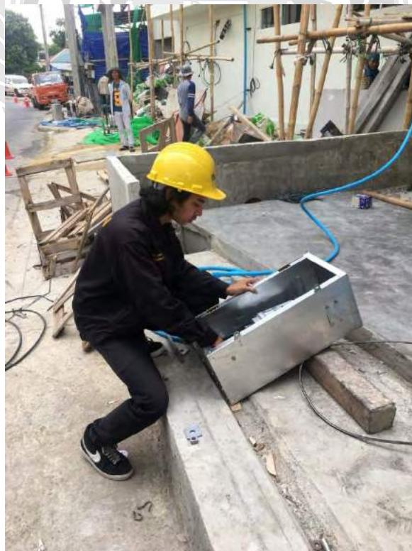
ภาพผนวก ก รูปที่ 17 ติดตั้งมิเตอร์TOU
