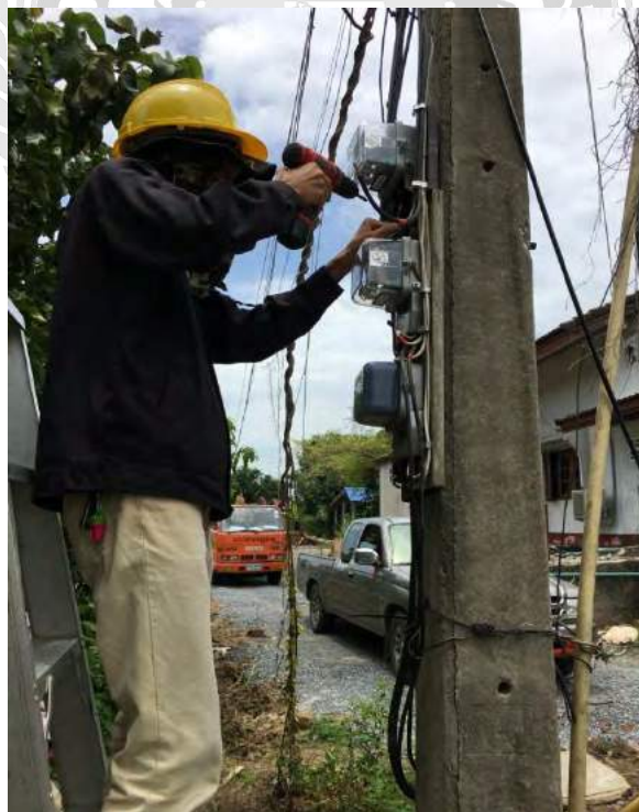
ภาพผนวก ก รูปที่ 15 ติดตั้งมิเตอร์และนำสายไฟเข้ามิเตอร์
