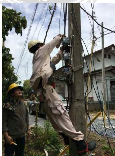
รูปที่ 4.6 ทำการติดตั้งมิเตอร์
