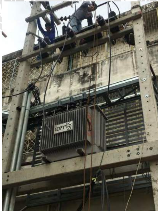
ภาพผนวก ข รูปที่ 23 การติดตั้งCT
