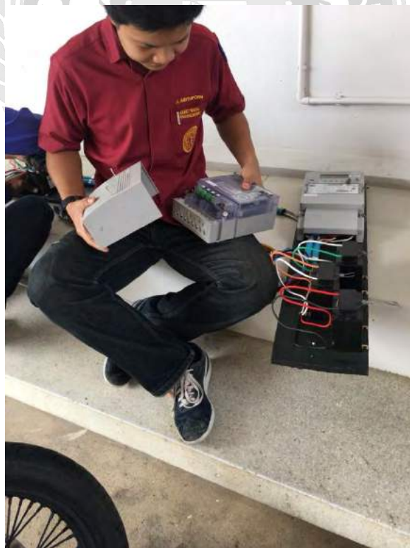
ภาพผนวก ก รูปที่ 9 ติดตั้งมิเตอร์ TOU
