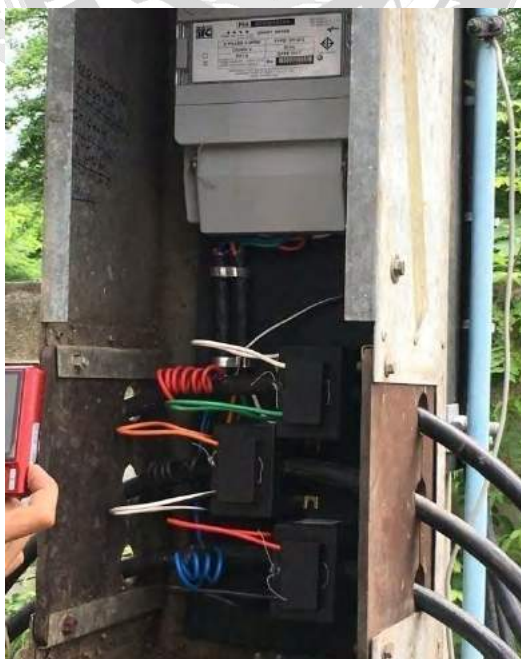
รูปที่ 4.20ติดตั้งสายไฟ3Phaseเข้า CTแล้วมิเตอร์
