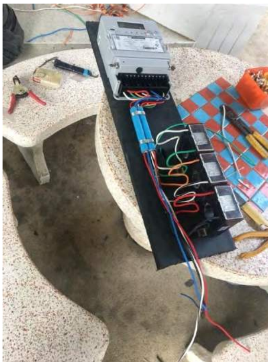
รูปที่ 4.17 มิเตอร์ที่ติดตั้งเข้ากับแป้นไม้เรียบร้อยแล้ว
