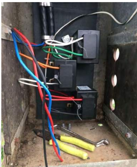
รูปที่ 4.19เตรียมการต่อสายไฟเข้า CT,
