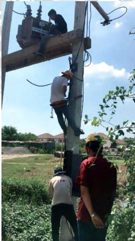
ภาพผนวก ก รูปที่ 13 ติดตั้งมิเตอร์ TOU
