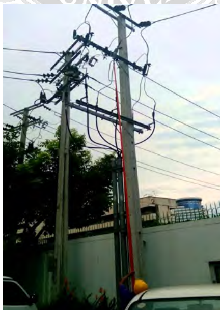
รูปที่ 4.22 ตอนชักฟิวส์แรงสูง
