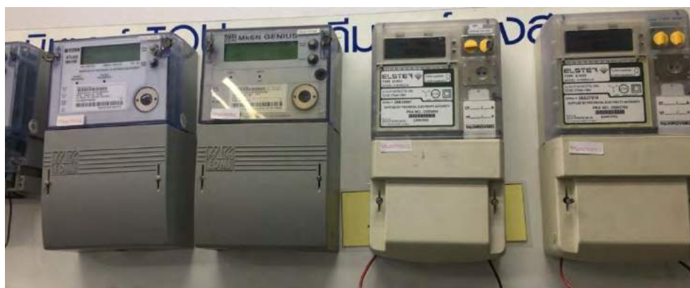
รูปที่ 3.9 มิเตอร์ TOU แรงสูงและแรงต่ำ
