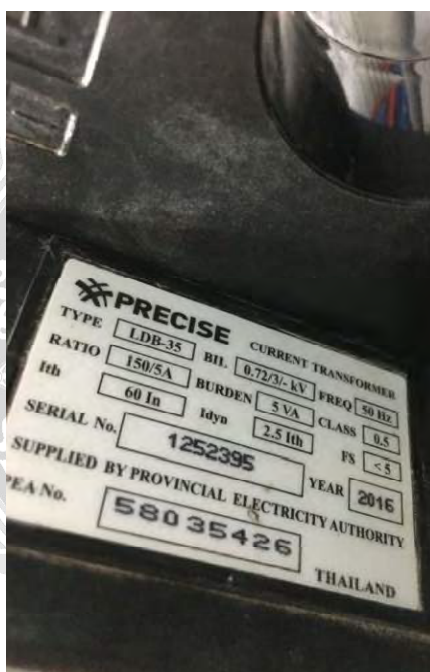
รูปที่ 4.12 ข้อมูล CT ที่ใช้ติดตั้ง
