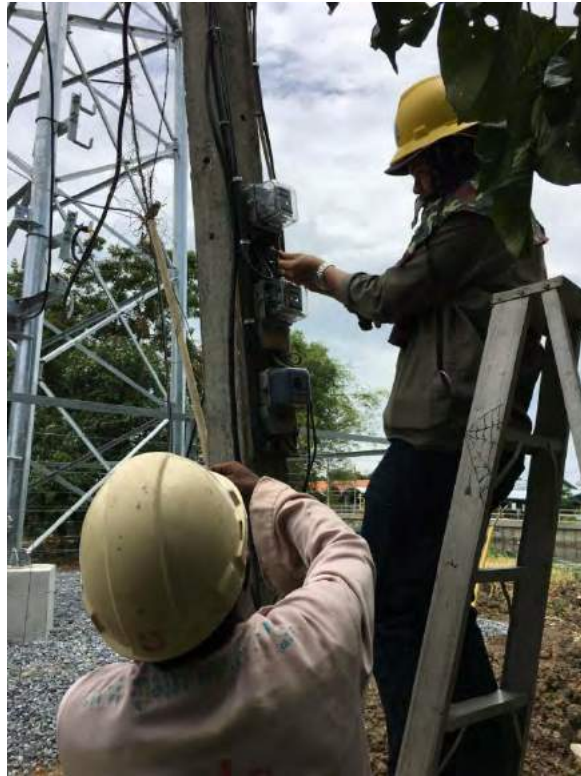
ภาพผนวก ก รูปที่ 10 นำสายไฟเข้ามิเตอร์
