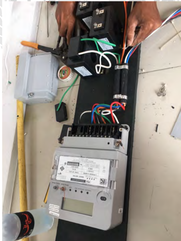
ภาพผนวก ก รูปที่ 21 ต่อวงจรมิเตอร์
