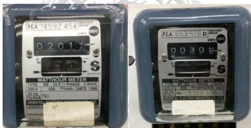
รูปที่ 3.7 มิเตอร์ขนาด 15(45)A และ 30(100)A
