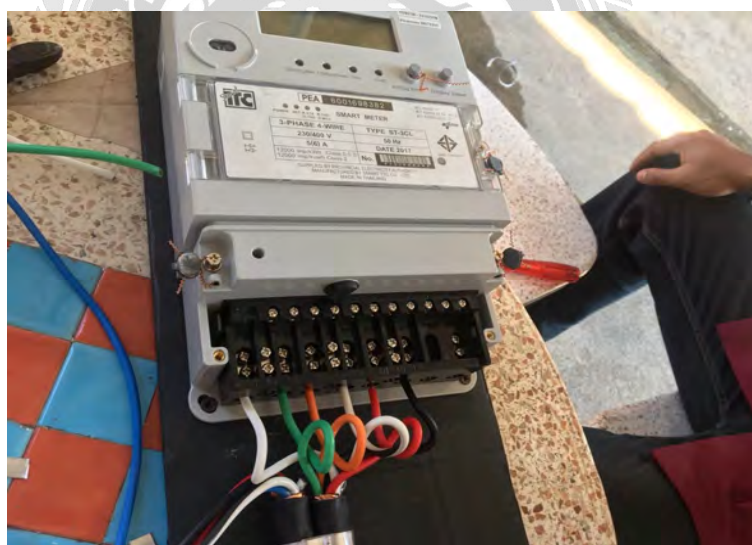
รูปที่ 4.14 นำสายไฟต่อเข้าขั้วมิเตอร์
