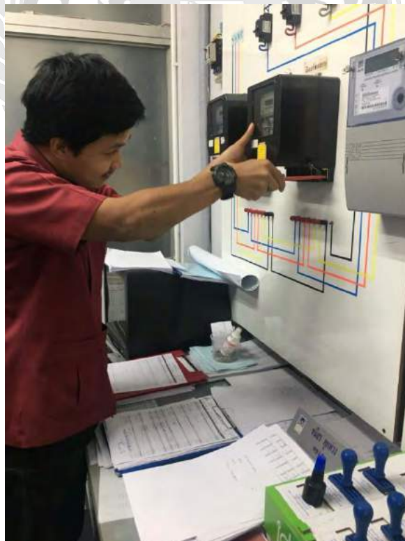
ภาพผนวก ก รูปที่ 7 ติดตั้งมิเตอร์วงจรเทียบ
