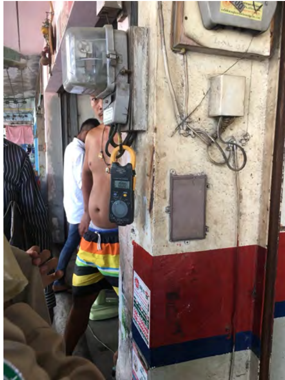
ภาพผนวก ข รูปที่ 32 ตรวจสอบมิเตอร์
