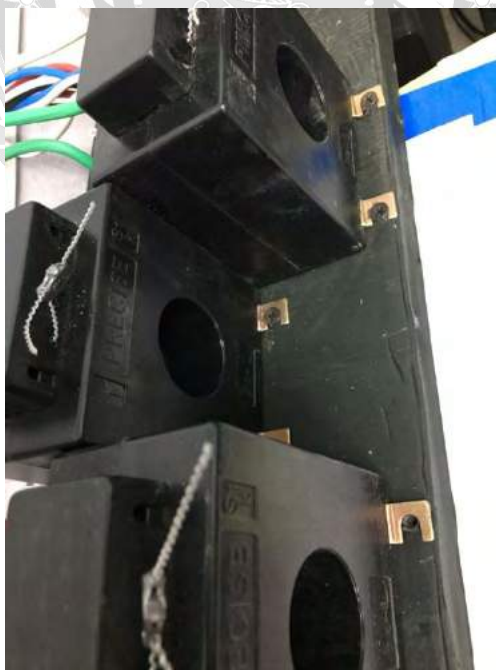
รูปที่ 4.11 การติดตั้ง CT
