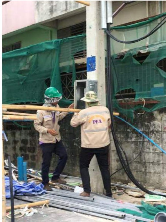
ภาพผนวก ข รูปที่ 24 นำมิเตอร์ติดกับเสา
