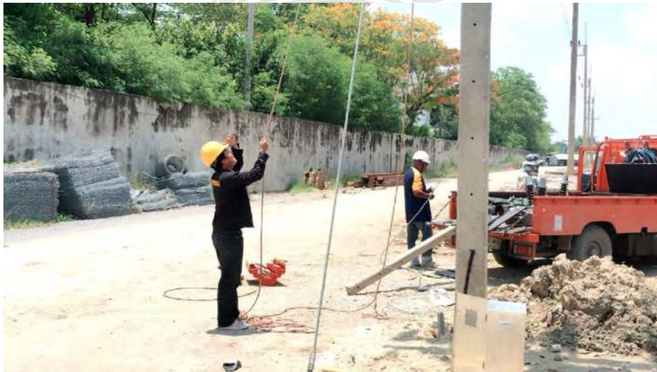
ภาพผนวก ก รูปที่ 4 ทำการติดตั้งอุปกรณ์
