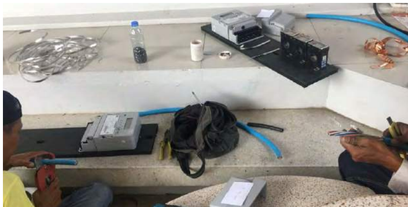
รูปที่ 4.10 การติดตั้งมิเตอร์เข้ากับแป้นไม้และเข็มขัดรัดสาย
