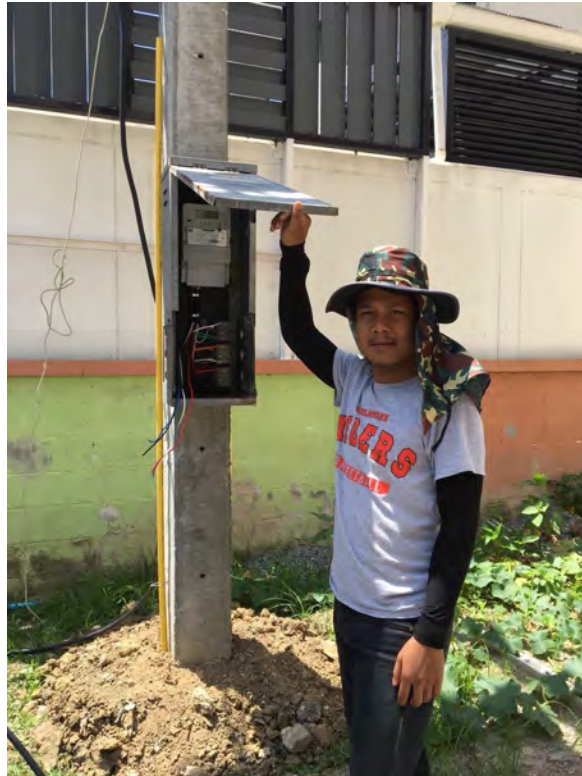
ภาพผนวก ก รูปที่ 5 ติดตั้งมิเตอร์ TOU
