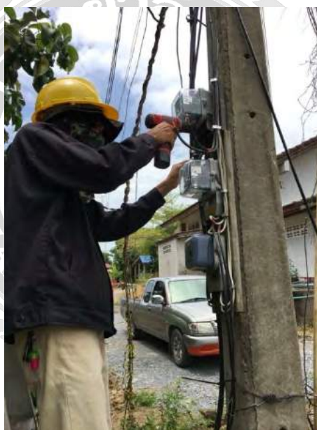
รูปที่ 4.7 นำสายไฟเข้ามิเตอร์
