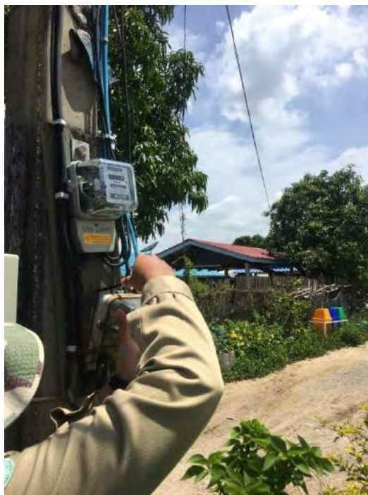
รูปที่ 4.35 แกะไขมิเตอร์ที่ชำรุด
