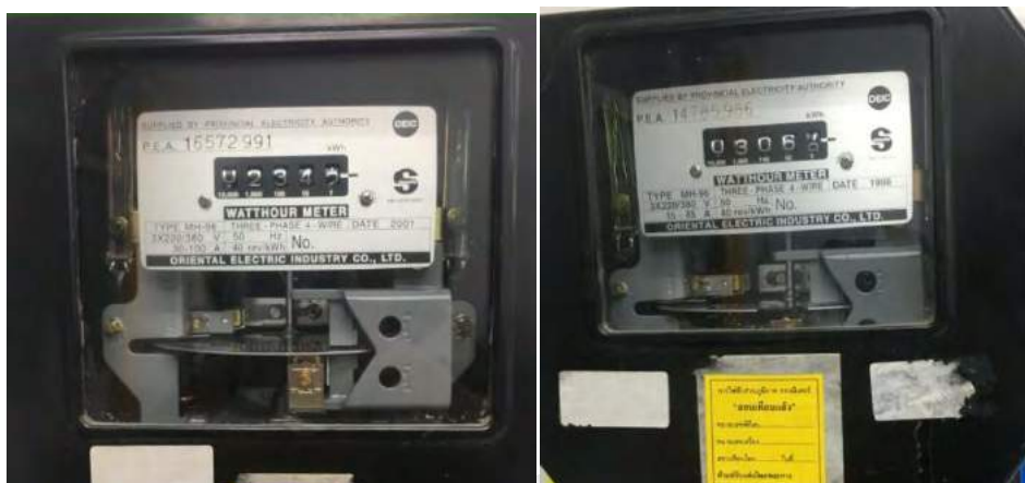
รูปที่ 3.6 มิเตอร์ขนาด 15-45 3 Phase และ 30-100 phase
