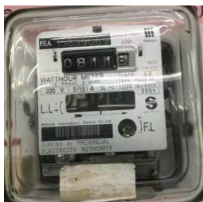
รูปที่ 3.8 มิเตอร์ขนาด 5(15)A
