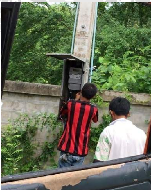
รูปที่ 4.18 นำมิเตอร์ติดเข้ากับเสาไฟ
