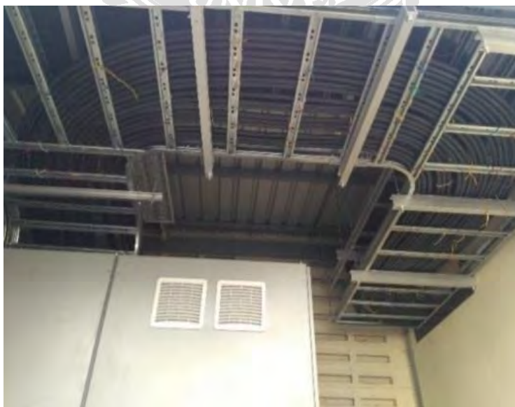
รูปที่ 4.7 การเดินสายไฟบนแลคเคอร์
