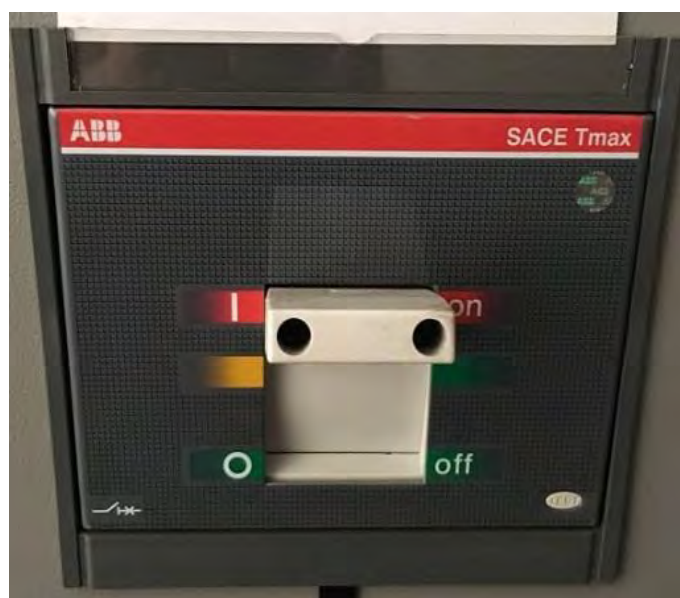
รูปที่ 2.15 MCCB (Molded Case Circuit Breaker)
