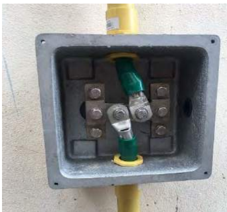
รูปที่ 4 27 ติดตั้ง Ground Test Box
