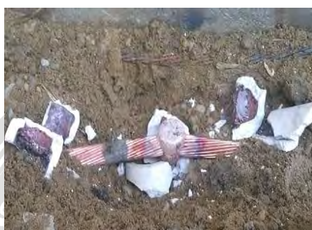
รูปที่ 4.31 การต่อหลักดิน
