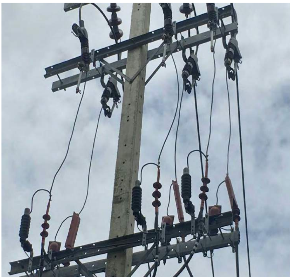
รูปที่ 4.5 การเดินสายแรงสูงเข้าที่ร้อยสายไปยังหม้อแปลง
