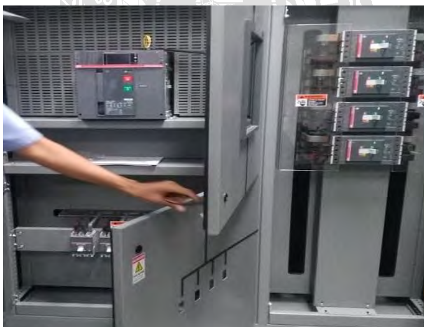
รูปที่ 4.14 การติดตั้ง Circuit Breaker
