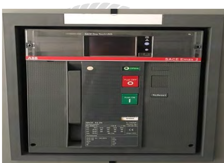
รูปที่ 4.12 ACB (Air Circuit Breaker)
