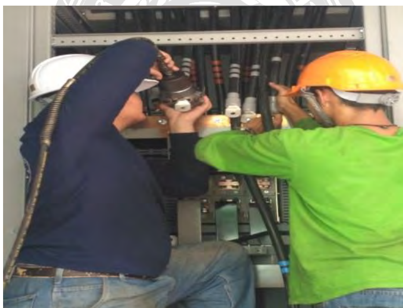
รูปที่ 4.22 สายไฟจากหม้อแปลงมาที่ MDB 24 เส้น
