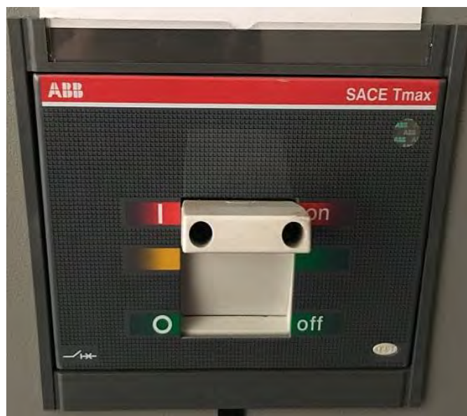
รูปที่ 4.13 MCCB (Molded Case Circuit Breaker) การติดตั้งเซอร์กิตเบรกเกอร์ในตู้ MDB สามารถแสดงได้ดังรูปที่ 4.14
