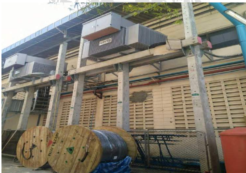
รูปที่ 4.10 การติดตั้งหม้อแปลงบนนั่งร้านนอกอาคาร
