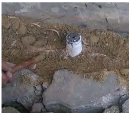
รูปที่ 4.30 การต่อหลักดินด้วยชุดเบ้าหลอมหลักดิน Exothermic Welding
