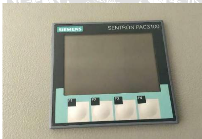
รูปที่ 4.17 จอแสดง Digital Panel Meter
