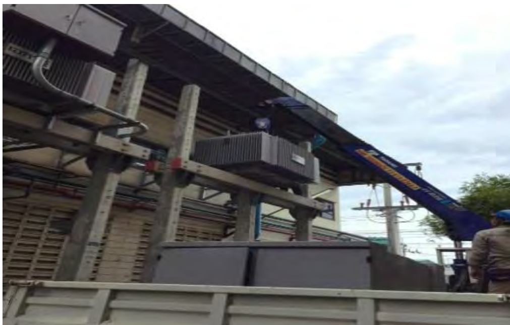
รูปที่ 4.9 การติดตั้งหม้อแปลงบนนั่งร้านนอกอาคาร
