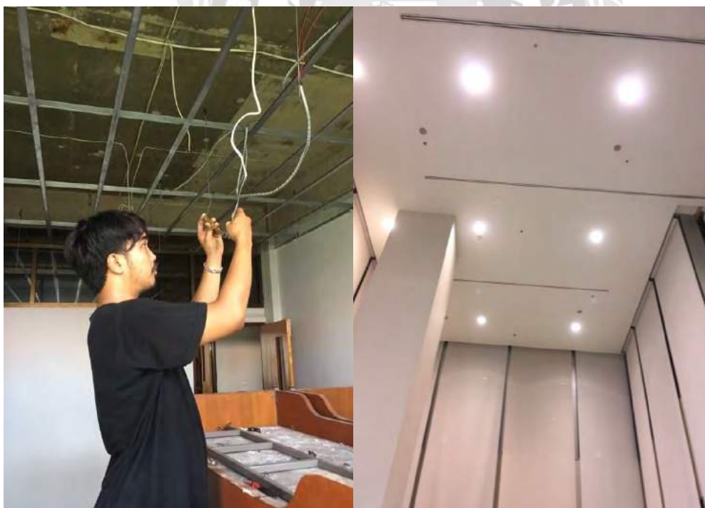
รูปที่ 4.3.4 ทดสอบการควบคุมระบบแสงสว่างแต่ละจุดภายในห้อง
