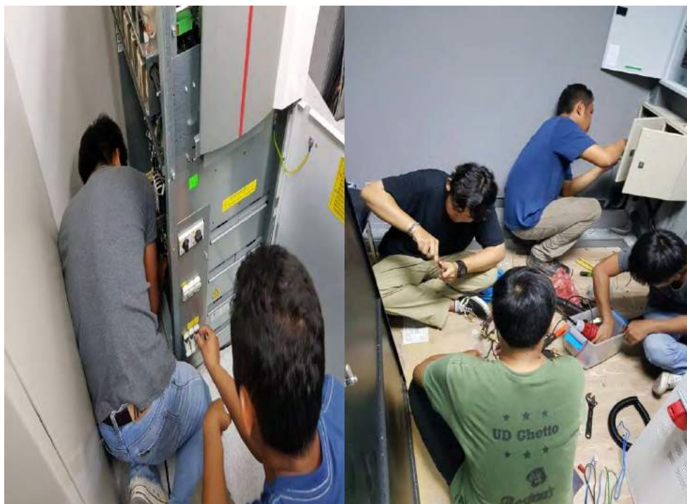
รูปที่ 4.3.1 การตรวจสอบวงจรระบบไฟฟ้า
