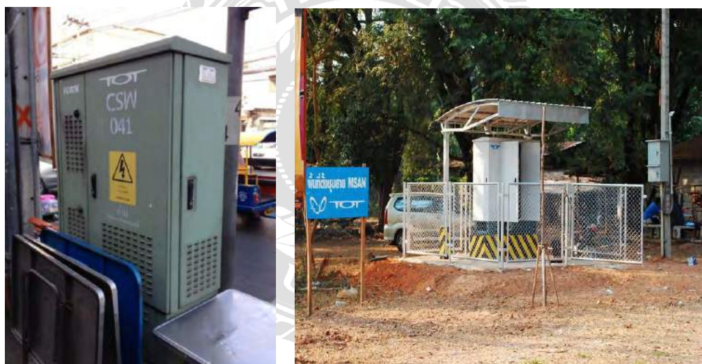
รูปที่ 2.35 MSAN เหมือนเป็นชุมสายขนาดเล็กที่แยกออกมาจากชุมสายใหญ่
