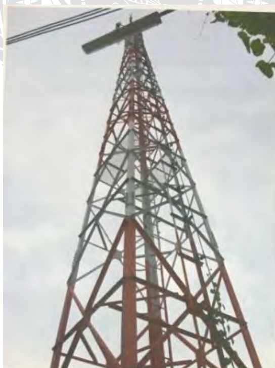
รูปที่ 2.32 สถานีฐานแบบ On Ground
