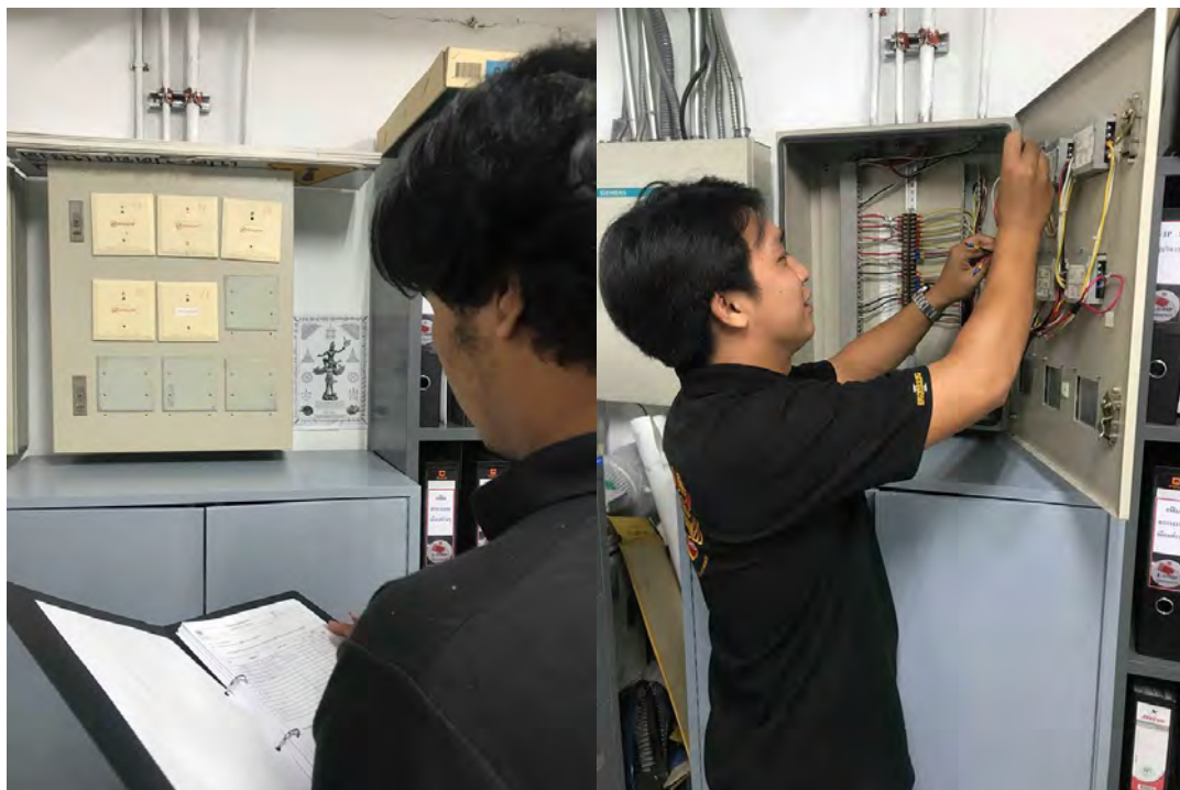
รูปที่ 4.5 ตรวจสอบระบบ Fire Alarm System
