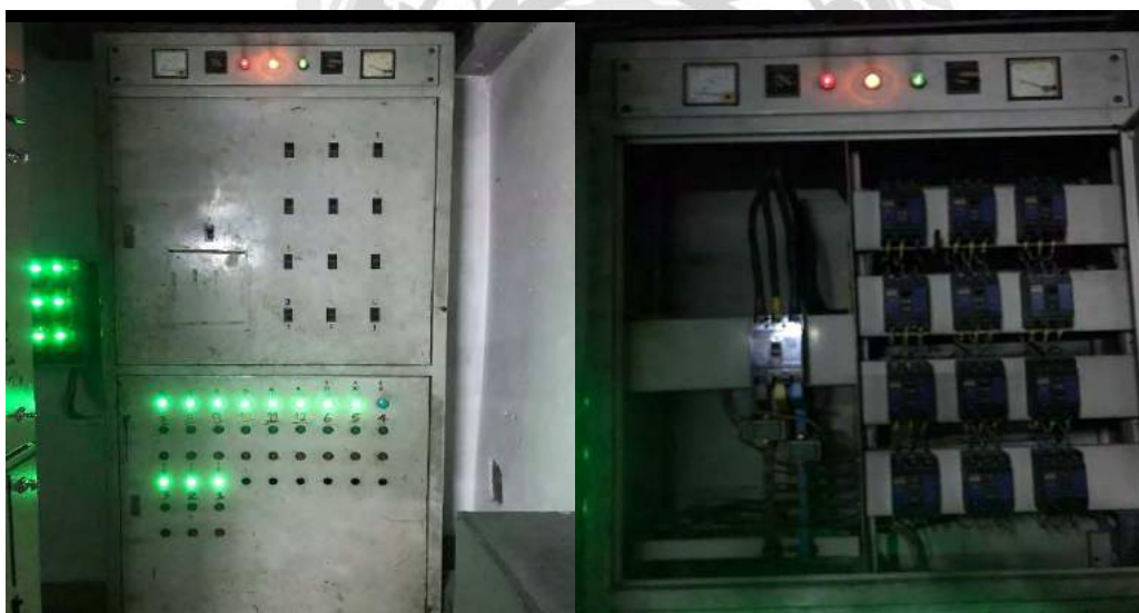
รูปที่ 4.15 เครื่องปรับอากาศ PAC และตู้ควบคุม
