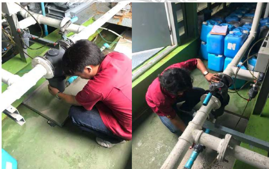
รูปที่ 4.40 เปลี่ยนไส้กรองของระบบน้ำบำบัด
