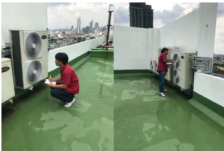
รูปที่ 4.43 ตรวจสอบความปกติของ Compressor
