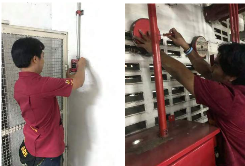
รูปที่ 4.7 ทำการ Test Manual Key และ กระดิ่ง Bell
