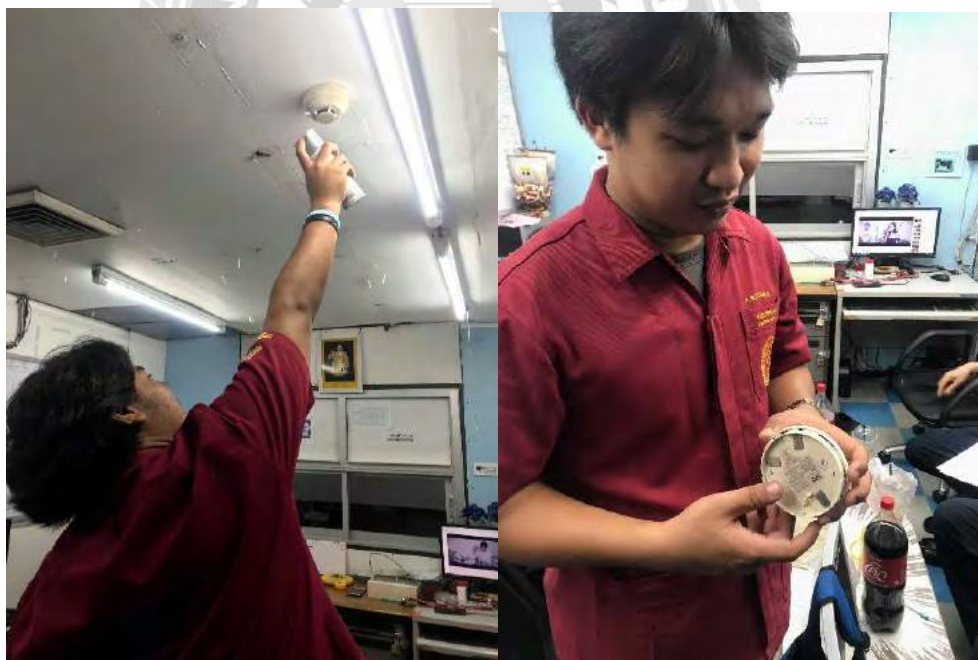
รูปที่ 4.6 ทำการ Test Smoke Detector
