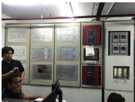
รูปที่ 2.3 ตู้ Fire Alarm Systems รุ่น MS-9600LS
