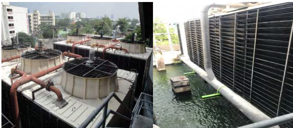
รูปที่ 4.16 หอระบายความร้อน CT
