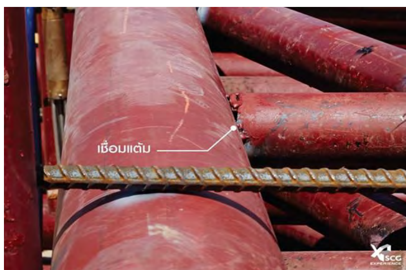
รูปที่ 2.3 การเชื่อมเต็มเพื่อช่วยยึดเหล็กไว้ชั่วคราว
