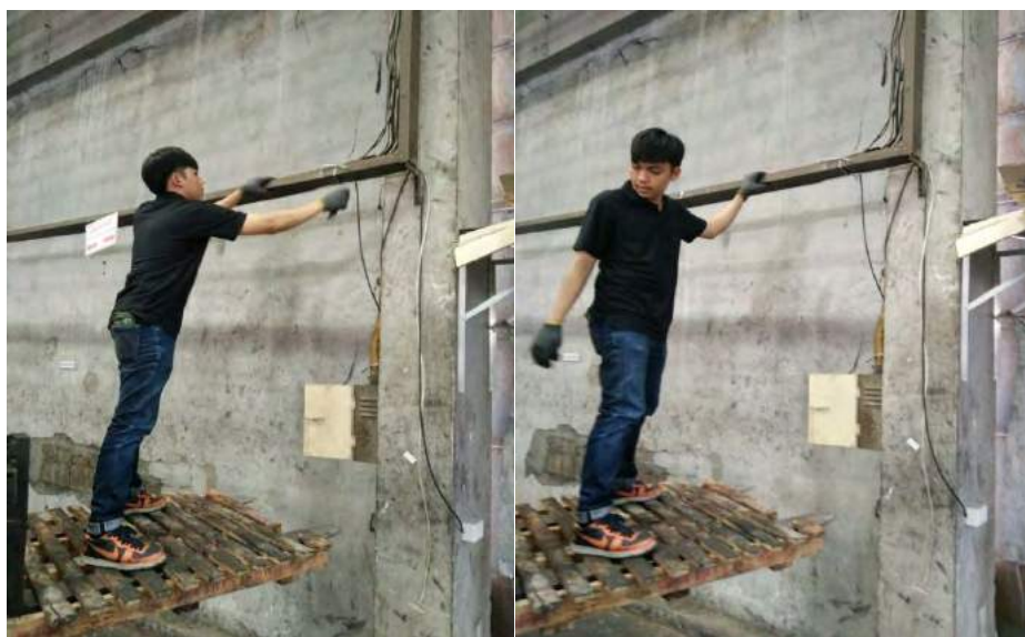
รูปที่ 4.57 จัดเก็บสายไฟใส่ราง
