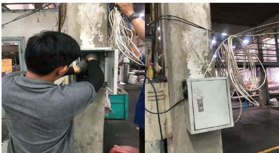
รูปที่ 4.55 ติดตั้งย้ายกล่องสายแลนอินเทอร์เน็ต
