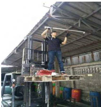
รูปที่ 4.49 ติดตั้งหลอดไฟ
