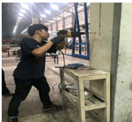
รูปที่ 4.52 เจาะเสาเพื่อจะทำการติดตั้งเครื่องกรองน้ำ
