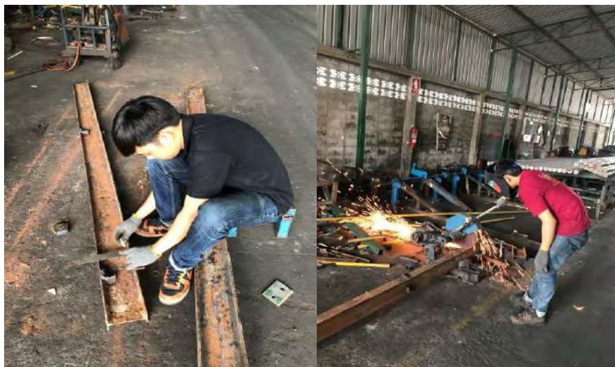
รูปที่ 4.27 ทำการวัดชิ้นงานทุกส่วนและทำการตัดชิ้นงาน
