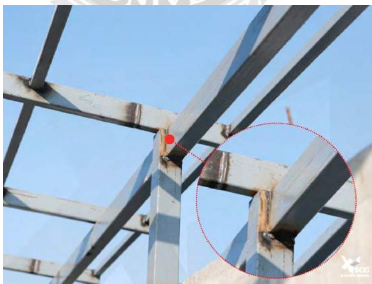
รูปที่ 2.2 การเชื่อมเต็มโครงสร้างหลังคาเหล็ก
