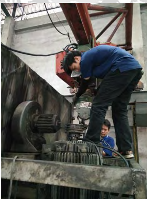
รูปที่ 4.60 จัดตั้งวางเพลลาใบพัดลม
