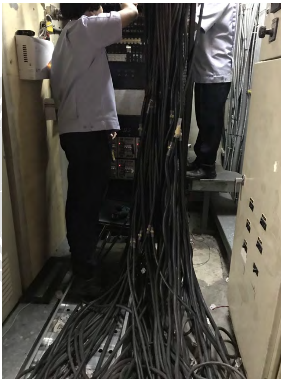
รูปที่ 4.11 ภาพขณะที่กำลังซ่อมบำรุงห้องไฟบริเวณชั้น 3
