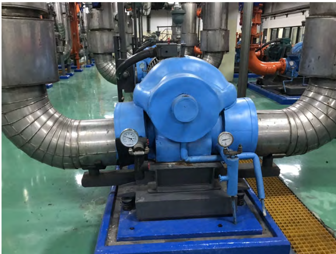
รูปที่ 2.6 เครื่องสูบน้ำแบบหอยโข่งที่ใช้ทางด้านฝั่งน้ำเย็น
