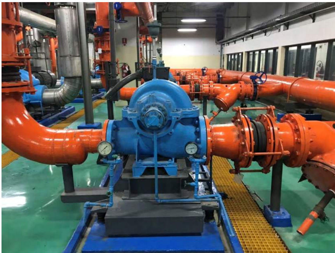
รูปที่ 2.5 เครื่องสูบน้ำแบบหอยโข่งที่ใช้ทางฝั่งน้ำร้อน
