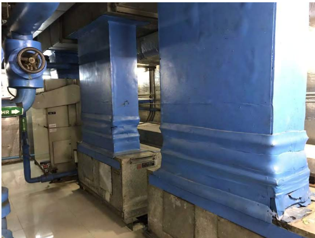
รูปที่ 2.11 FCU ( Fan Coil Unit)
