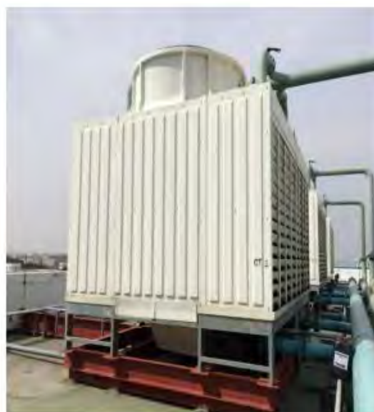
รูปที่ 2.8 Cooling Tower แบบการไหลตั้งฉาก
