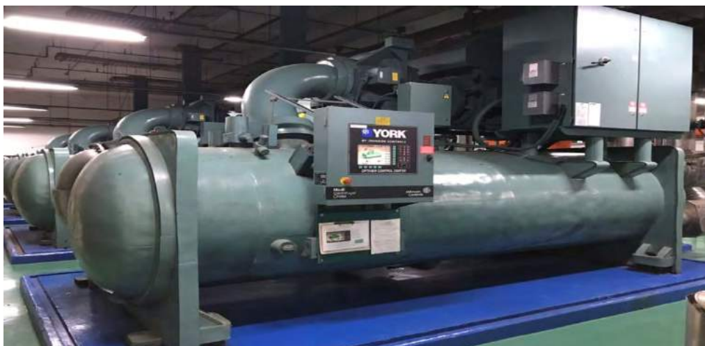
รูปที่ 2.2 เครื่องทำความเย็น York ขนาด 1000 ตัน
