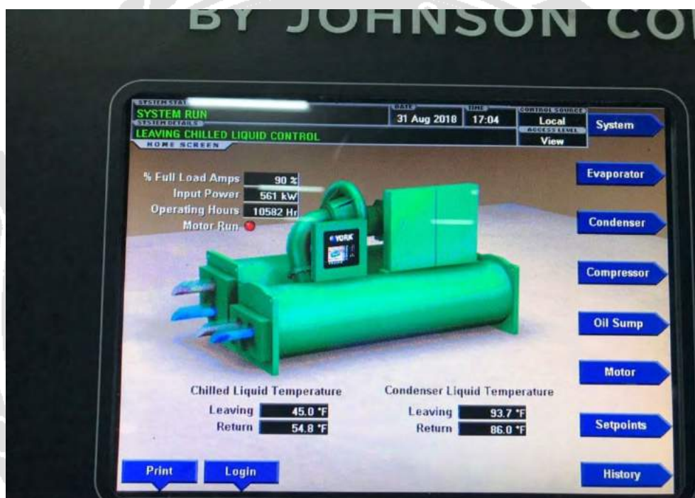
รูปที่ 4.5.1 หน้าจอ Home Screen ของเครื่อง Chiller
