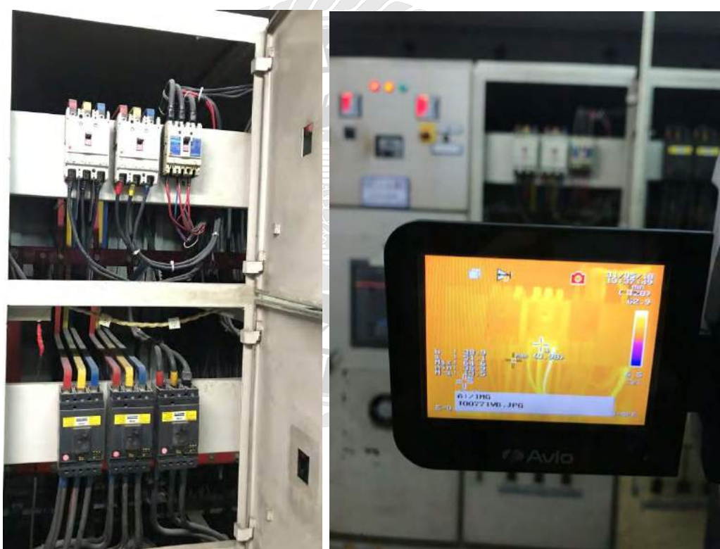
รูปที่ 4 เนื่องจากระบบไฟฟ้าภายในของผู้ใช้ไฟฟ้าขัดข้องเพียงรายเดียวจึงจำเป็นต้องดำเนินการตรวจสอบจุดต่อโดยใช้กล้อง Thermo scan
