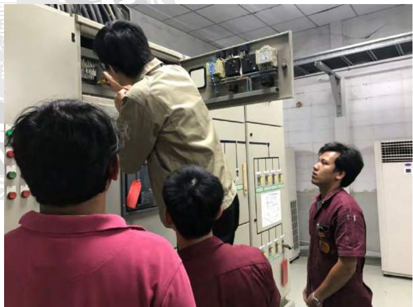
รูปที่ 8 ขั้นตอนการติดตั้ง PQ Meter (Power Quality Meter) ขณะมีโหลดและ ต้องลำดับเฟสให้ ถูกต้องเพื่อให้ PQ Meter มีประสิทธิภาพสูงสุด
