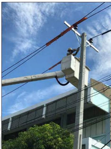
รูปที่ 4.20 การติดตั้งคอนและลูกถ้วย
