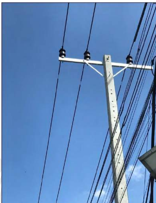
รูปที่ 4.22 สายป้อนไฟฟ้าหลังปฏิบัติงาน
