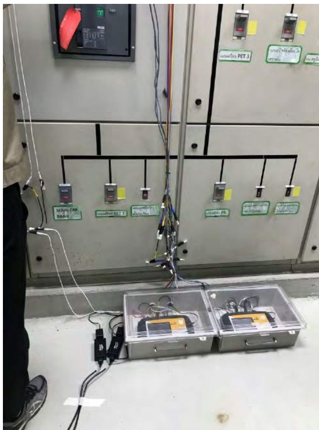
รูปที่ 10 ติดตั้งกล่องอุปกรณ์ป้องกันการกระแทกและความชื้นในตัว PQ Meter (Power Quality Meter) จะมีแบตเตอรี่ Backup ได้ขณะไฟฟ้าดับได้ 30 นาทีและบันทึกข้อมูลได้ถึง 6 เดือน
