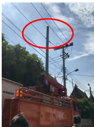
รูปที่ 4.17 เสาไฟฟ้าก่อนดำเนินงาน
