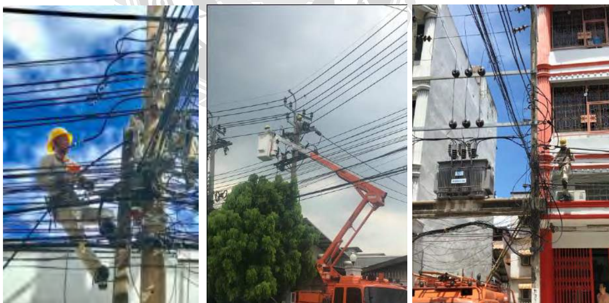
รูปที่ 2 หลังจากผู้ปฏิบัติงานรับงาน ดำเนินการแก้ไขไฟฟ้าขัดข้อง
