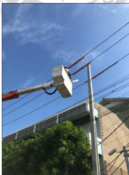
รูปที่ 4.19 การติดตั้งอุปกรณ์ป้องกัน
