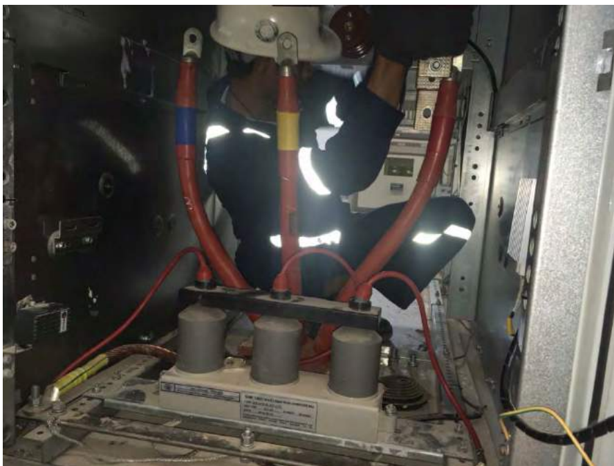
รูปที่ 4.10 ข้ำหัวสายก่อนเข้าบัสบาร์
