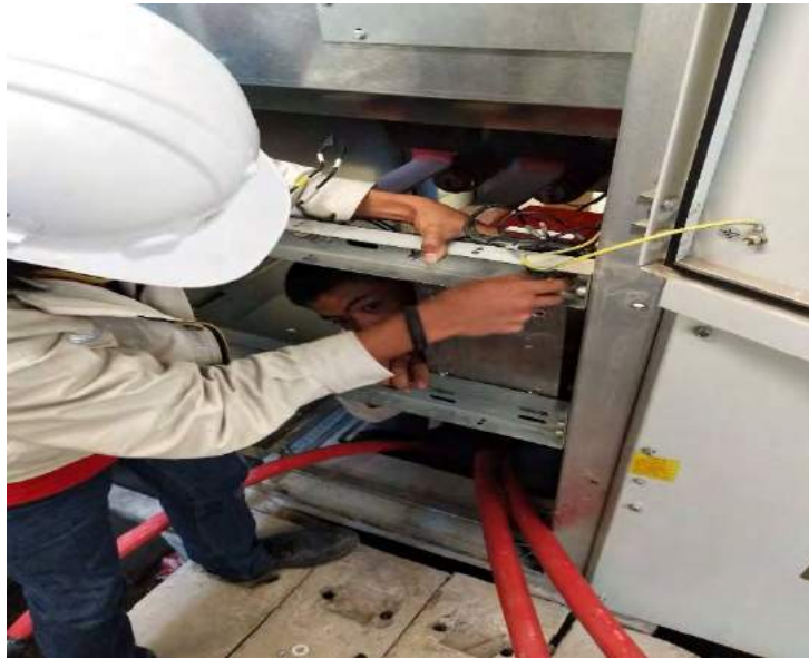
รูปที่ 4.14 เปลี่ยน Current Transformer
