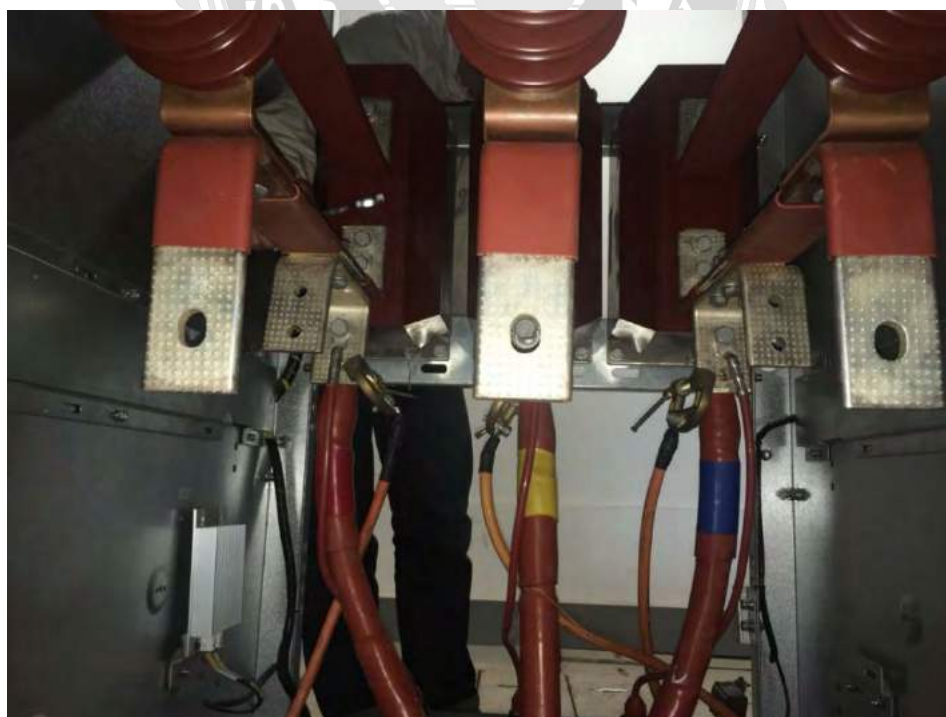
รูปที่ 4.13 นำสาย Power Cable เข้าจุดต่อ BusBar
