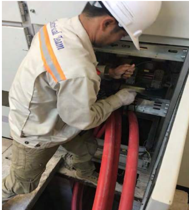
รูปที่ 4.8 นำสายเข้าตู้ควบคุม
