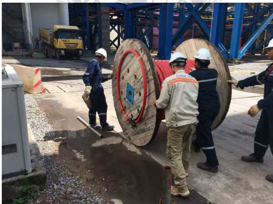
รูปที่ 4.7 ตรวจสอบเช็คสายไฟก่อนปฏิบัติงาน
