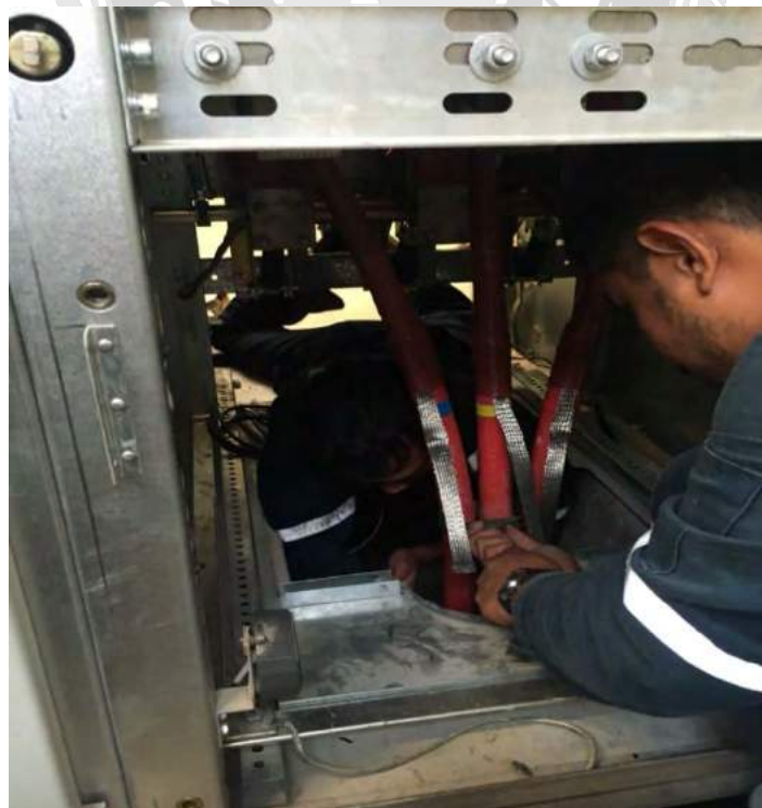
รูปที่ 4.9 ติดอุปกรณ์ป้องกันสายชำรุด
