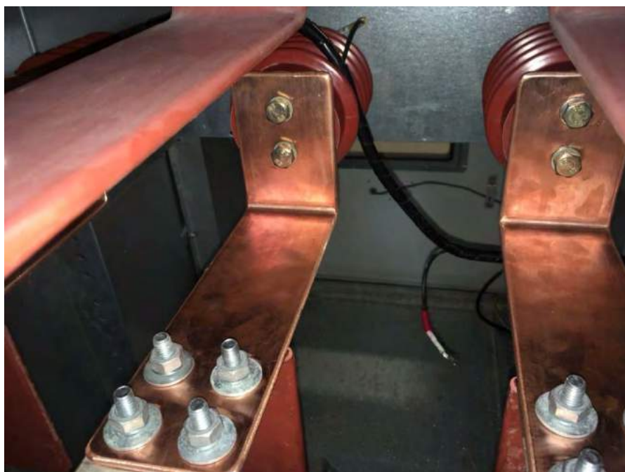
รูปที่ 4.12 ติดตั้งบัสบาร์ชุดใหม่
