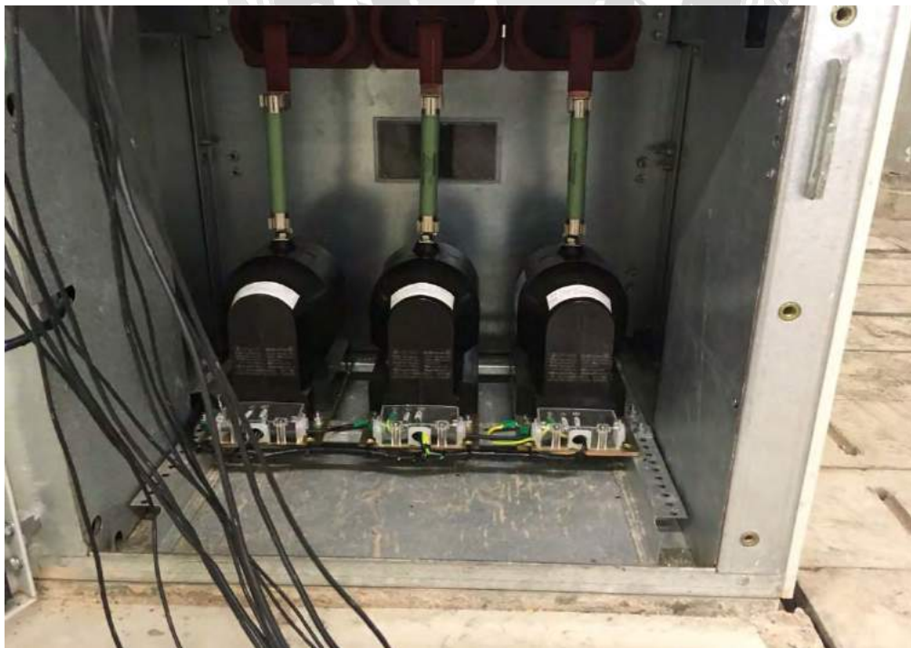
รูปที่ 4.15 ติดตั้ง Potential Transformer
