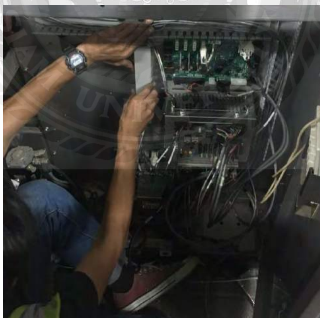
รูปที่ 4.26 การถอดสายเก่าภายในเคท
