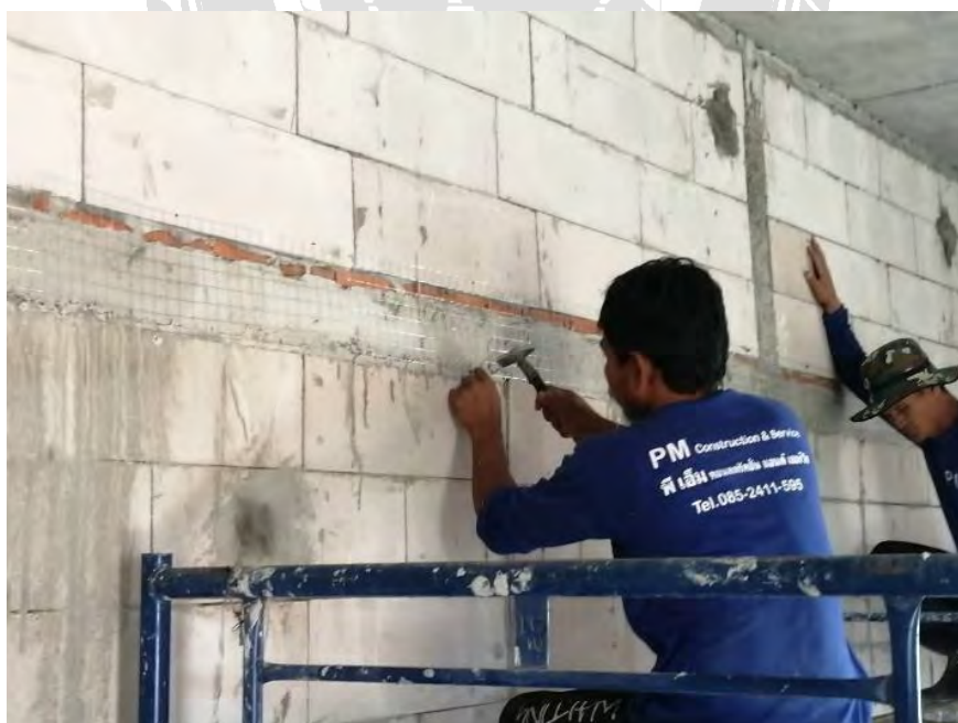
รูปที่ 4.5.2 (ค) ติดกรงไก่
