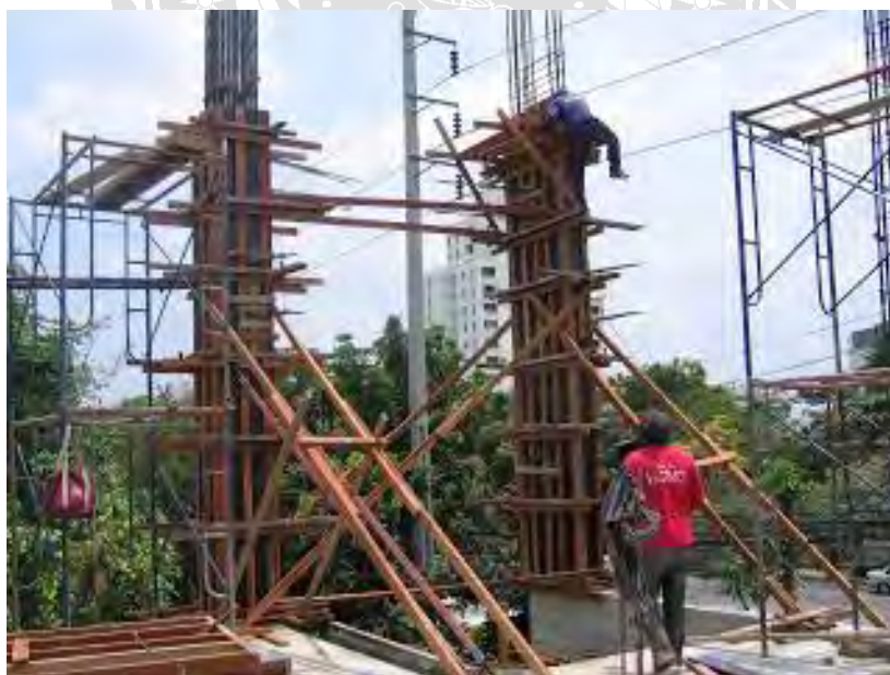
รูปที่ 4.4.12 เข้าแบบเสา
