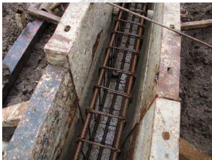
ภาพผนวกรูปที่ 22 เข้าแบบคาน
