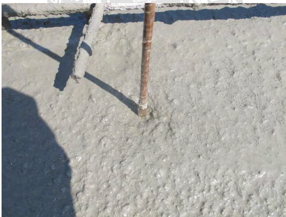
รูปที่ 4.4.8(ก) ตรวจสอบระดับคอนกรีตด้วยไม้ที่พื้นเทไป
