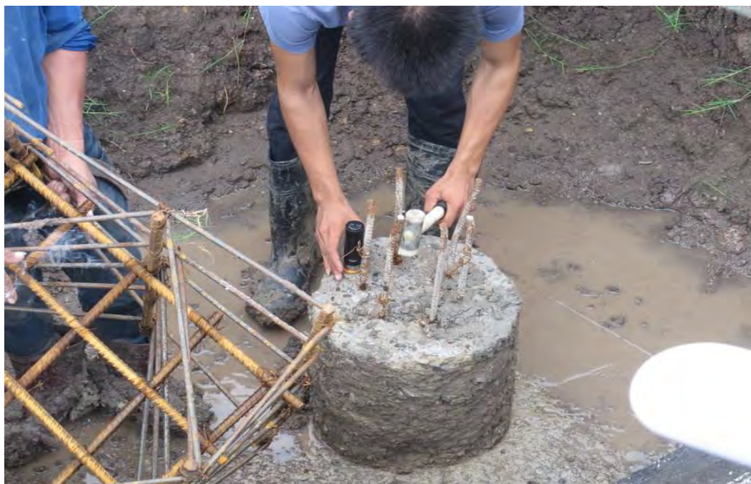
รูปที่ 4.4.5 ตรวจสอบเสาเข็มโดยวิธี Seismic test (ก.)
