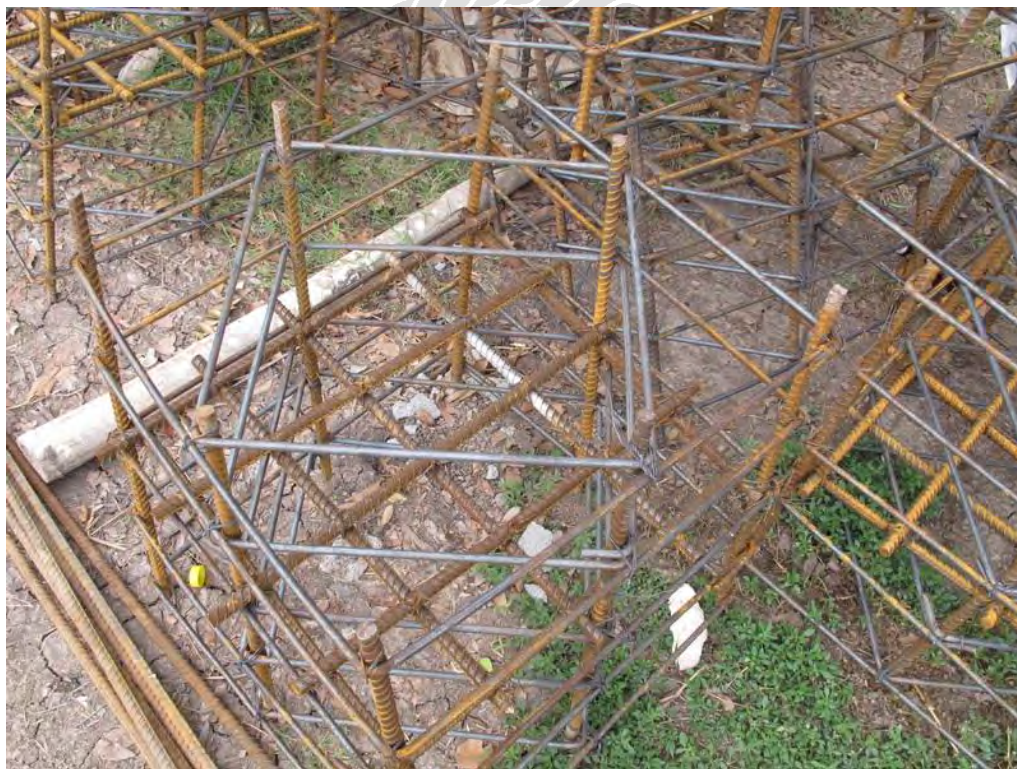
ภาพผนวกรูปที่ 9 ผูกเหล็กฐานราก
