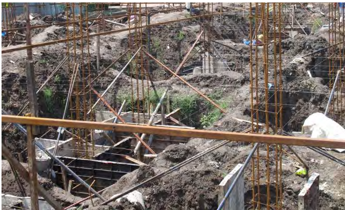
ภาคผนวกรูปที่ 12 ติดตั้งเสาฐานราก
