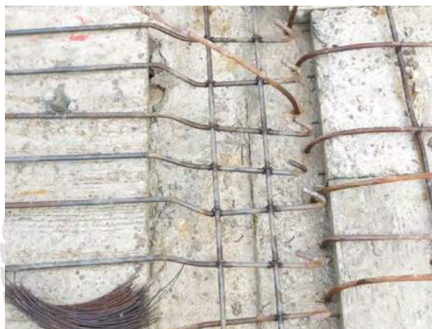
ภาคผนวกรูปที่ 28 ผูกเหล็กพื้น
