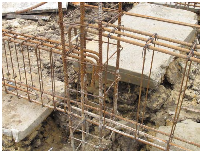
ภาพผนวกรูปที่ 21 การผูกเหล็กคาน
