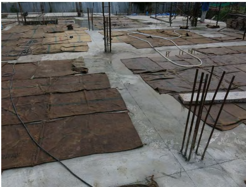
รูปที่ 4.4.11(ง) การบ่มคอนกรีตด้วยกระสอบป่าน
