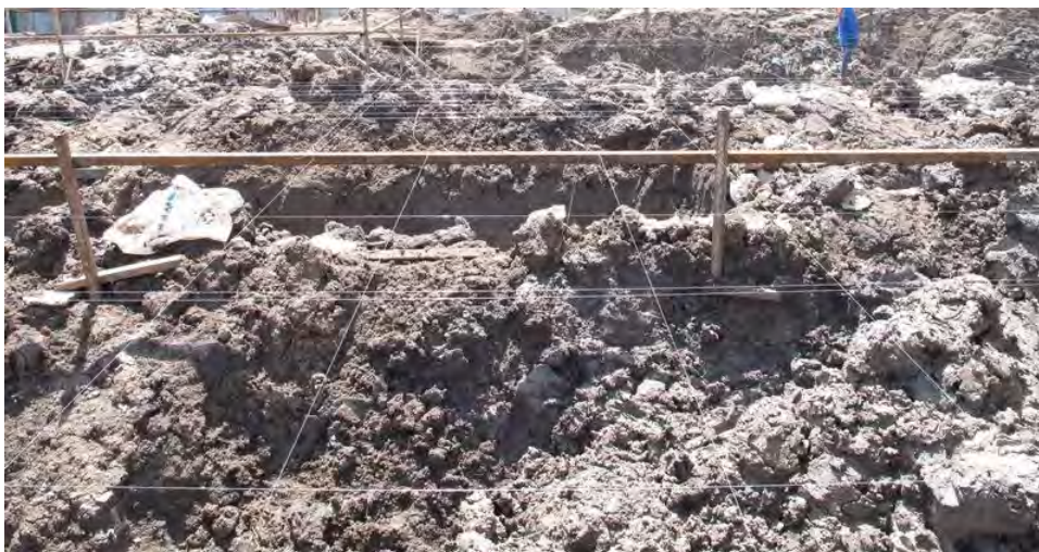
รูปที่ 4.4.4 การยิงเอ็นเพื่อสร้างเป็นแนวจำลอง
