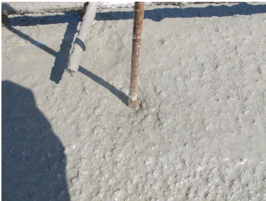
ภาคผนวกรูปที่ 16 ตรวจสอบระดับคอนกรีตด้วยไม้ที่พันเทปใส
