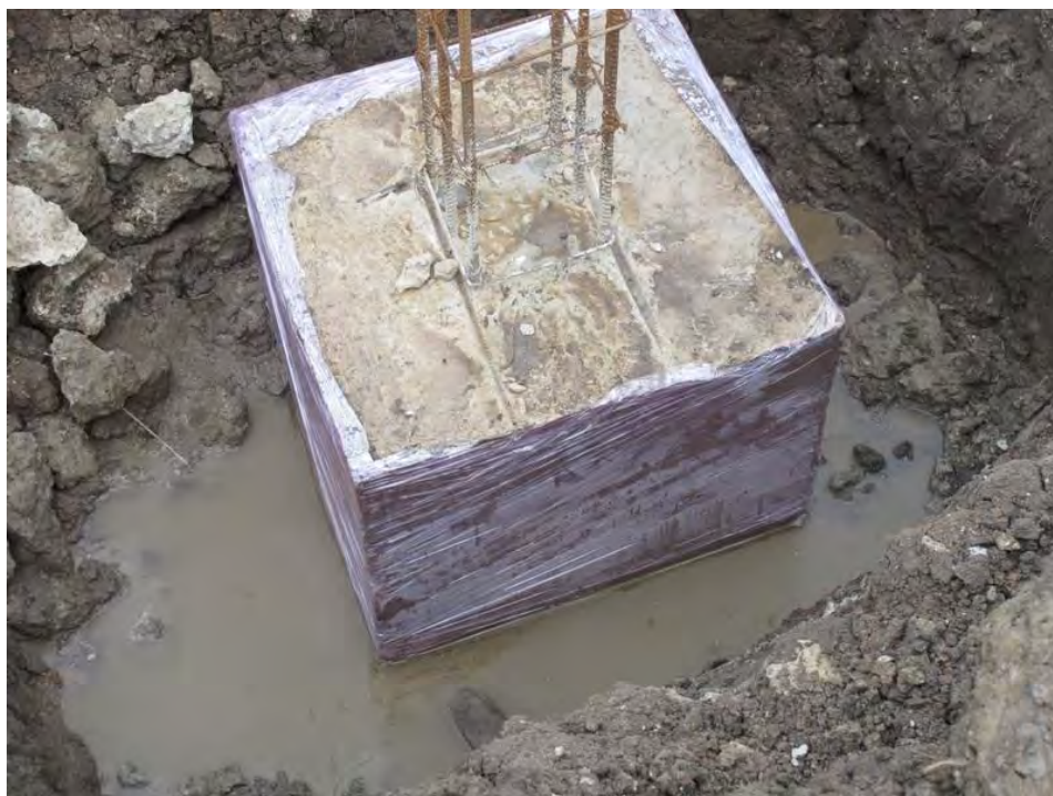
รูปที่ 4.4.9 การบ่มคอนกรีตด้วยวิธีห่อพลาสติก
