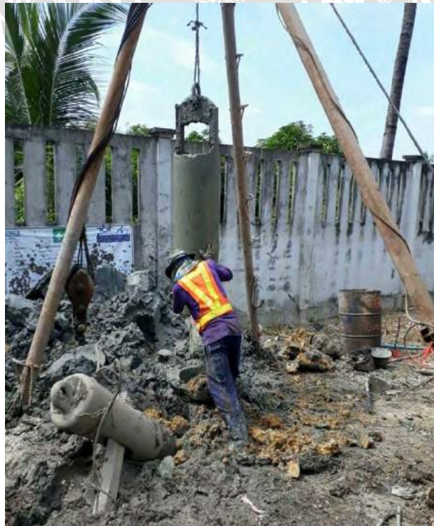
ภาคผนวกรูปที่ 2 ตอกเสาเข็มแบบสามขา
