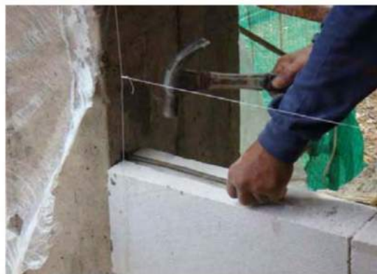
รูปที่ 4.5.1(ง) ยึดผนังโดยใช้เหล็ก
