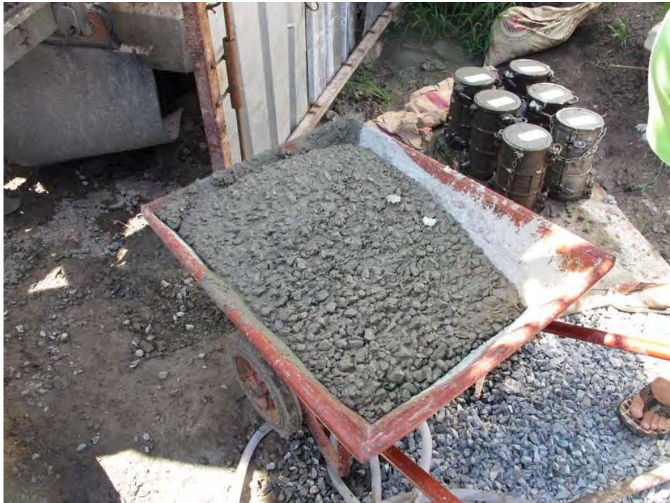
ภาพผนวกรูปที่ 14 การตรวจ Slump
