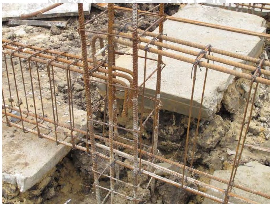
รูปที่ 4.4.9(ก) การผูกเหล็กคาน
