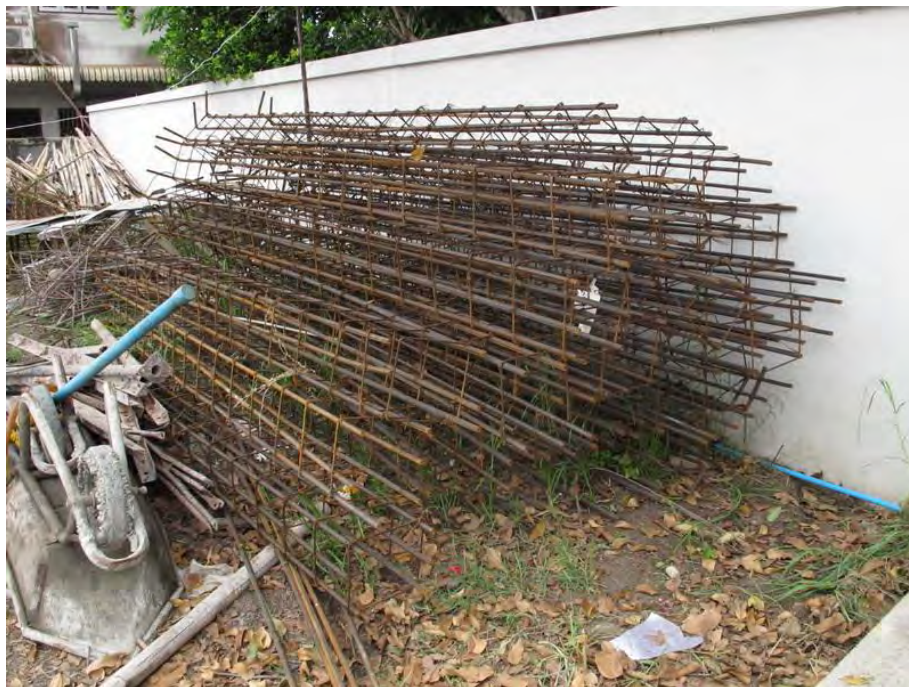
ภาคผนวกรูปที่ 10 ผูกเหล็กเสา
