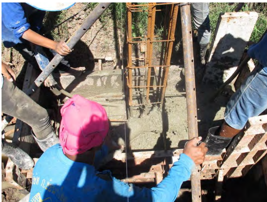
รูปที่ 4.4.8 การเทคอนกรีตลงฐานราก
