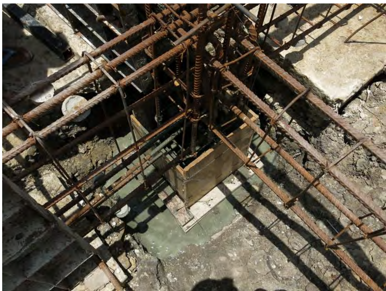
รูปที่ 4.4.10 เข้าแบบเสาตอม่อ
