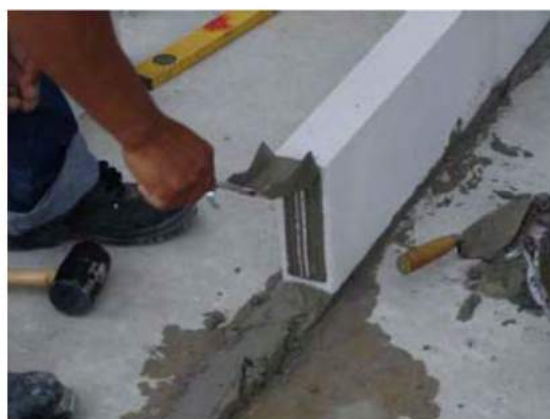
รูปที่ 4.5.1(ข) การปาดด้านข้างอิฐมวลเบา
