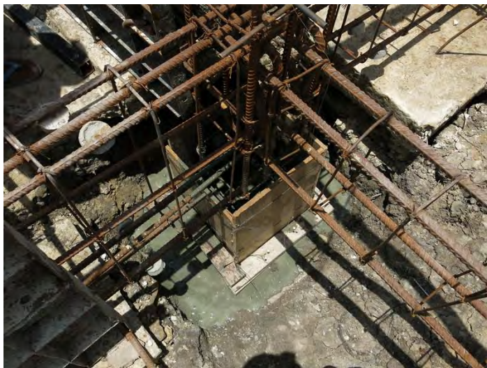
ภาพผนวกรูปที่ 24 เข้าแบบเสาตอม่อ
