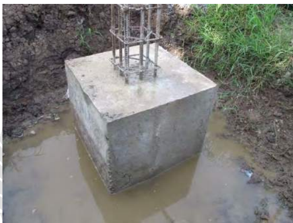
ภาคผนวกรูปที่ 19 ฐานรากหลังจากถอดแบบ
