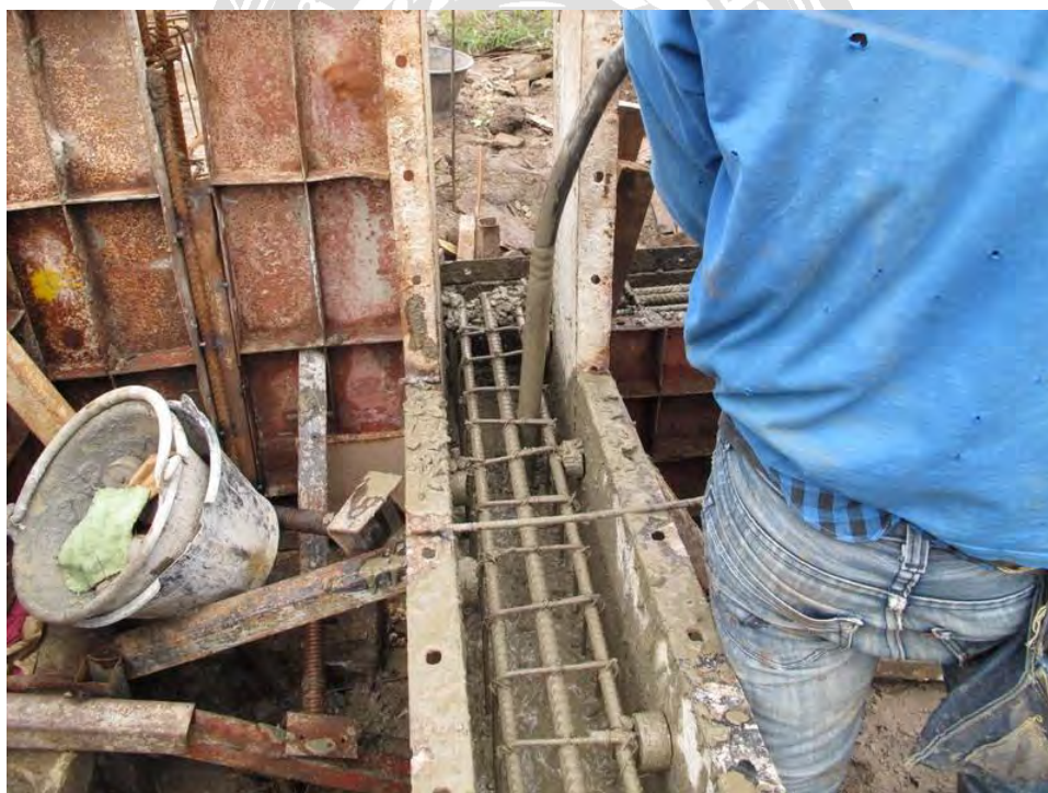
รูปที่ 4.4.9(ค) เทคอนกรีต
