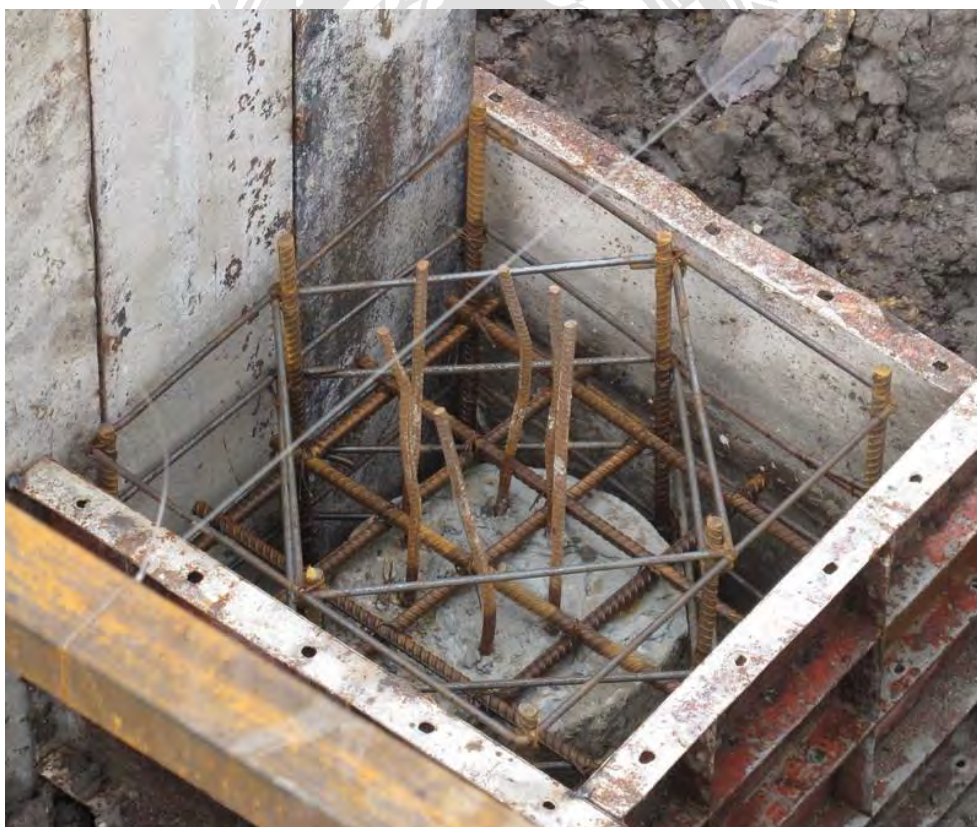
ภาคผนวกรูปที่ 11 เข้าแบบฐานราก
