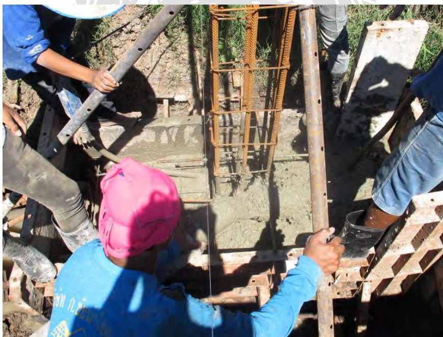
ภาพผนวกรูปที่ 15 การเทคอนกรีตลงฐานราก
