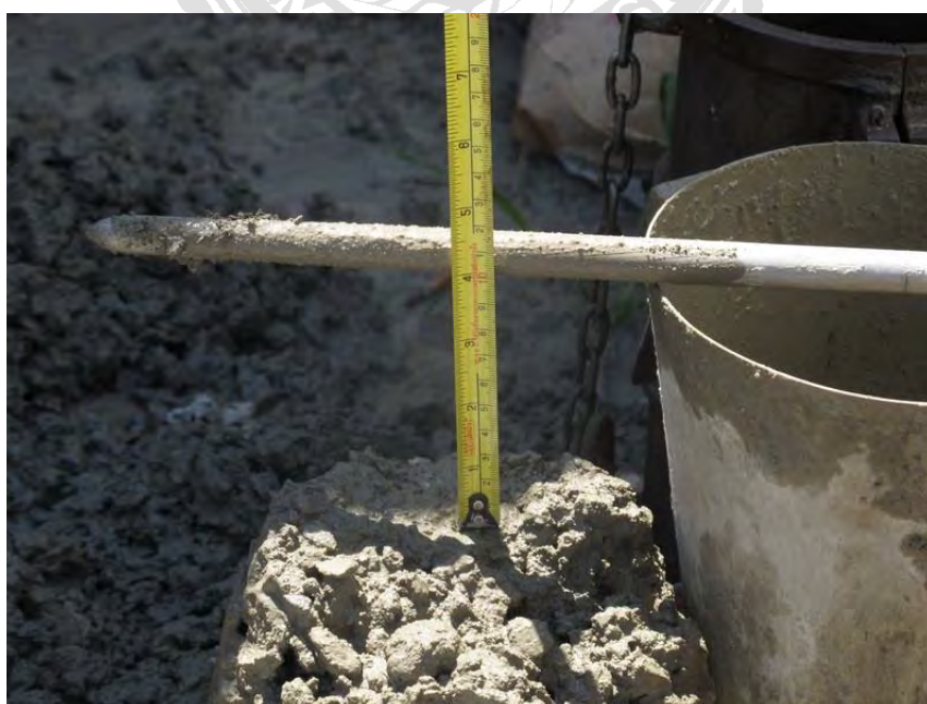
รูปที่ 4.4.7 การตรวจ Slump (ข.)
