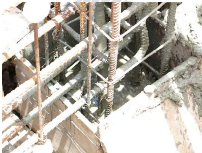
ภาพผนวกรูปที่ 25 เทคอนกรีตเสาตอม่อ
