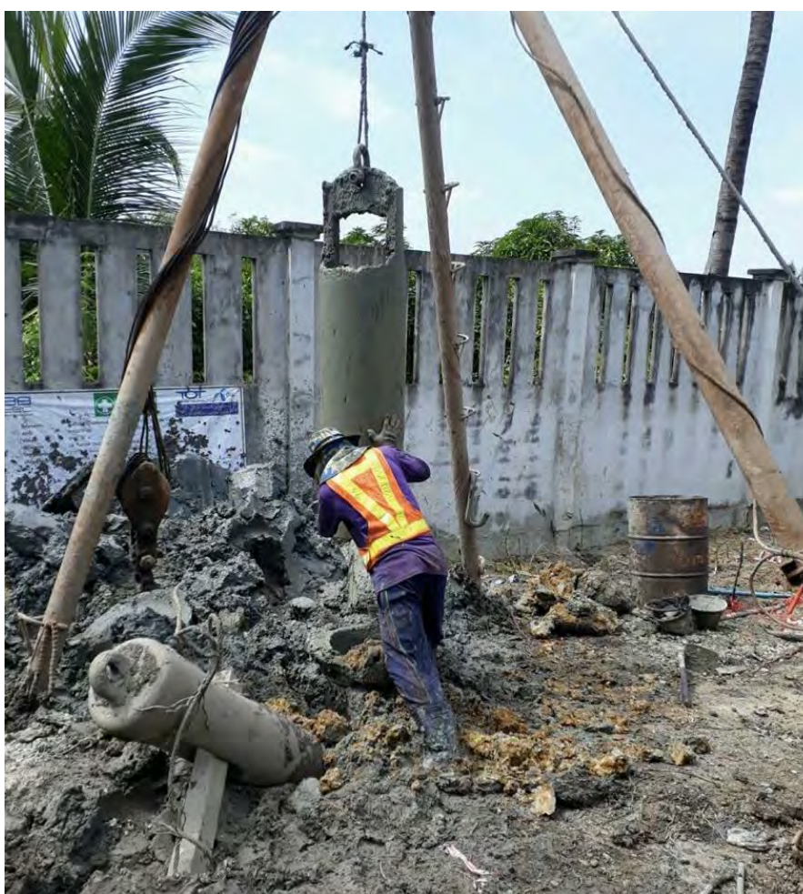
รูปที่ 4.4.2 ตอกเสาเข็มแบบสามขา
