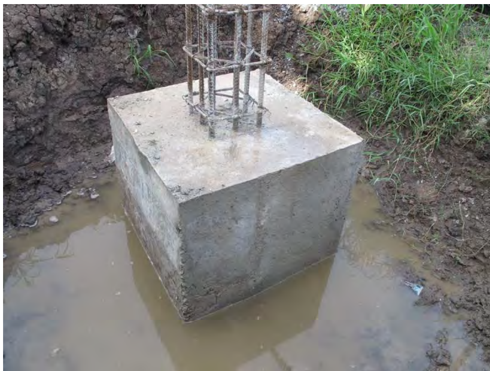
รูปที่ 4.4.8(ง) ฐานรากหลังจากถอดแบบ
