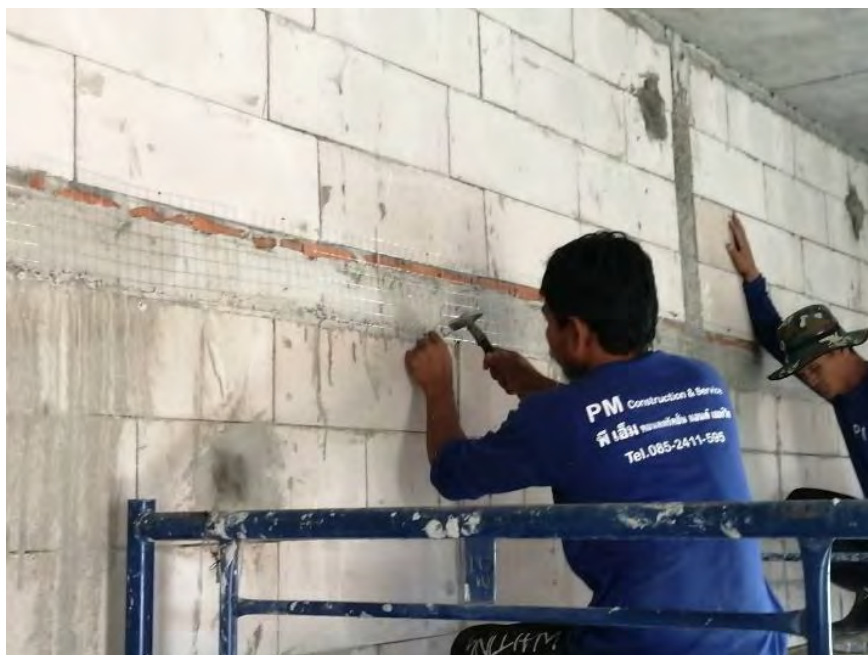
ภาคผนวกรูปที่ 40 ติดกรงไก่
