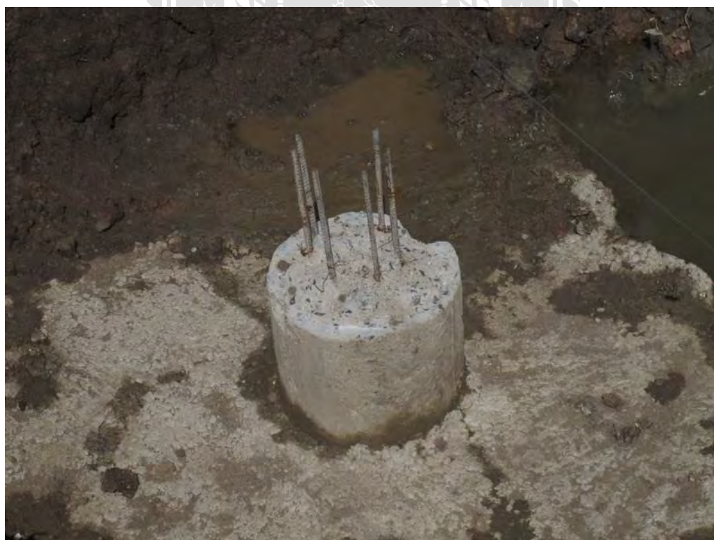
รูปที่ 4.4.3(ก) ตัดหัวเข็มแล้วเสร็จ
