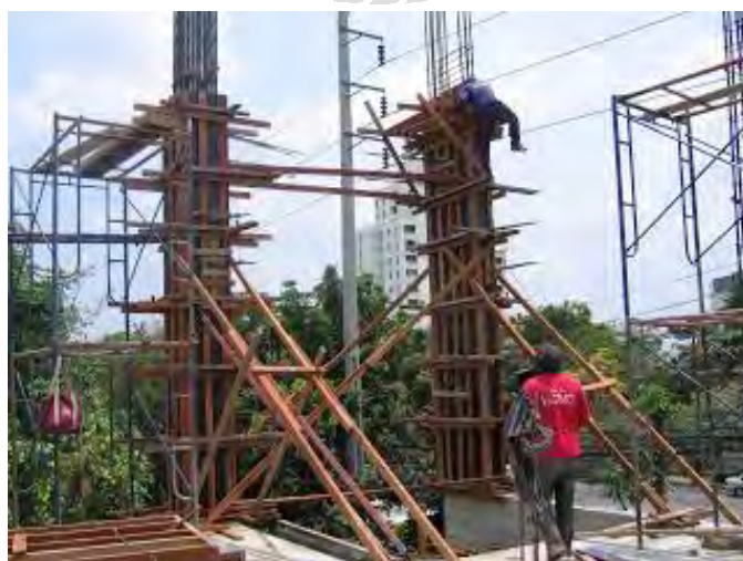
ภาคผนวกรูปที่ 32 เข้าแบบเสา
