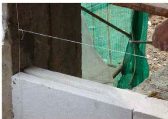
รูปที่ 4.5.1(ง) ยึดผนังโดยใช้เหล็ก
