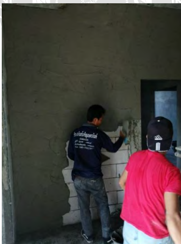
ภาคผนวกรูปที่ 39 ฉาบภายใน
