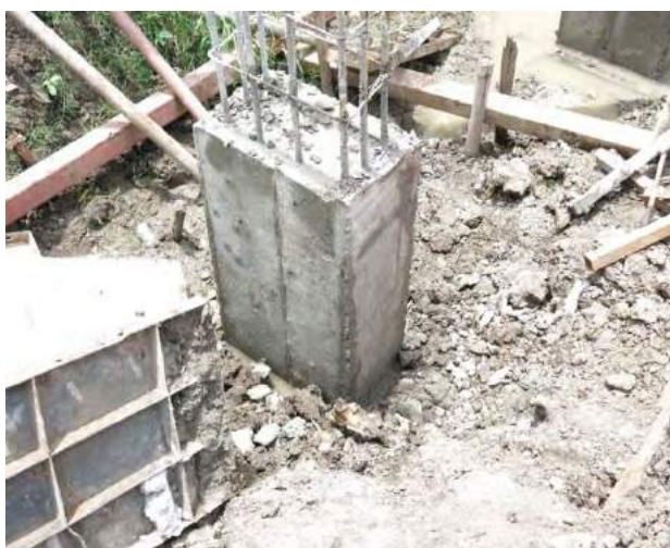
ภาพผนวกรูปที่ 26 หลังจากแกะแบบเสาตอม่อ
