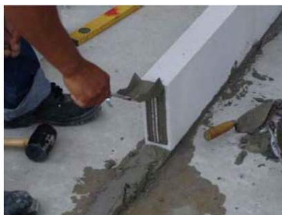
ภาคผนวกรูปที่ 35 การป้ายด้านข้างอิฐมวลเบา
