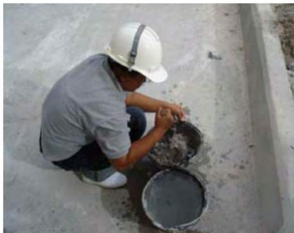
ภาคผนวกรูปที่ 33 การผสมปูนก่อ
