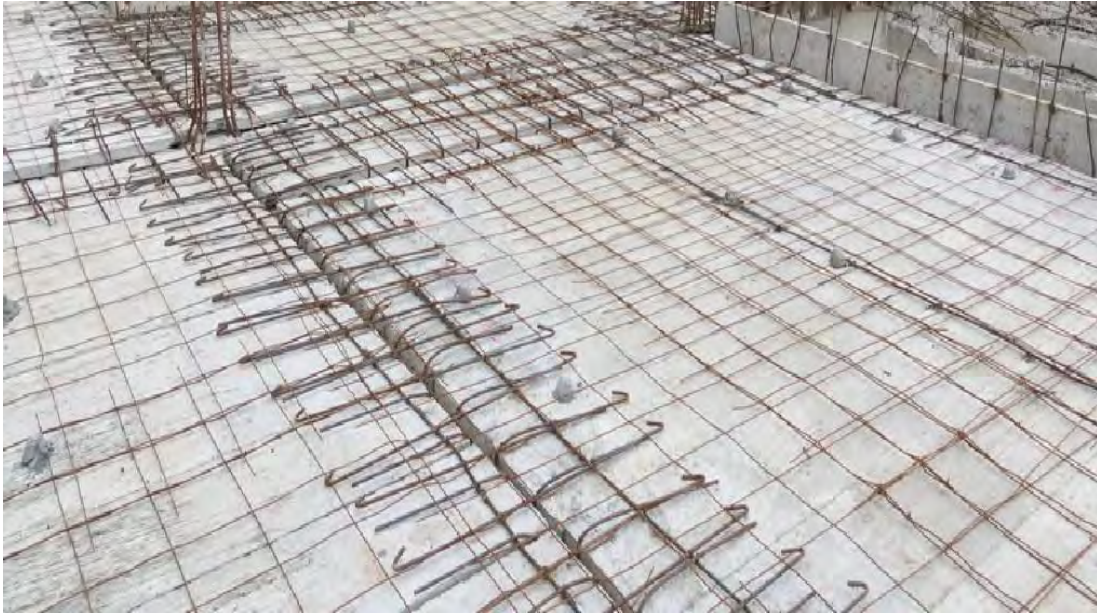
รูปที่ 4.4.11(ข) ปูเหล็ก wire mesh
