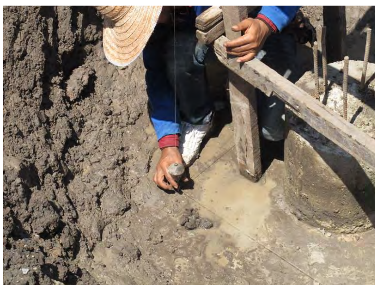
ภาพผนวกรูปที่ 6 การดึงจากแนวเอ็นลงมายังบริเวณเข็ม
