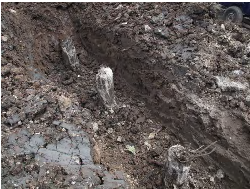
รูปที่ 4.4.3 เปิดหน้าดินเตรียมตัดหัวเข็ม
