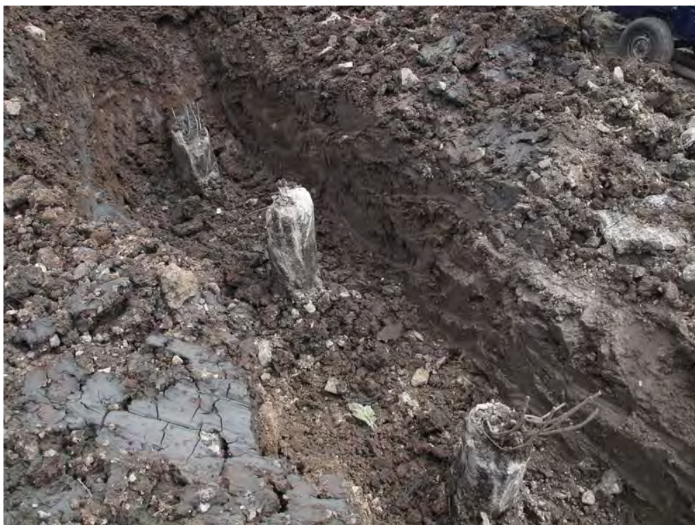
ภาคผนวกรูปที่ 3 เปิดหน้าดินเตรียมตัดหัวเข็ม
