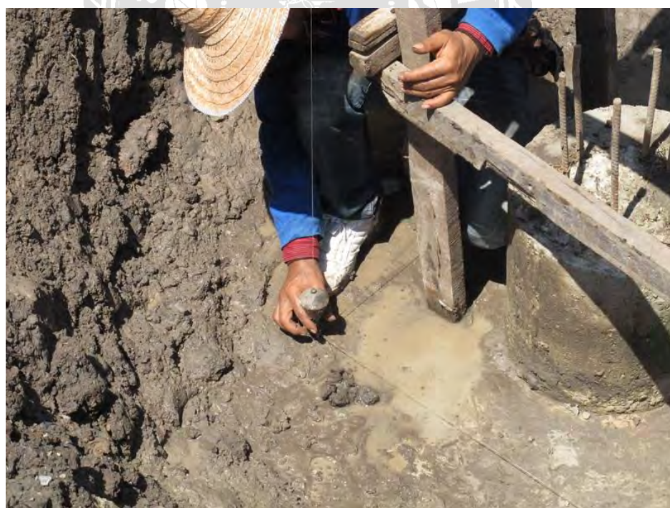
รูปที่ 4.4.4(ก) การดึงจากแนวเอ็นลงมายังบริเวณเข็ม
