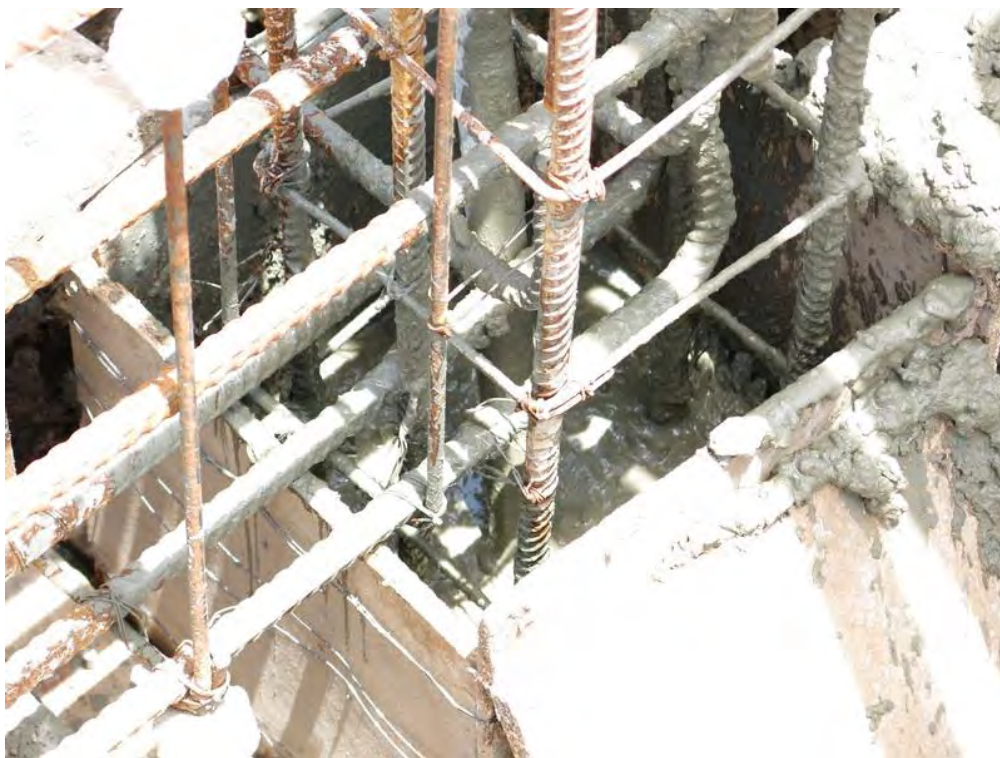
รูปที่ 4.4.10(ก) เทคอนกรีตเสาตอม่อ
