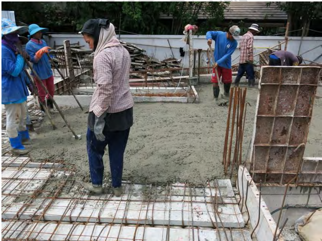
รูปที่ 4.4.11(ค) เทคอนกรีตบนพื้นสำเร็จ
