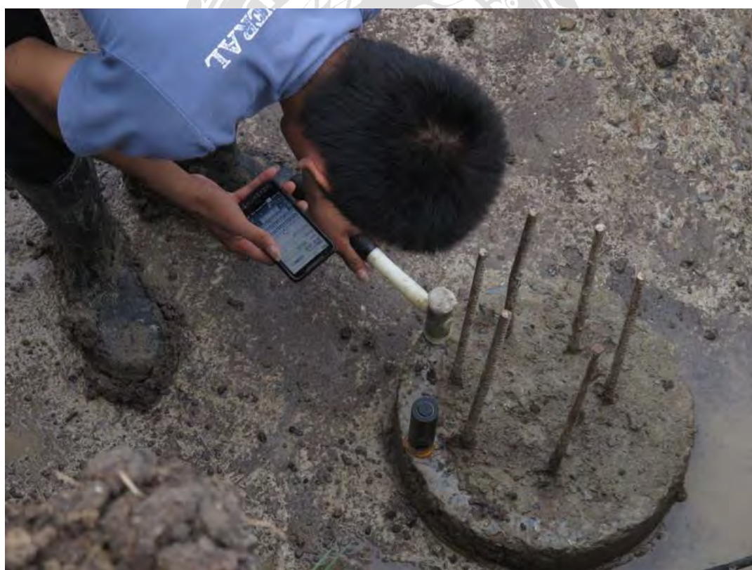
รูปที่ 4.4.5 ตรวจสอบเสาเข็มโดยวิธี Seismic test (ข.)
