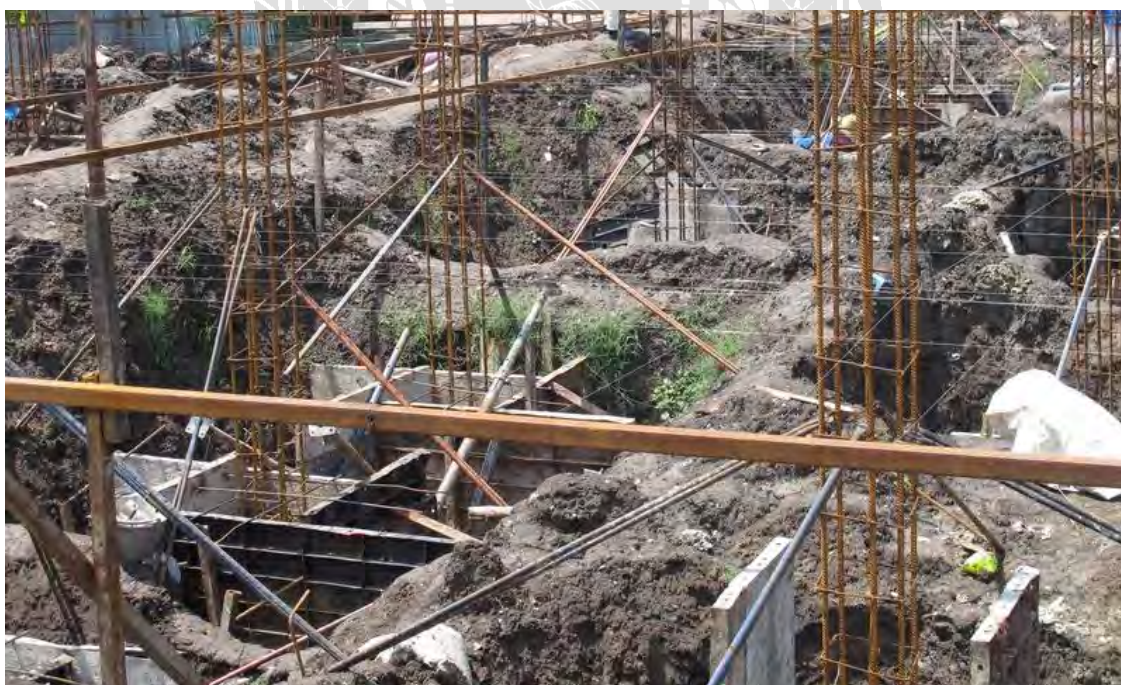
รูปที่ 4.4.6(ค) ติดตั้งเสาฐานราก
