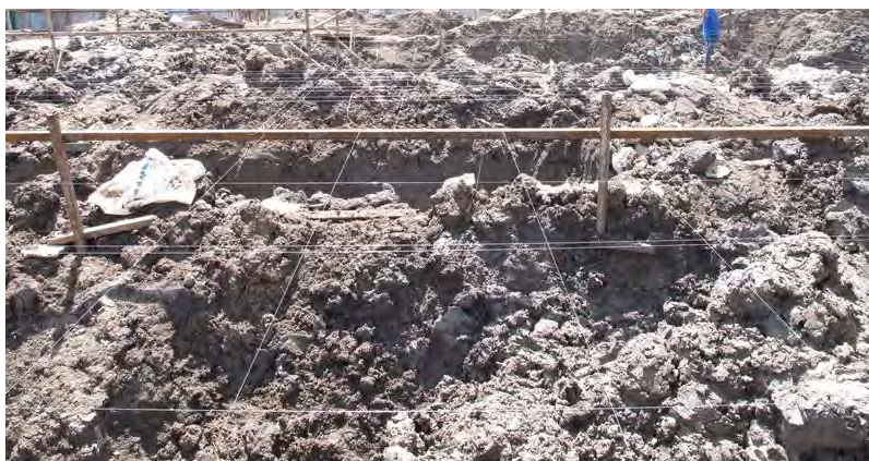
ภาพผนวกรูปที่ 5 การขึงเอ็นเพื่อสร้างเป็นแนวจำลอง
