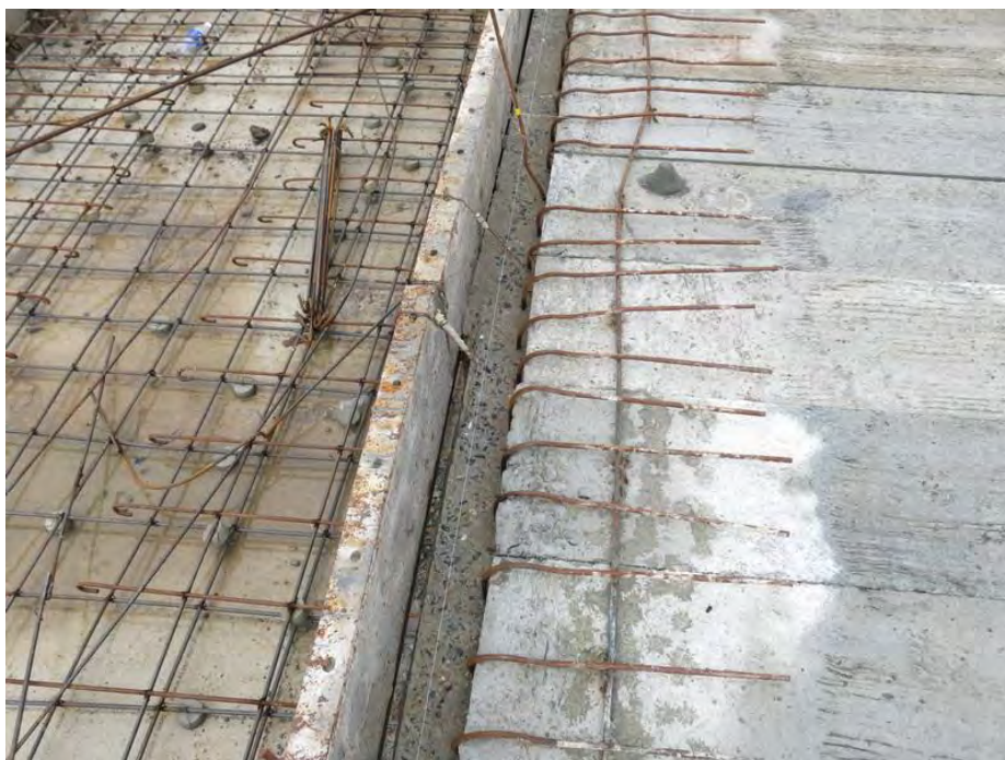
รูปที่ 4.4.11 เหล็กเสริมจากคานที่พับลงมา
