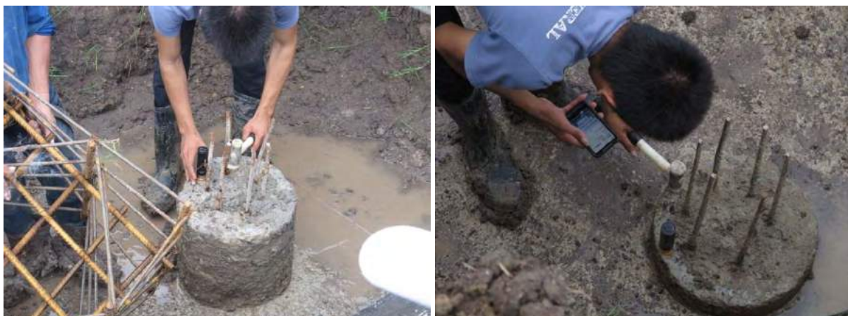
ภาพผนวกรูปที่ 8 ตรวจสอบเสาเข็มโดยวิธี Seismic test
