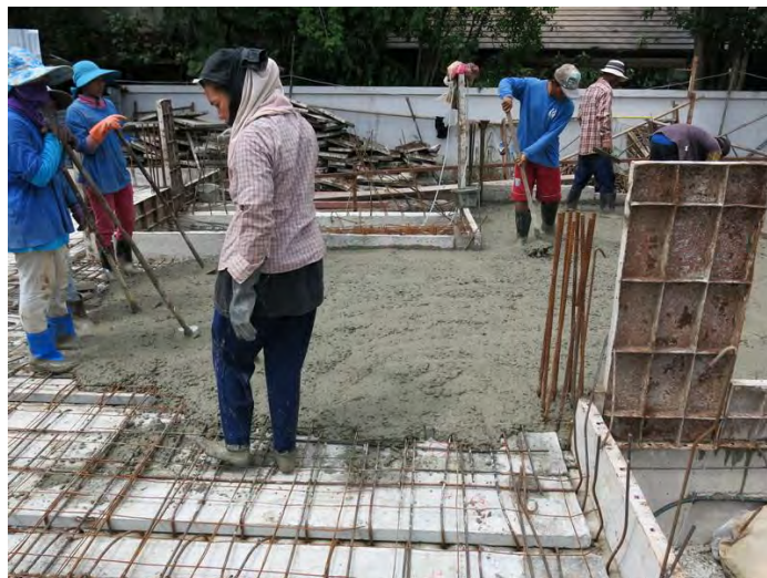
ภาคผนวกรูปที่ 30 เทคอนกรีตบนพื้นสำเร็จ
