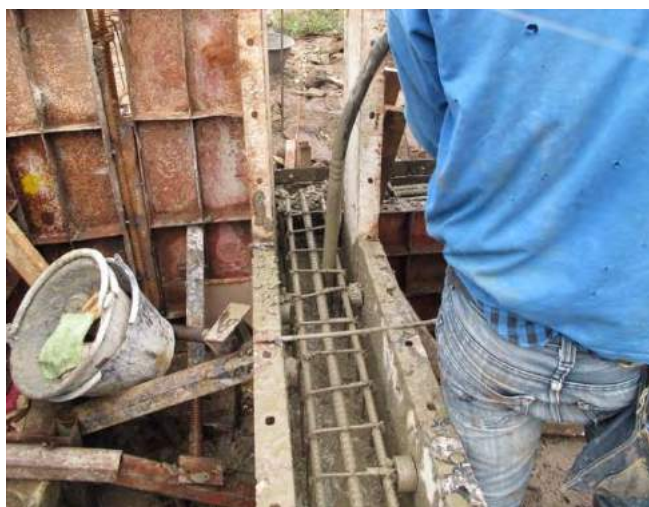
ภาพผนวกรูปที่ 23 เทคอนกรีต
