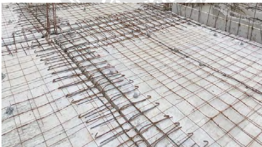
ภาคผนวกรูปที่ 29 ปูเหล็ก wire mesh
