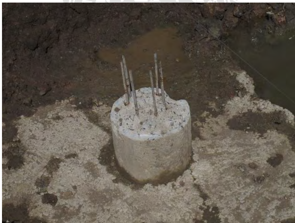
ภาคผนวกรูปที่ 4 ตัดหัวเข็มแล้วเสร็จ
