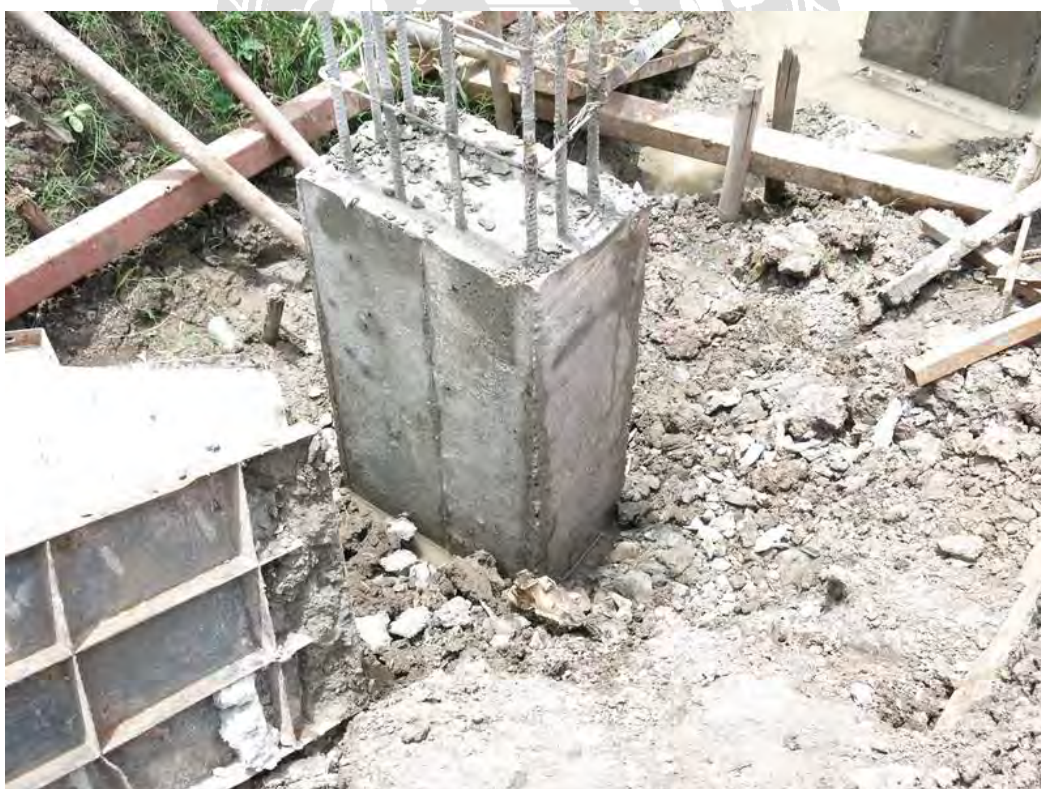
รูปที่ 4.4.10(ข) หลังจากแกะแบบเสาตอม่อ
