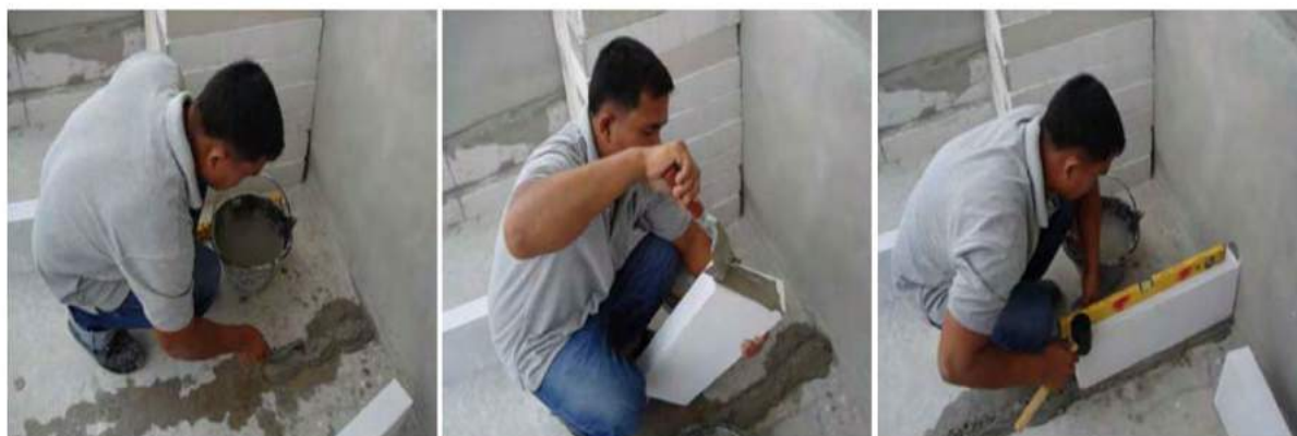
รูปที่ 4.5.1(ก) การปาดปูนที่พื้นและอิฐมวลเบา
