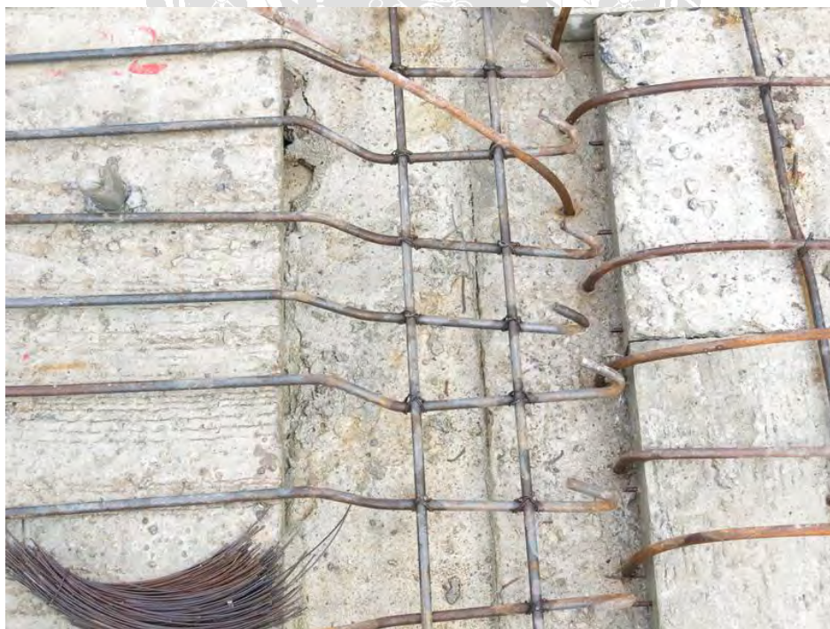
รูปที่ 4.4.11(ก) ผูกเหล็กพื้น
