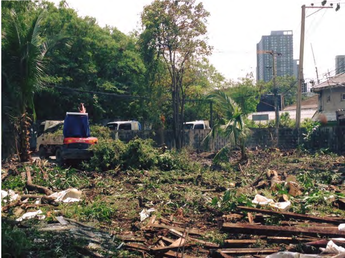
ภาคผนวกรูปที่ 1 เคลียพื้นที่หน้างาน
