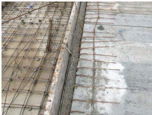
ภาคผนวกรูปที่ 27 เหล็กเสริมจากคานที่พับลงมา
