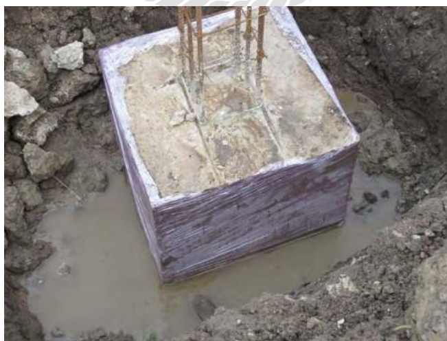
ภาคผนวกรูปที่ 20 การบ่มคอนกรีตด้วยวิธีห่อพลาสติก
