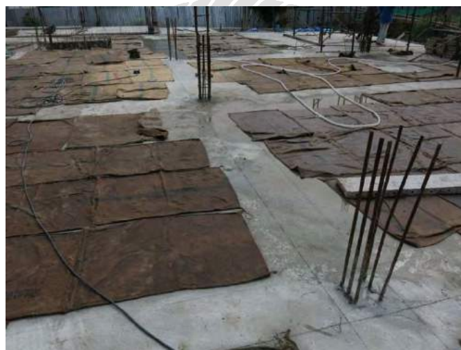
ภาคผนวกรูปที่ 31 การปั๊มคอนกรีตด้วยกระสอบป่าน
