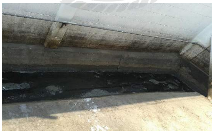
รูปที่ 1.8 สภาพจุดปล่อยน้ำออกนอกโรงงาน
