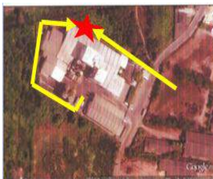
รูปที่ 3.1 ทางน้ำทิ้งสู่แหล่งระบายน้ำเสียในโรงงาน
