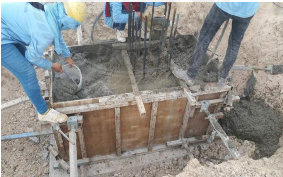
รูปที่ 3.2 ตัวอย่างความผิดพลาดในการให้ระดับฐานรากของ โครงสร้างนํ้างาน
