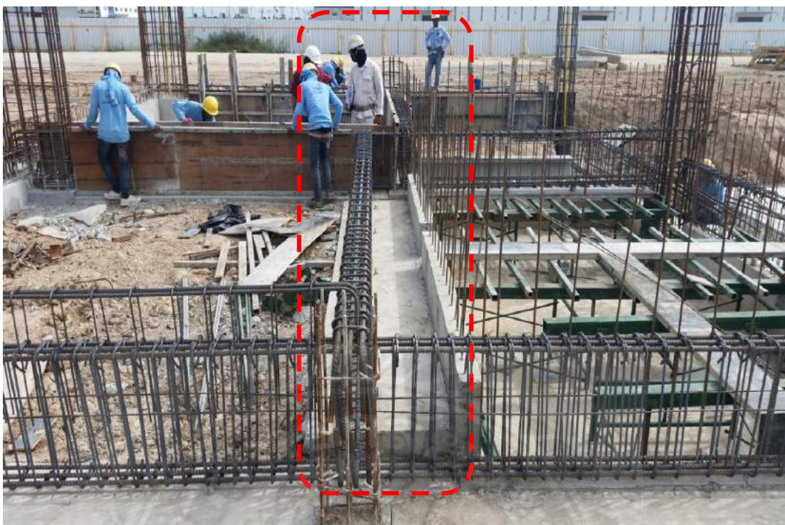
รูปที่ 3.1 ตัวอย่างการวางแนวคานฉัดพลาดของ โครงสร้างนํ้างาน
