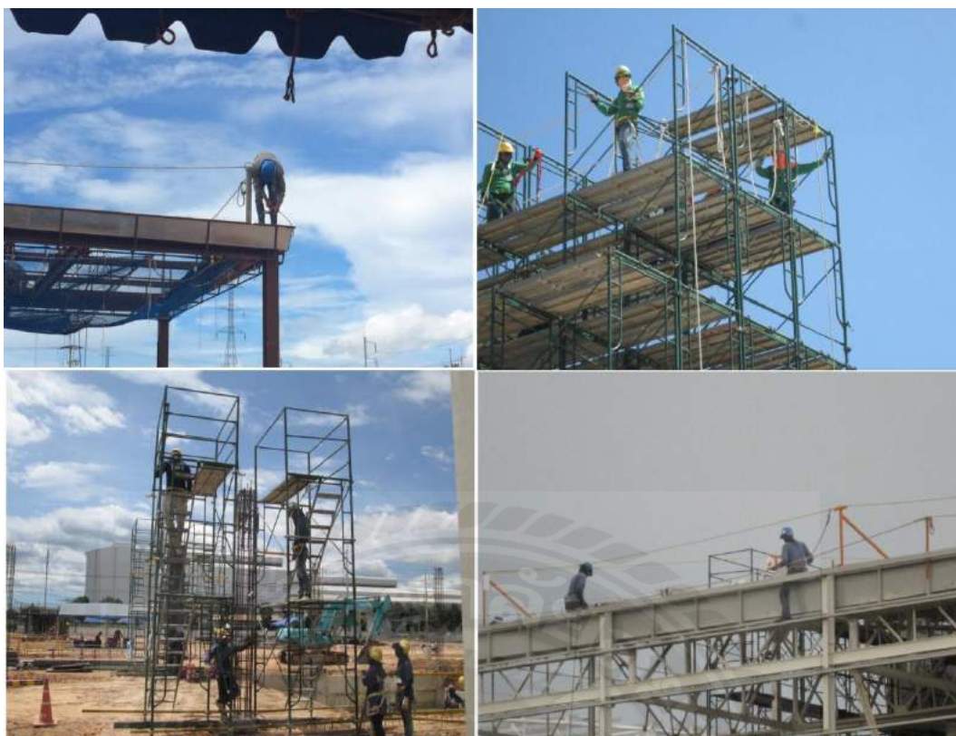
รูปที่ 4.11 ตัวอย่างอันตรายหรือสาเหตุของการเกิดอุบัติเหตุจากการตกจากที่สูง
