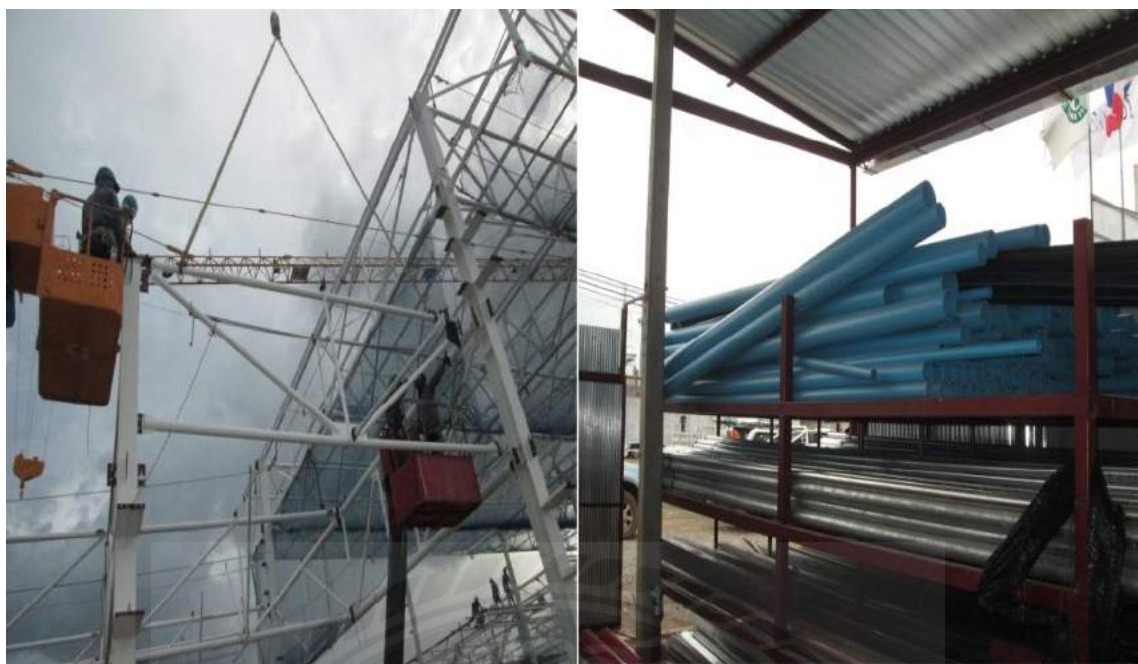
รูปที่ 4.9 ตัวอย่างอันตรายหรือสาเหตุของการเกิดอุบัติเหตุจากวัตถุหนักตกใส่
