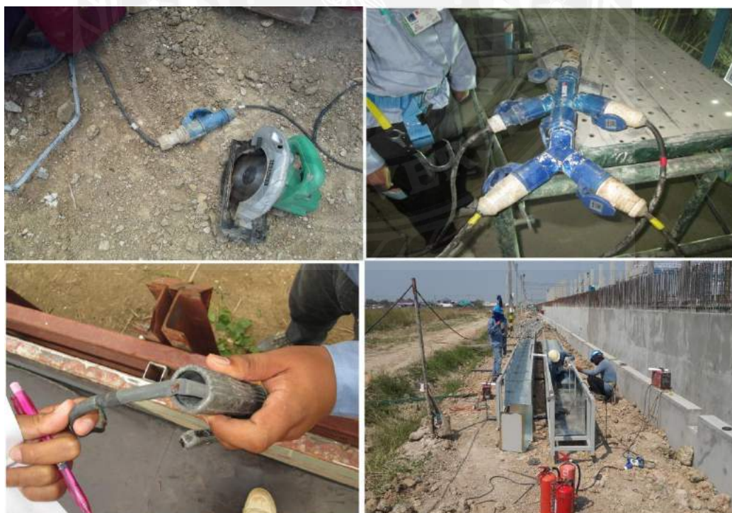
รูปที่ 4.12 ตัวอย่างอันตรายหรือสาเหตุของการเกิดอุบัติเหตุจากการกระแสไฟฟ้า
