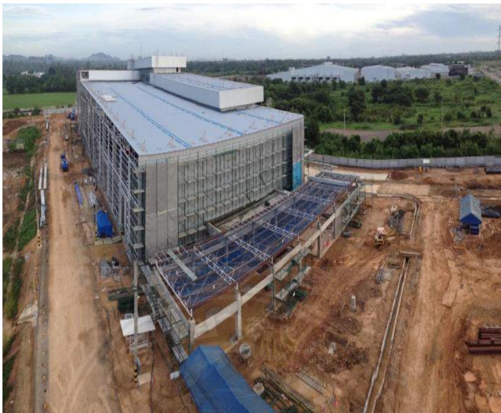
รูปที่ 4.1 โครงการก่อสร้างโรงงานหล่อขึ้นรูปเหล็ก
