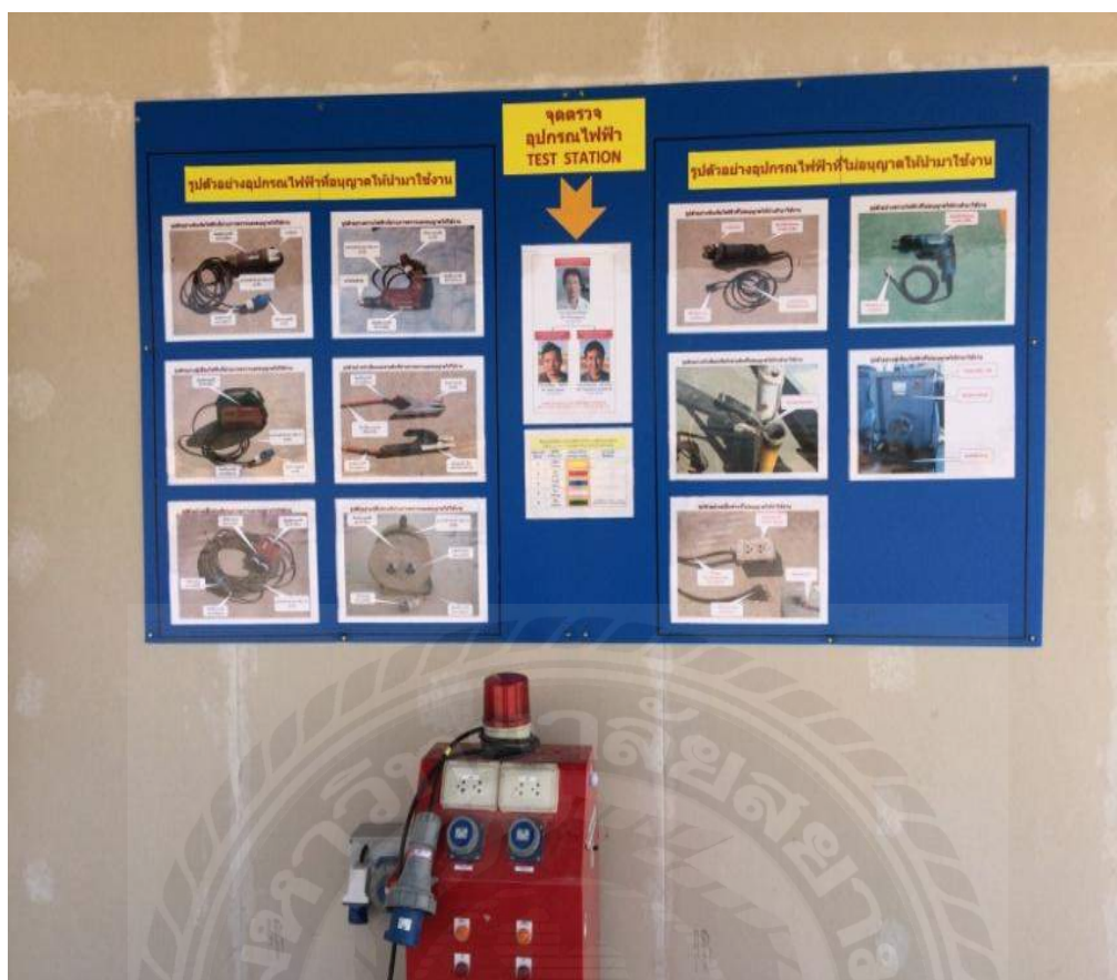
รูปที่ 4.21 บอร์ดตัวอย่างอุปกรณ์ไฟฟ้าที่ผ่านการตรวจและอนุญาตให้ใช้งาน
