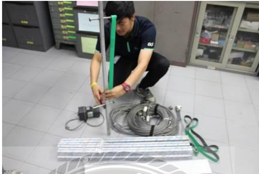
รูปที่ 3.8 ทำการต่อสายพานชุดลำเลียง
