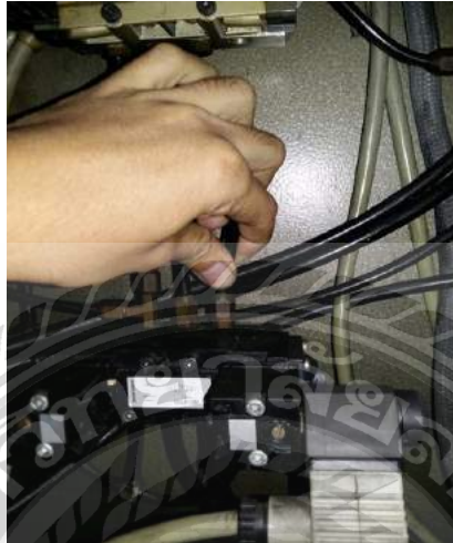
รูปที่ 3.3 ตรวจสอบระบบลม โซลินอยด์วาล์ว และข้อต่อสายลมต่างๆ
