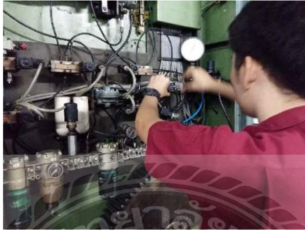
รูปที่ 3.5 กำลังทำการเปลี่ยนโซลินอยด์ วาล์ว ใหม่เข้าไป
