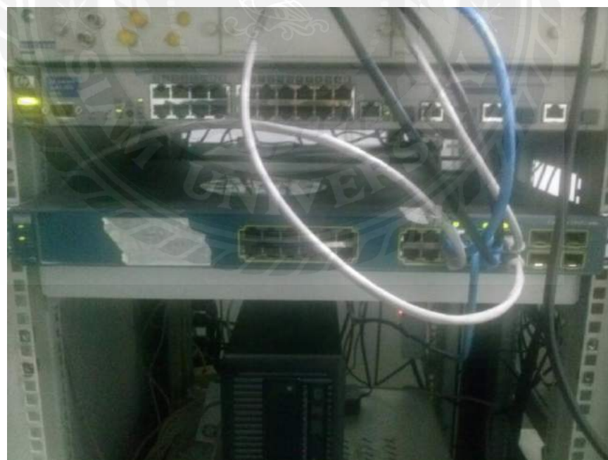
รูปที่ 3.10 สวิตช์ (Switch) ที่กองบังคับการตำรวจจราจร (บก.จร.)
