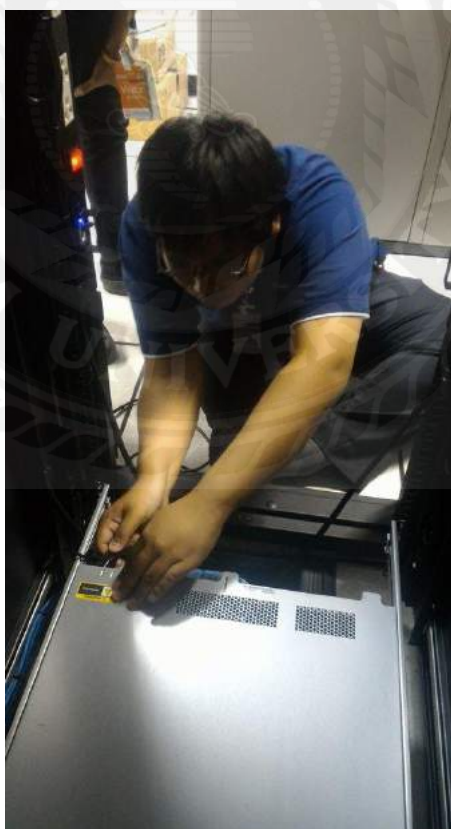
รูปที่ ก.3 ทำการจัดสายตู้ของเครื่องแม่ข่ายที่การไฟฟ้านครหลวงราชบุรีบวรณะ
