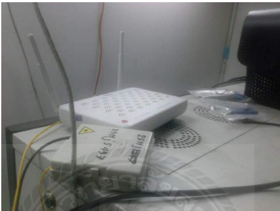
รูปที่ 3.9 เราเตอร์ (Router) ที่กองบังคับการตำรวจจราจร (บก.จร.)
