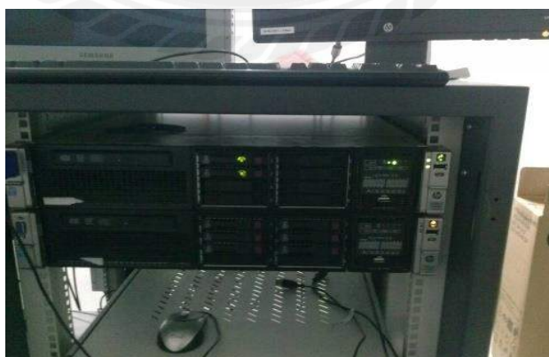
รูปที่ 3.8 เครื่องแม่ข่ายที่กองบังคับการตำรวจจราจร (บค.จร.)
